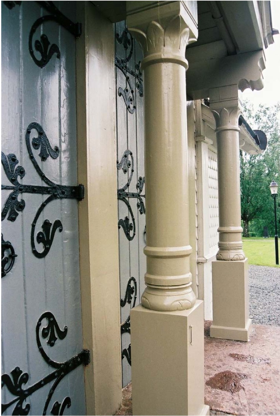
Bild 20. Stolpen efter ilagning och målning (neg nr 08M023/27).
