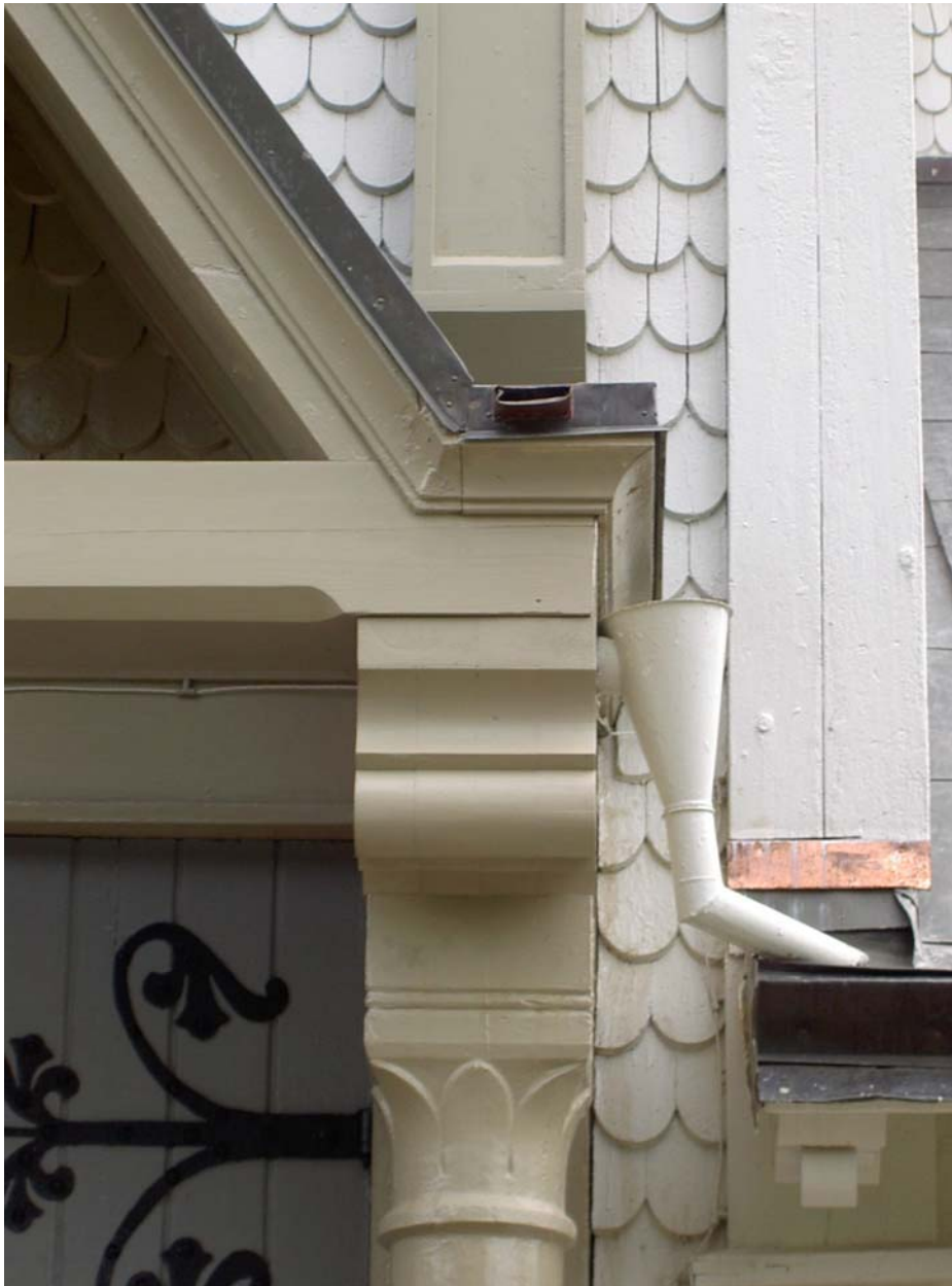
Bild 18. Vattenutkastaren längst till höger. Bakom syns även plåtförstärkningen ovanför takfoten (digital bil pict 6541).
