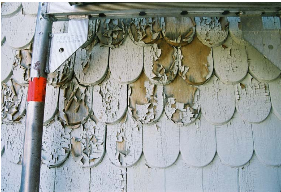
Bild 3. Färgen flagade på många ställen innan ommålning. Den äldre rosa färgsättningen syntes tydligt på vissa ställen (neg nr 06M029/17).
