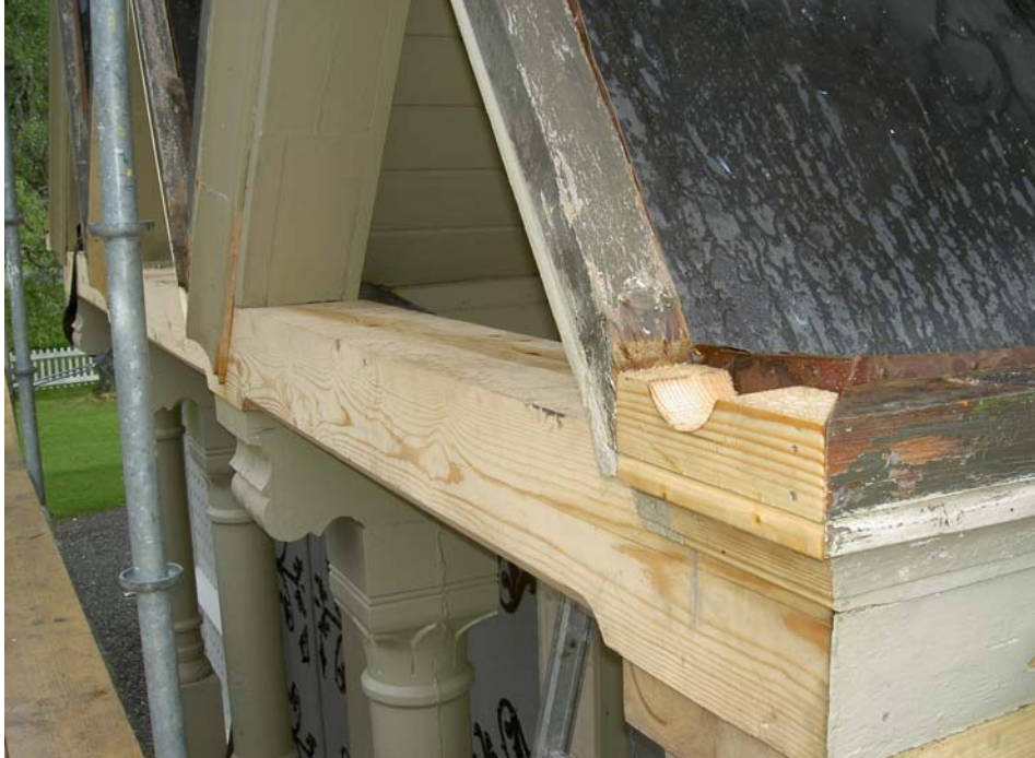
Bild 15. Den nyttillverkade balken (digital bild pict 5992).
