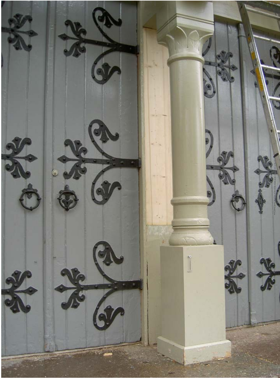
Bild 19. Ilagning i andra stolpen från höger (digital bild pict 6007).
