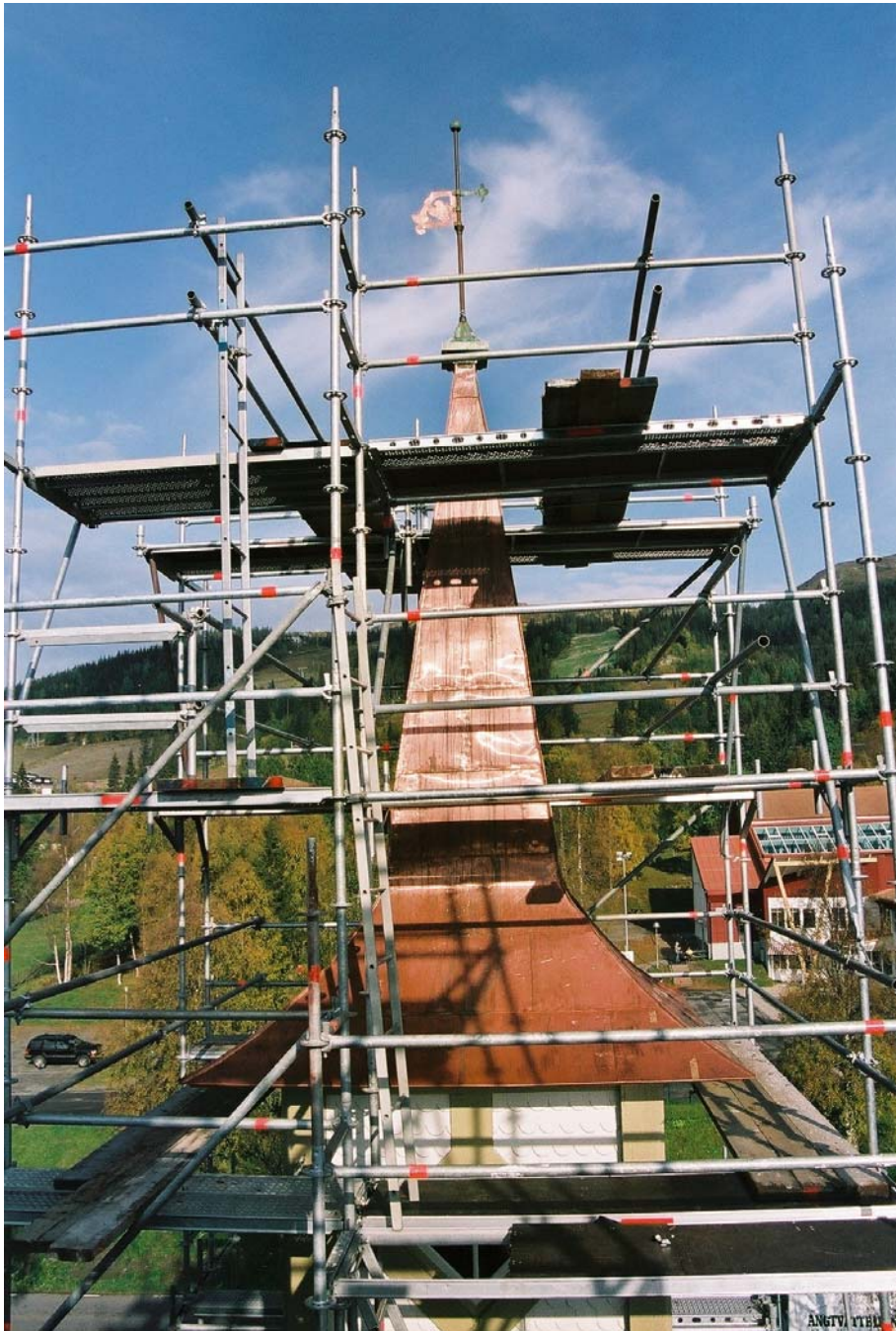
Bild 12. Långhusets båda torn fick nya plåttäckningar av koppar, här det norra (neg nr 06M071/32).
