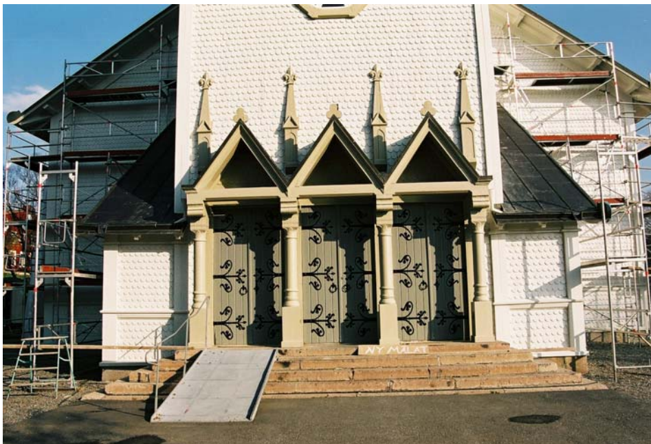
Bild 11. Entrén vid slutbesiktningen av etapp 1 med de åtgärdade dekorationerna på fasaden och de nya taksparrarna på sidan om entrén (neg nr 06M72/2).
