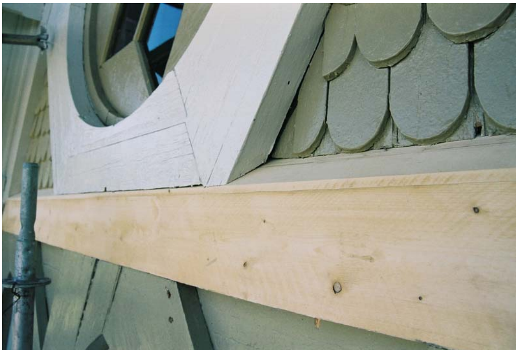
Bild 5. Den utbytta bjälken och listen ovanför ljudluckorna (neg nr 06M087/29).
