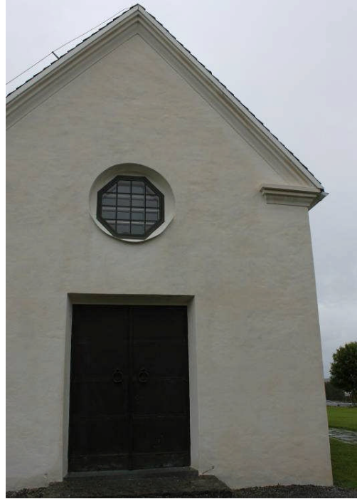
Bild 5. Vapenhuset efter restaureringen. Fasaden omputsad, vindskivorna åtgärdade och fönstret nymålat.
