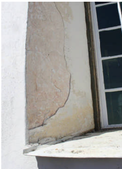
Bild 9. I fönsternischerna syntes rester av tidigare putslager, underst en röd och över en gul.
