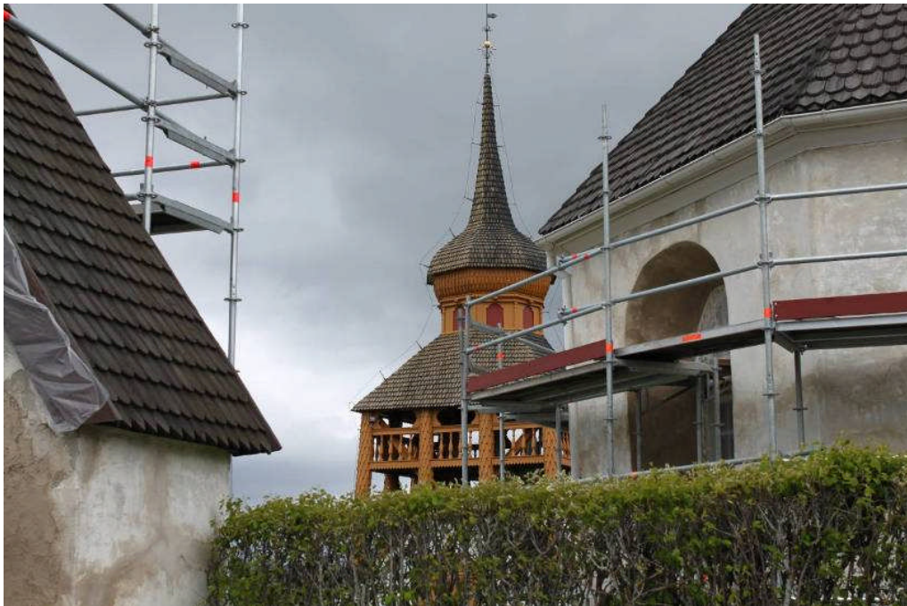
Bild 2. Omputsning av fasader. På stigporten i förgrunden läggs ytputsen på.
