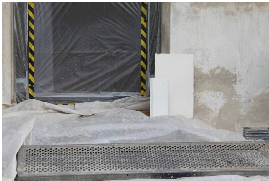
Bild 11. Färgprover gjordes på både puts och trädetaljer. Fönster och dörrar skyddades av plast när fasaderna putsades om.
