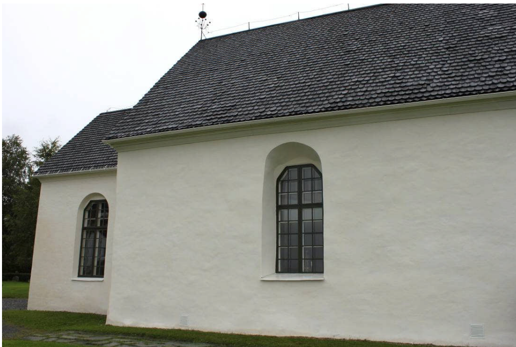
Bild 20. Södra fasaden när restaureringen är klar.
