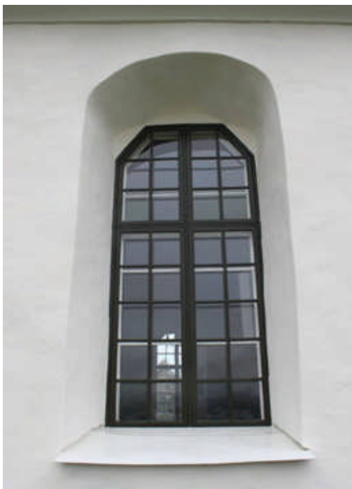
Bild 18. Fönsternisch efter restaureringen. Ny puts, fönster och solbänk är målade.
