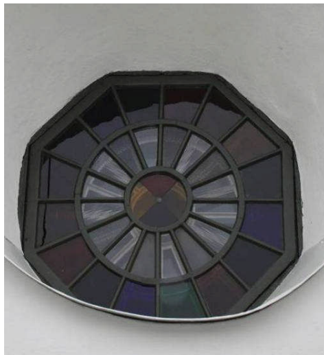
Bild 13. Åter på plats med delvis nya glas samt nymålade spröjs och båge.
