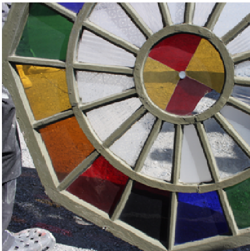
Bild 12. Några av rosettfönstrets glas var trasiga och byttes ut. Glas med liknande etsade mönster gick inte att få tag på.
