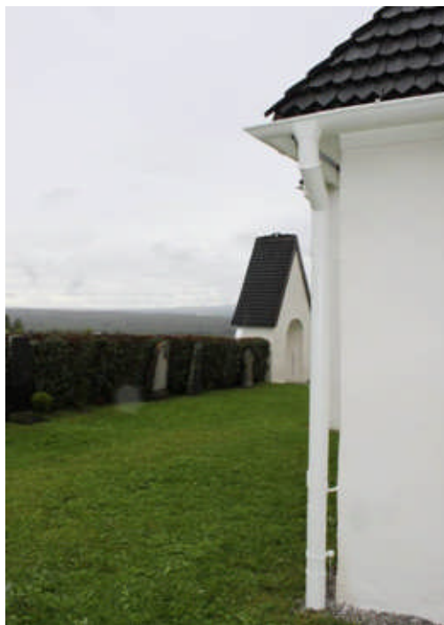
Bild 19. Kyrkobyggnadens hängrännor och stuprör åtgärdades. Stigporten syns i bakgrunden.
