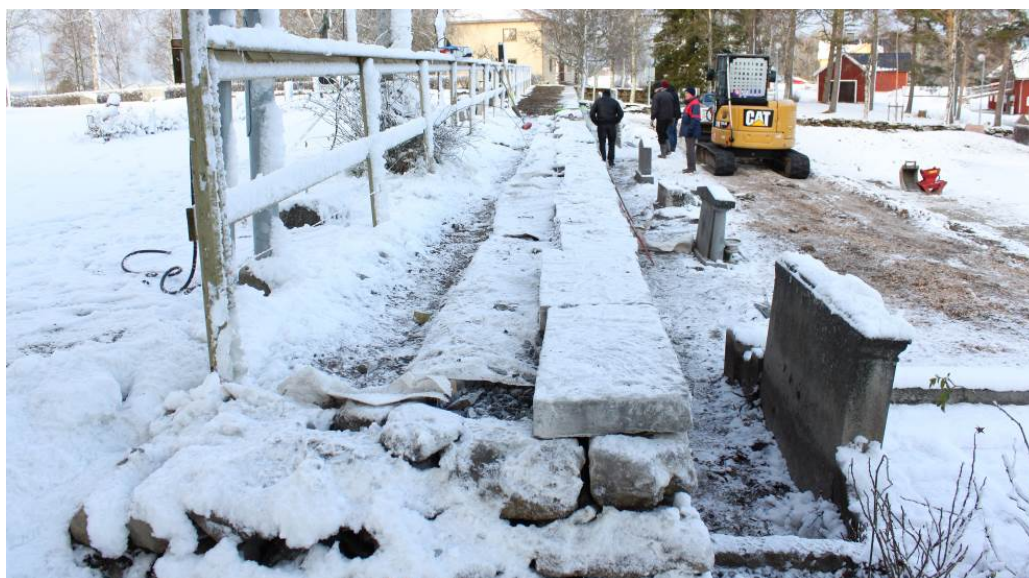
Trots snö på bilden kan vi här se hur geotextilen som lagts mellan makadam och jordschaktet vikts över makadamfyllningens överkant och fästs under krönstenarna.
