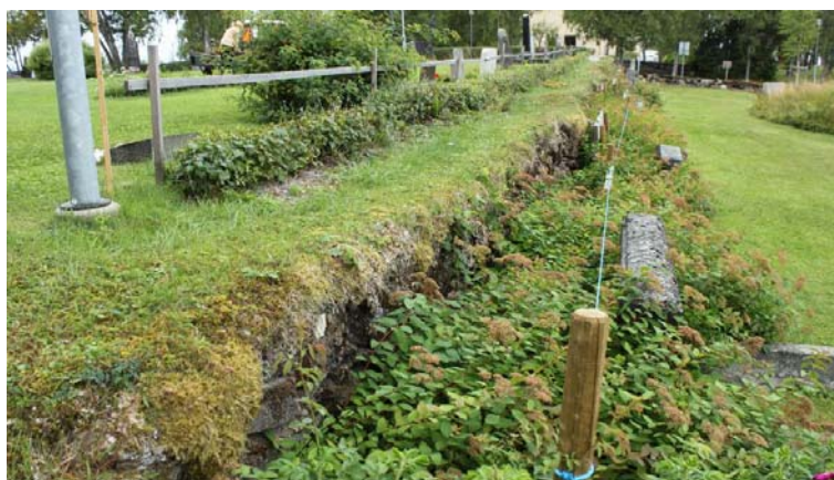
Muren var på översidan överväxt med mossor och gräs, buskage växte framför.
