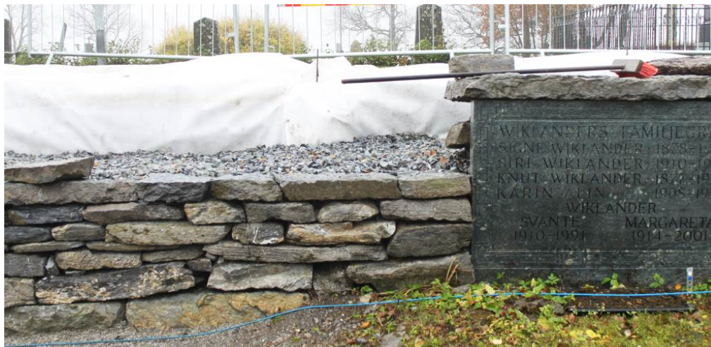
Den nyuppförda muren går fram till den del där gravhällarna är placerade.
