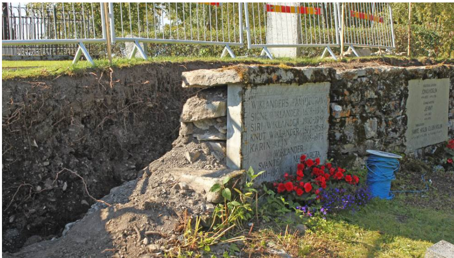
Muren har demonterats förutom den borte delen mot väster.
