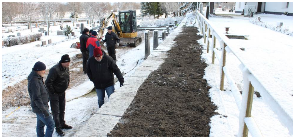
Krönstenar har lagts som avslutning på muren, jord har fyllts på fram till stenens kant.
