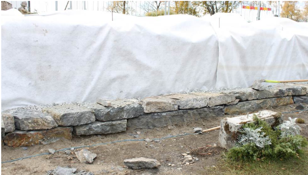
De två nedre skiften är lagda med större och flatare stenar som hämtats från Brunflo.
