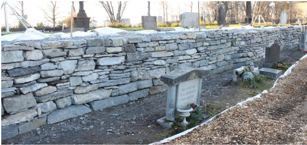
Muren är nästan färdigbyggd, sista skiftet kvarstår.
