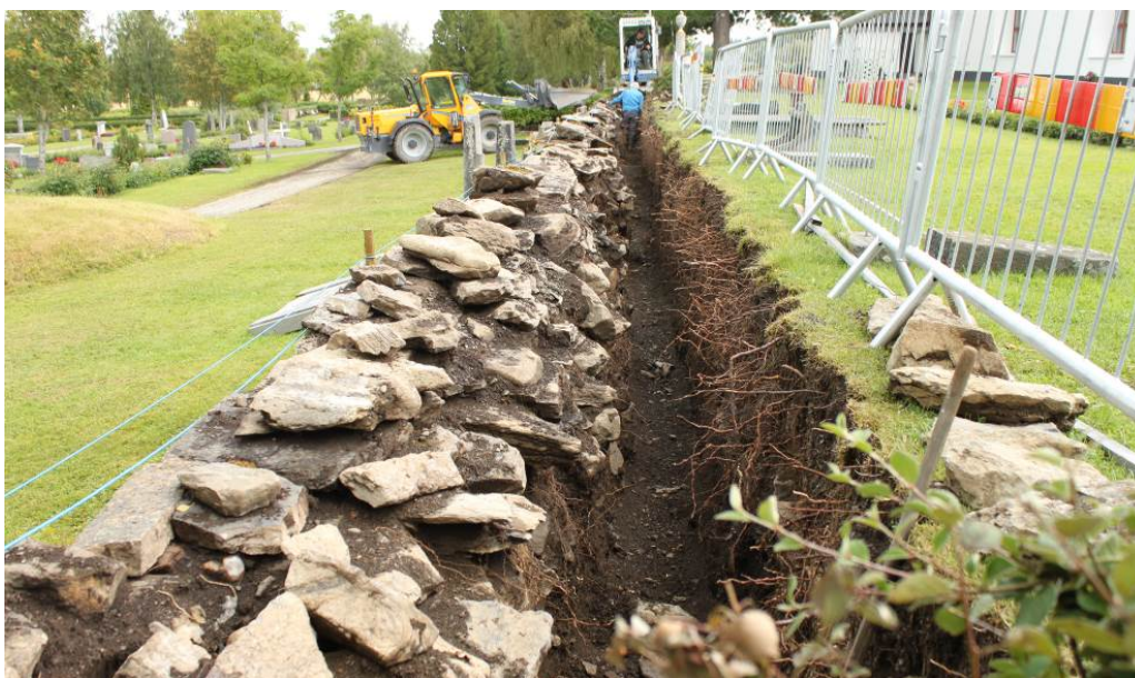
Arbetet har påbörjats, först grävdes ett schakt längs hela murens baksida.
