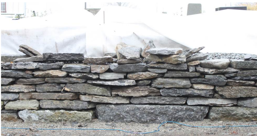
Flera skift har nu lagts, större och längre stenar har varvats med kortare och mindre.
