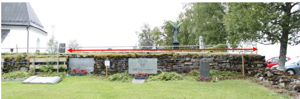
Nordvästra delen var lagd i jämnare skift med flatare stenar i jämförelse med den övriga sträckan av muren.
