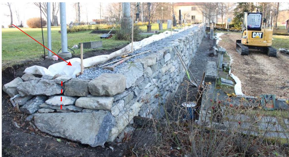
Murens utseende innan krönstenen läggs på. På bilden skymtar överdelen av den skiva som Toréns AB lagt in för att skilja makadam och matjorden åt för att försäkra sig om att få tillräckligt planteringsdjup för den kommande häcken. Se pil och streckad linje.
