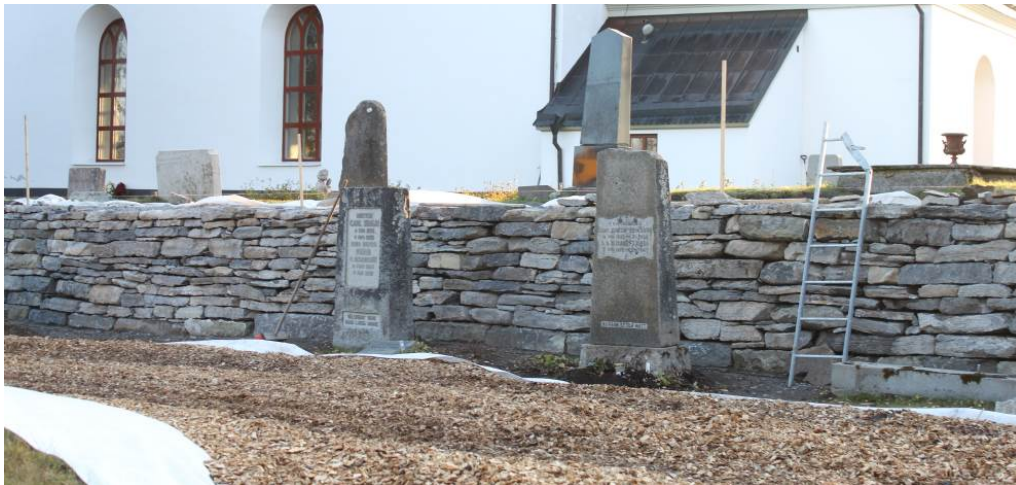
Muren är nästan färdigbyggd, sista skiftet kvarstår.
