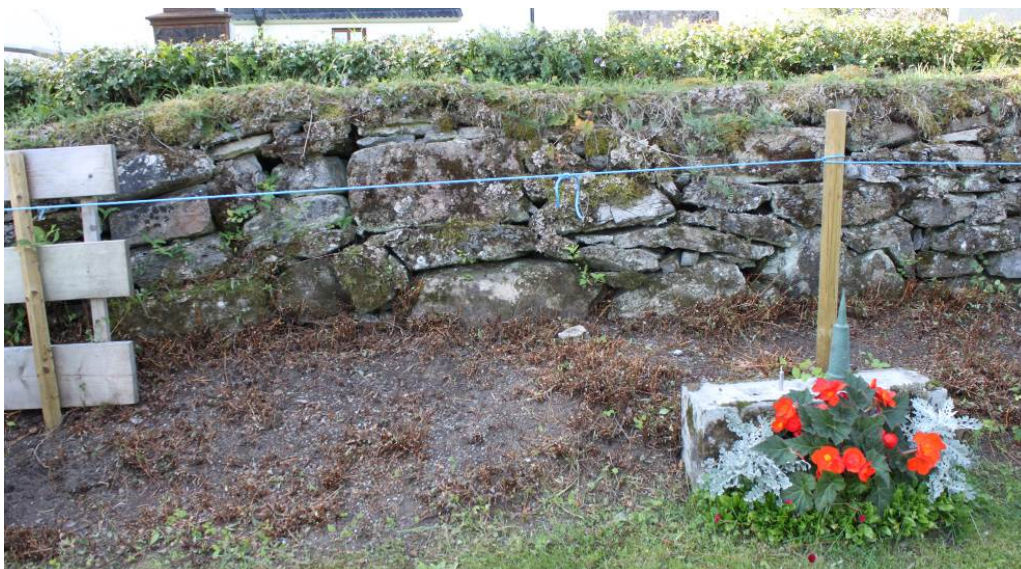
Här har häcken tagits bort. En mindre jordvall har under åren byggts upp mot murens nederkant.
