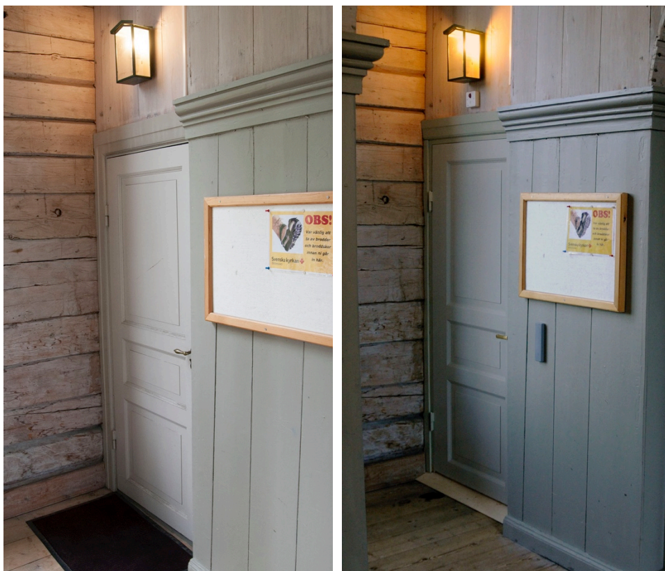
Smalare dörröppning före ombyggnad.
