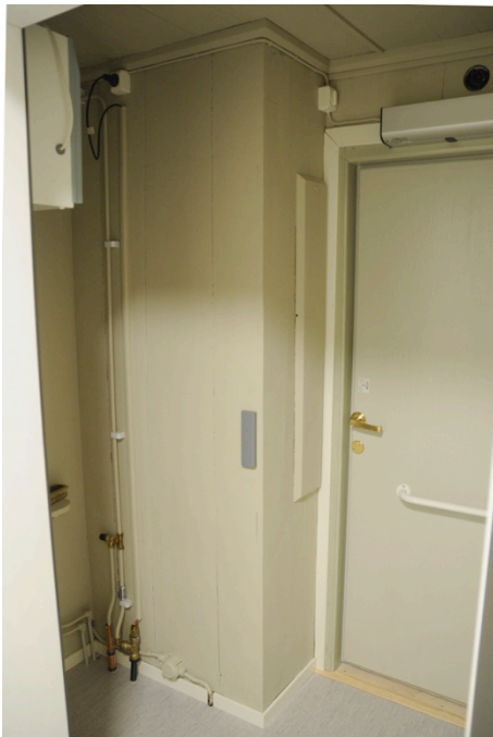
Förrum till RWC efter ombyggnad. Till vänster om dörren syns både den nytillverkade luckan och dörröppnarens armbågskontakt.
