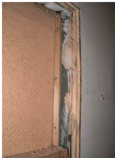
Håltagning för den nya dörröppningen. Färgspåren i mörkgrönt visar den tjockare delen av väggen närmast timmerstommen.
