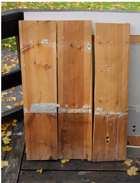
De ursågade väggbrädorna med rester av den pappspänning som före 1950-talets ombyggnad var in mot kyrksalen.
