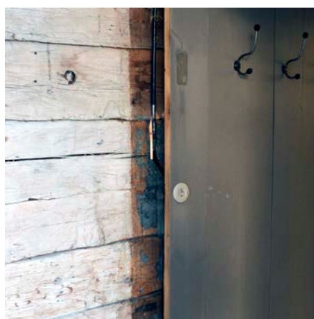
Panel 1953, bakom panelen syns rester av den lumpapp som tidigare suttit på vapenhusets timrade yttervägg.
