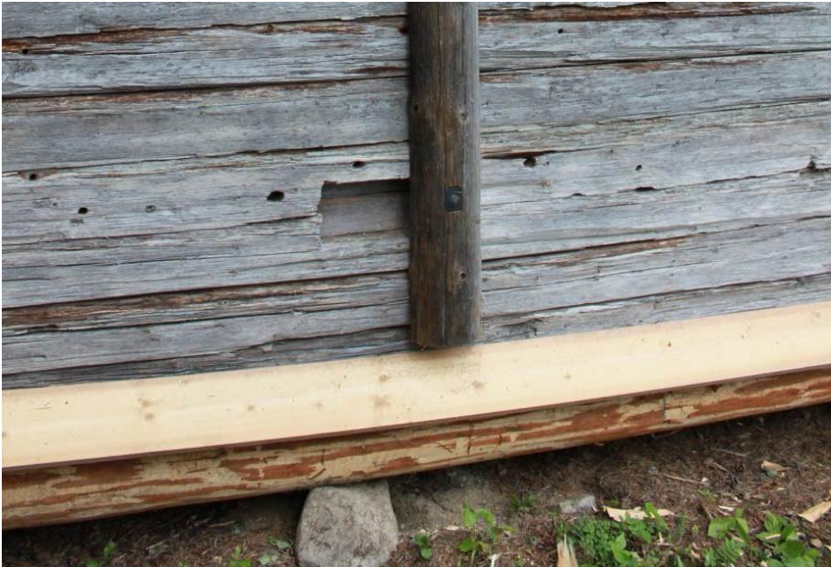
Figur 4 C-väggen riktades upp och en följare monterades. En snedställd bräda har fästs i C2 som skydd över golvklovnarnas ändar.
