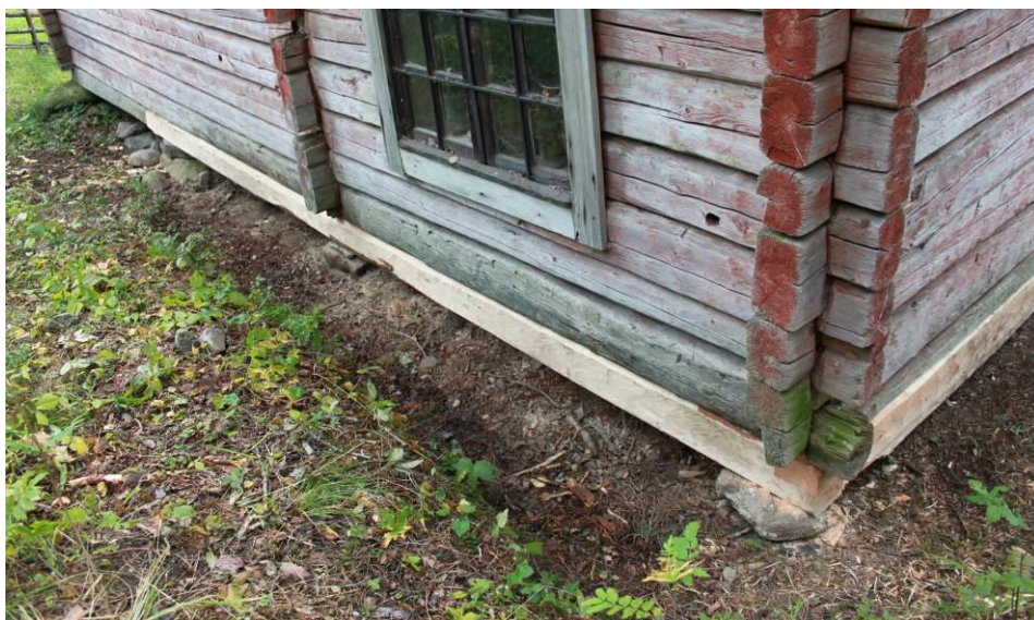
Figur 8 Syllen C1 på gårdsmuseet byttes till största del ut (lägg märke till skarven på syllen mellan E och CD-knut).
