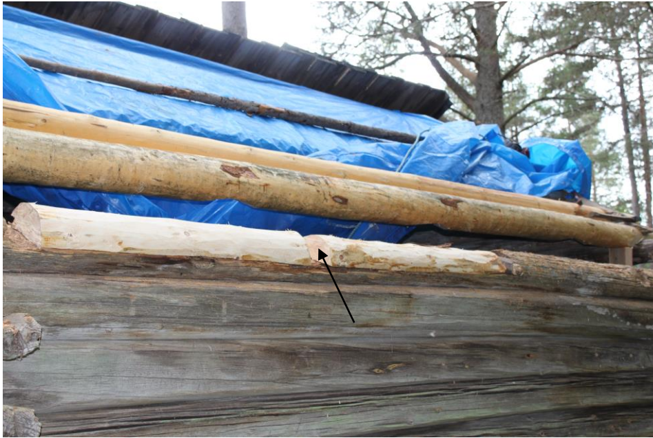
Figur 5 D12 ilagades med nytt virke (lägg märke till urtagen för raftkrokarna).
