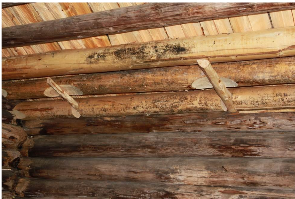
Figur 1 D-vägg. Åsarna 1, 2 och 3 (nerifrån räknat) är utbytta. I åsarna 1 och 2 är uthugget för raftkrokarna.
