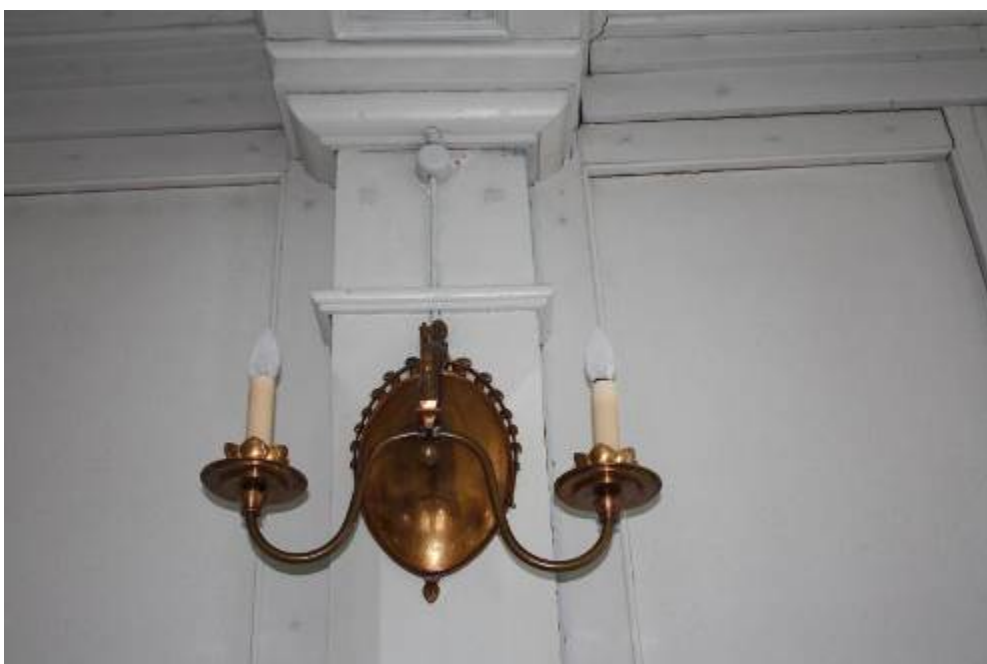
Nya elkablar och kulodosor är dragna till samtliga lampetter på läktarna, totalt åtta stycken. IMG_019 Foto: Olof Edin
