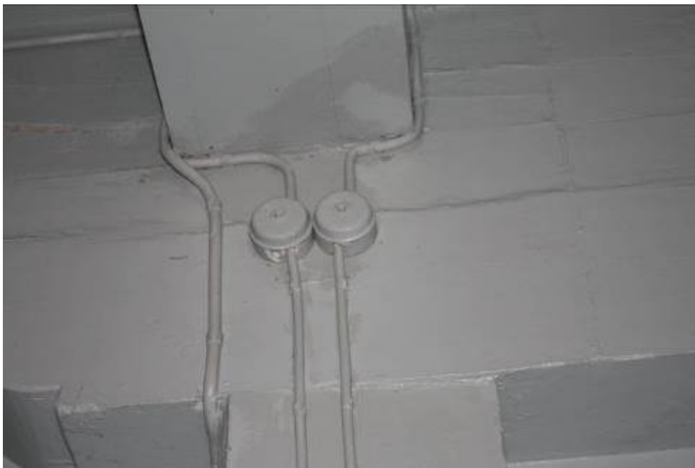
I vapenhuset är nya kopplingsdosor s.k. kulodosor av porslin, elkablar och strömbrytare monterade. Inmålningen utfördes av Per Halvarsson. IMG_005 Foto: Olof Edin
