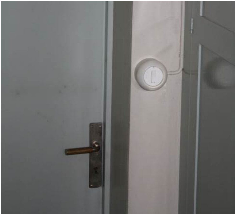
Strömbrytarna har också de målats in. Detsamma gäller för kablar, kopplingsdosor och strömbrytare i det lilla köksutrymmet som ligger i anslutning till koret. IMG_059 Foto: Olof Edin
