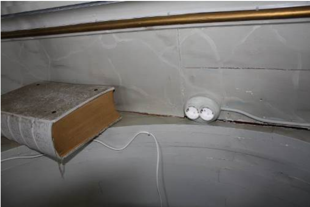
Predikstolen har fått ett nytt eluttag samt kabeldragnig. IMG_051 Foto: Olof Edin
