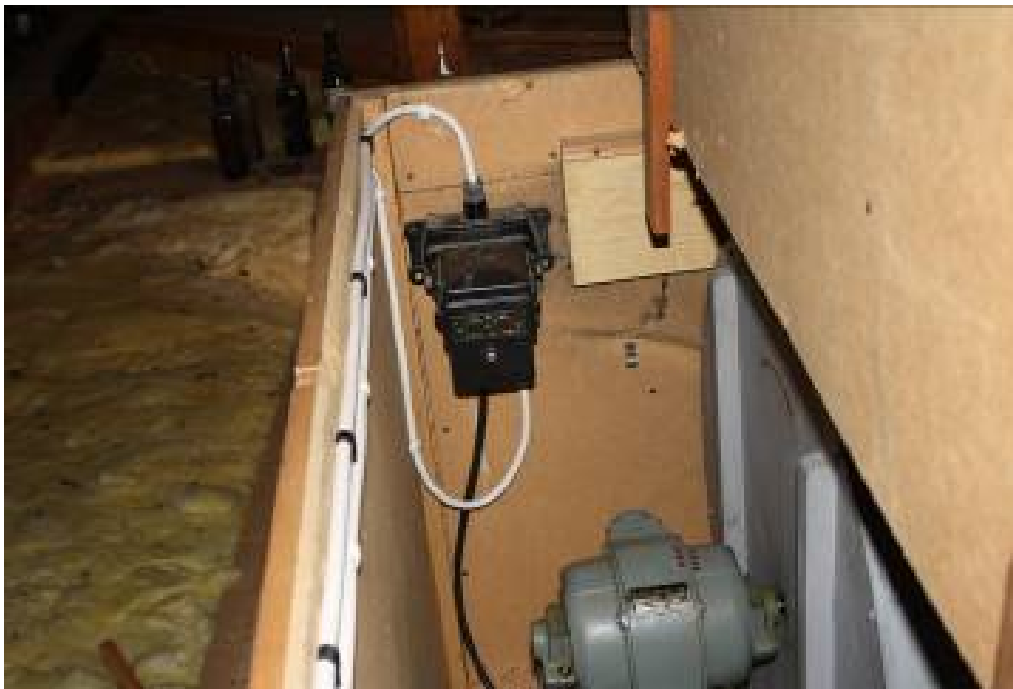
Orgelfläkten står uppe på vinden, här med nya elkablar. IMG_016 Foto: Olof Edin
