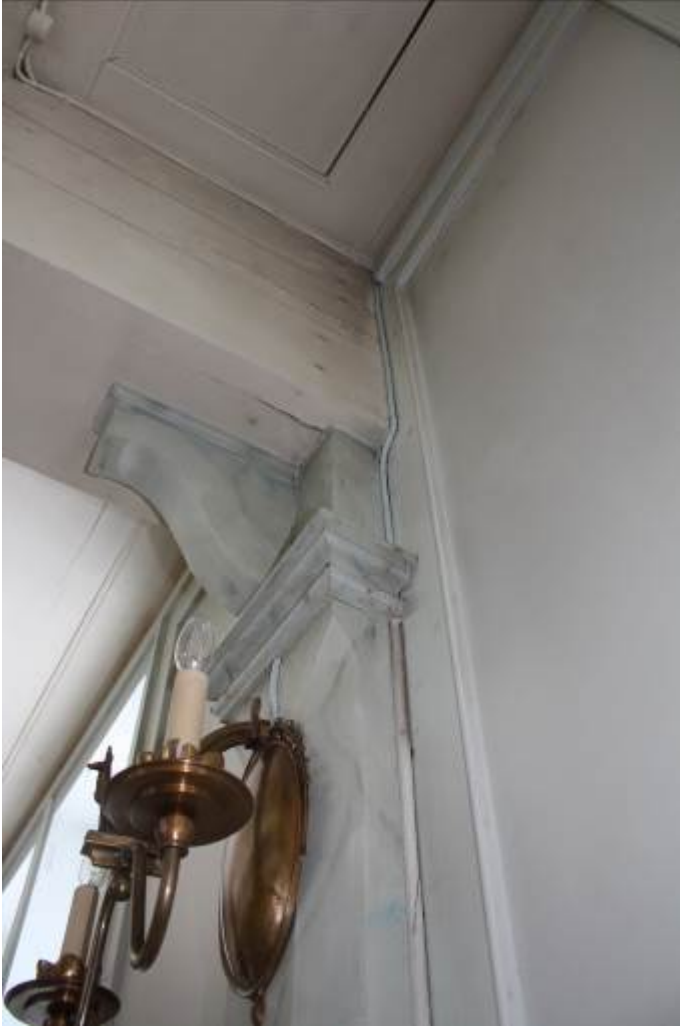
Här ses en av kabeldragningarna till lampetterna i långhuset och dess inmålning. Sammanlagt finns det åtta stycken lampetter i kyrkans långhus och alla har fått nya kabeldragningar gjorda och blivit inmålade. IMG_035 Foto: Olof Edin
