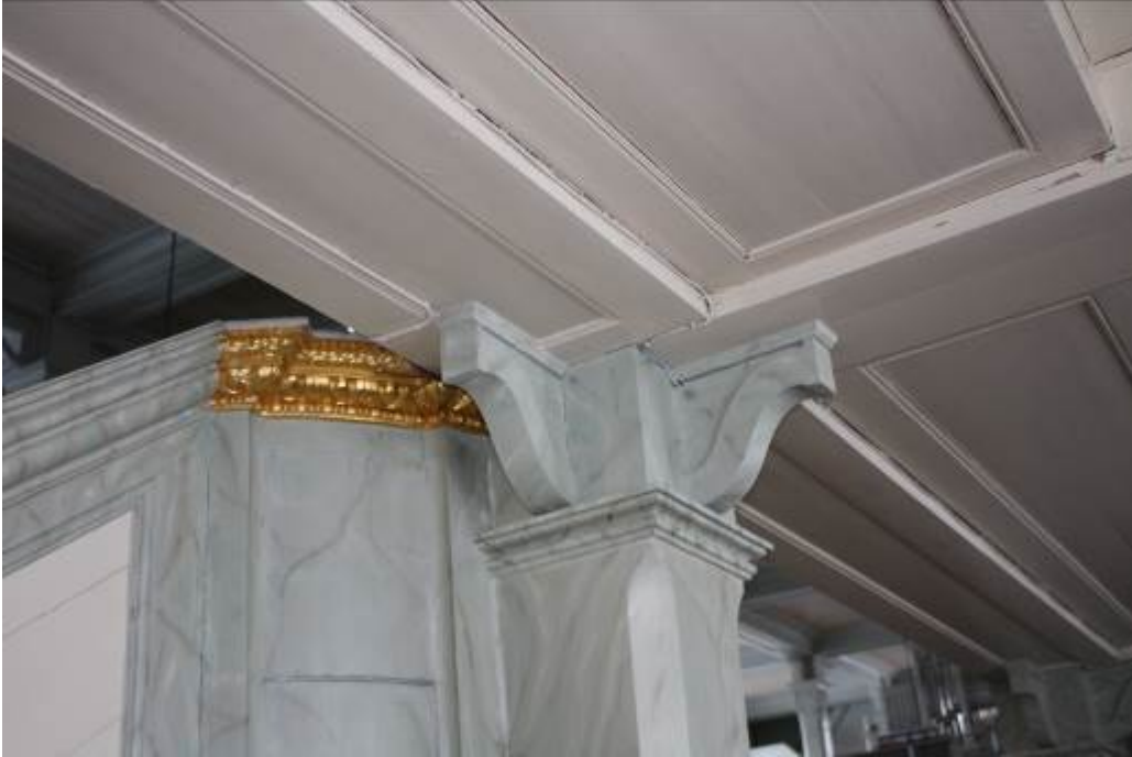
Klockringningskabeln har tagits bort från predikstolen, nya kablar har ersatt gamla och målats in i en för underlaget passande kulör, NCS S 1510 – Y10R. IMG_048 Foto: Olof Edin
