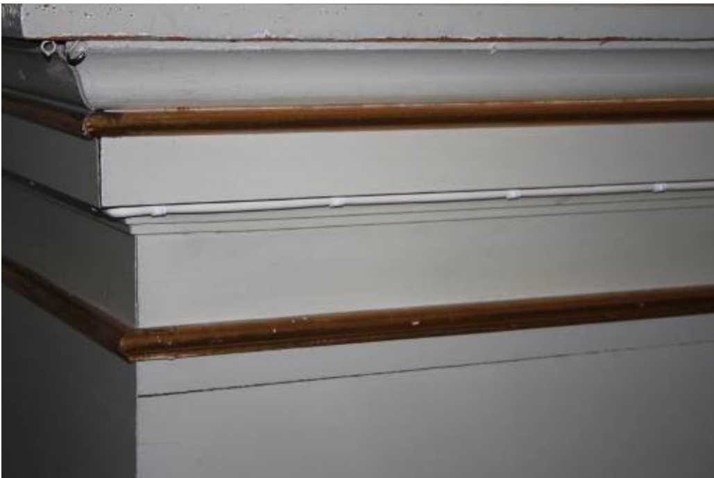
På altaret har en ny kabel fäst längst med altarets listverk. IMG_054 Foto: Olof Edin
