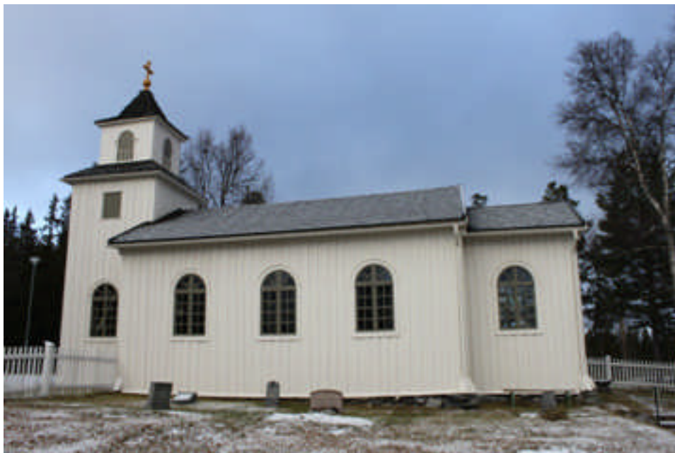
Den nymålade södra långväggen.
