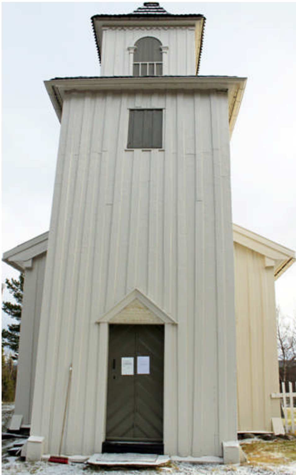
Västtornet efter ommålning. Port och tornluckor målade i samma kulör som fönstren.
