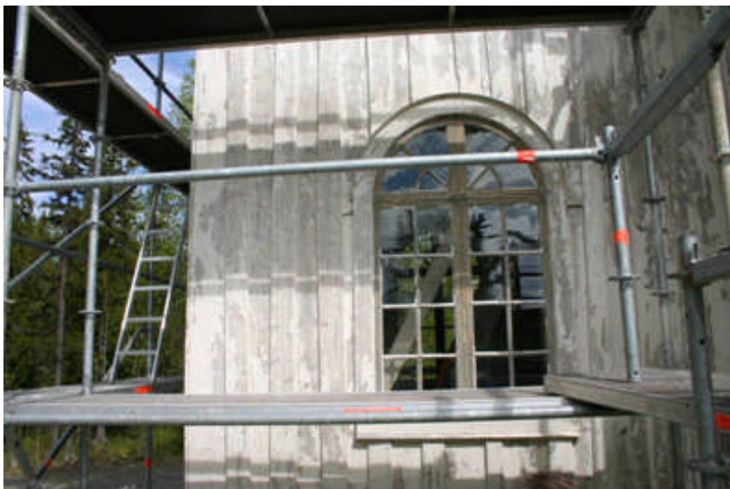
Tornets södra vägg efter grundning
