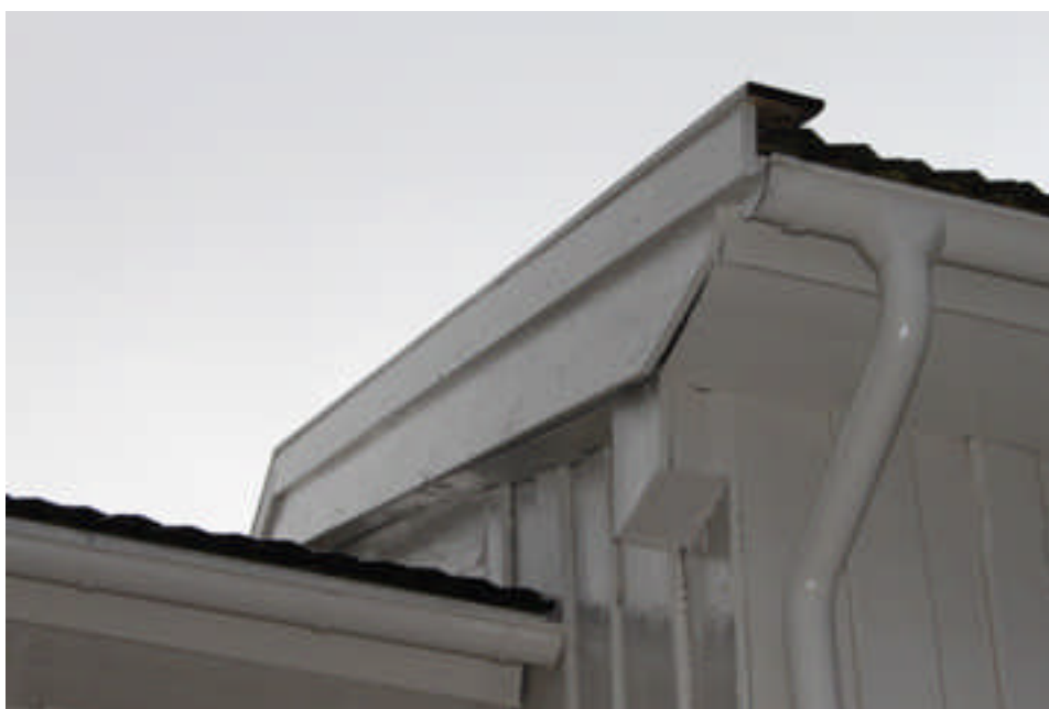
Hängränna och stuprör efter målning med linoljefärg.
