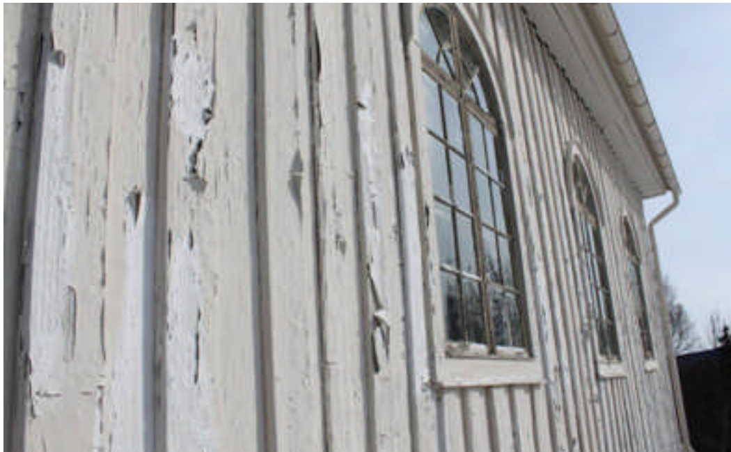
Fasaden innan åtgärder.
