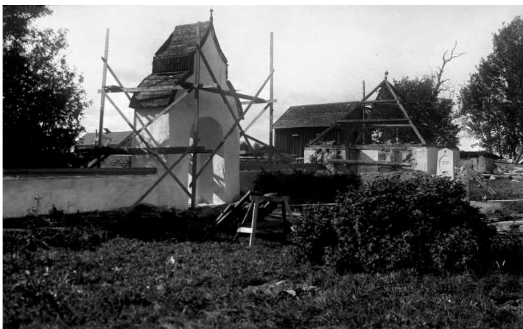
Bild 11. Södra stegporten och bårhuset under pågående restaureringsarbete sommaren 1932. C147
