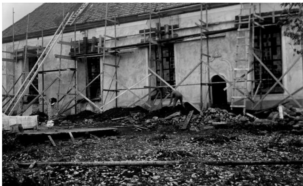
Bild 9. Södra långhusets vägg under pågående upprättning tidig höst 1932. Jamtli arkiv C155
