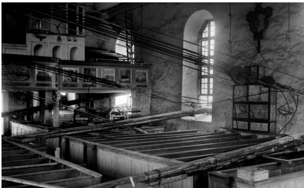
Bild 10. Vajerspelet inne i kyrkan under pågående upprätning av södra väggen 1932. Jamtli arkiv C143
