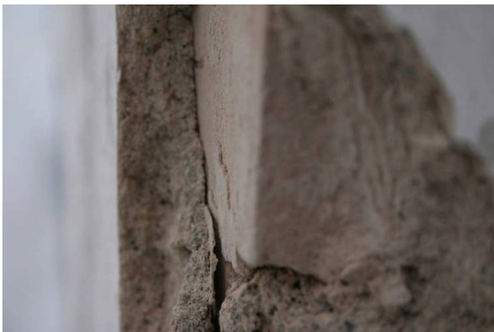
Bild 13. Under den yttersta ljusgrå putsen hittades ett äldre putslager av gulaktig puts. Putsprovet från det äldre lagret fick nummer 6. Foto Christina Persson 2008-12-03
