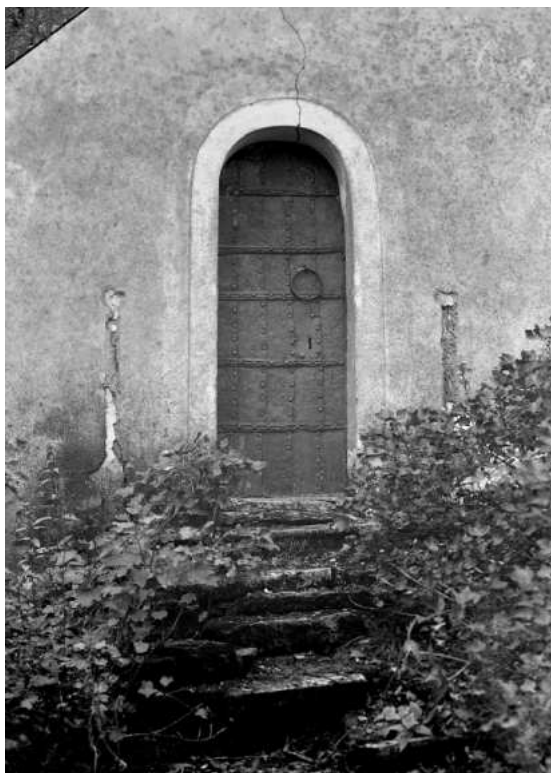
Bild 3. Saknästians ingång sett från väster före restaureringen. Jamtli bildarkiv C1237
