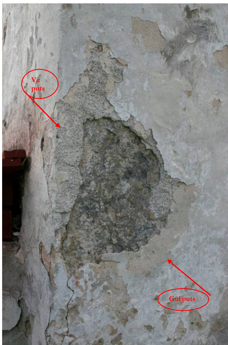
Bild 16. Den södra stegportens östra sida. Puts lagret är tunt mot stenen. Foto Christina Persson 2008-12-03
