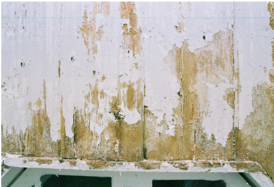
Pågående färgborttagning. Jlm 07m035/35
