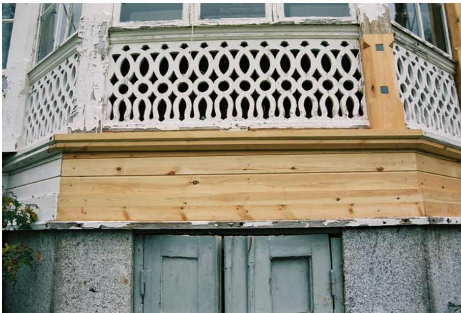
Bild 6. Mot sylvarvet är tre liggande spåntade brädor spikade i nedersta våningen. Ovanpå dessa ligger golvfrisen (neg nr 06M072/12).
