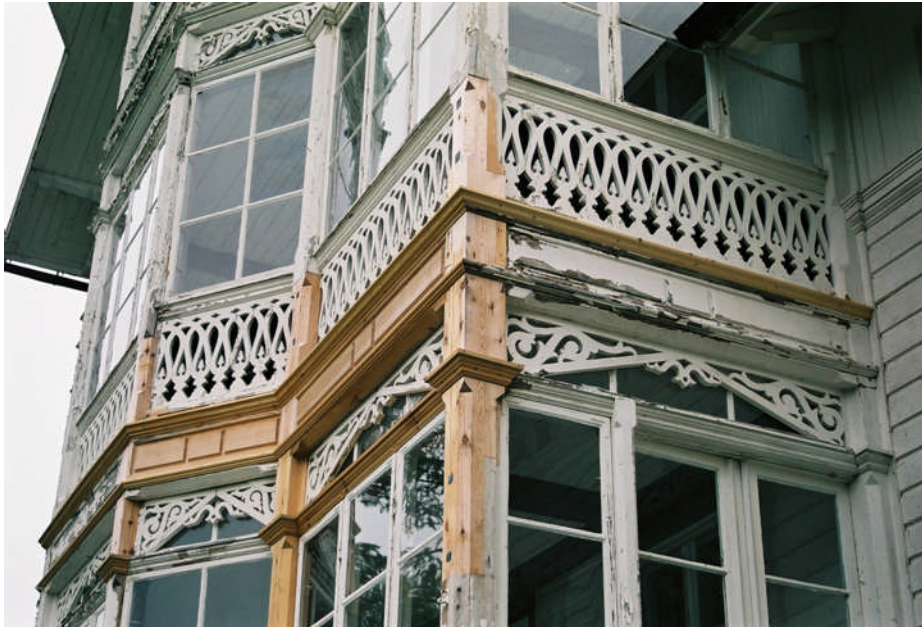
Bild 9. Här syns bl.a. bladskarvningen av stolpe 1 och listen ovanför dekorbrädan som byttes mellan ytterväggen och stolpe 1.
