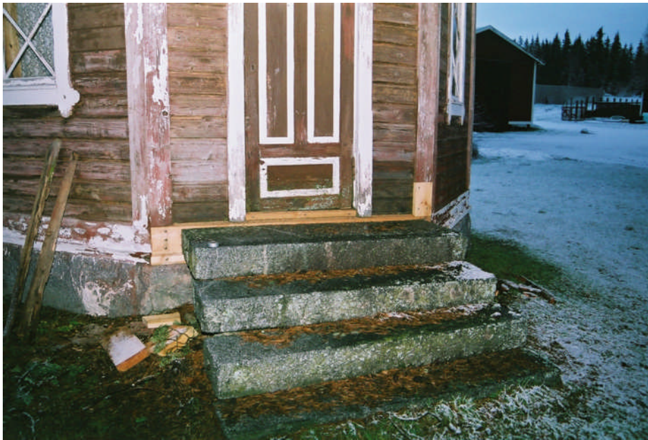
Bild 13. Lagningar av sockelbrädan och knutbrädan vid dassets A-vägg (neg nr 07M004/25).
