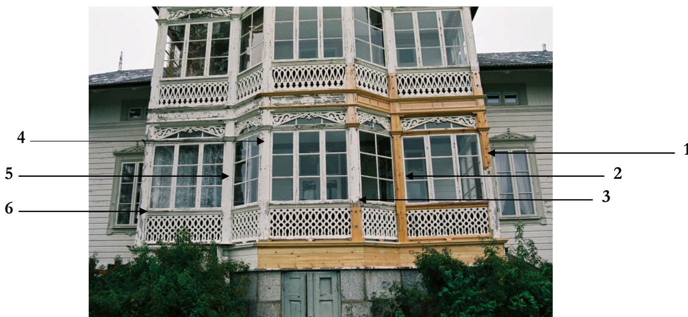
Bild 4. Ilagningar i verandan på C-väggen med stolparna numrerade (neg nr 06M072/11).
