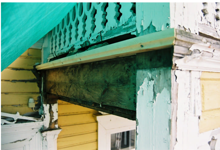
Bild 12. Listen i andra våningen efter byte. (neg nr 07M004/
