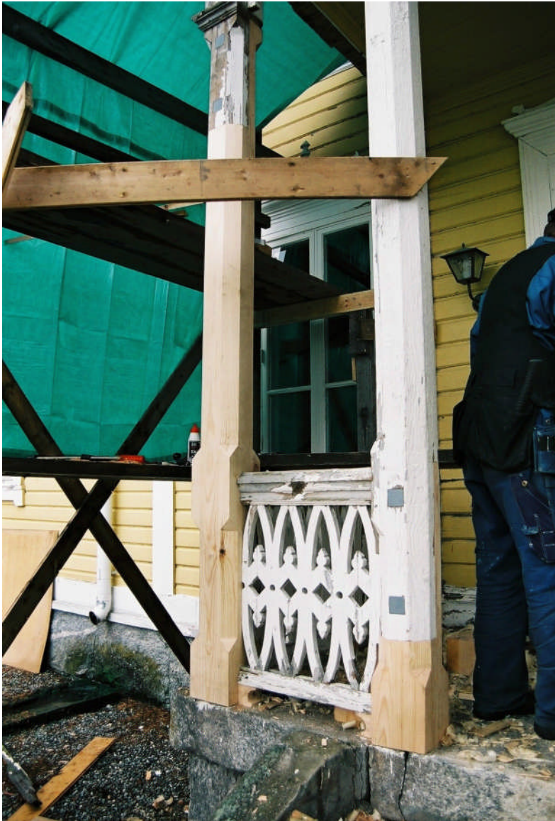
Bild 10. Stolpe 2 och 3 ilagades halvt i halvt och bultades (neg nr 07M004/
