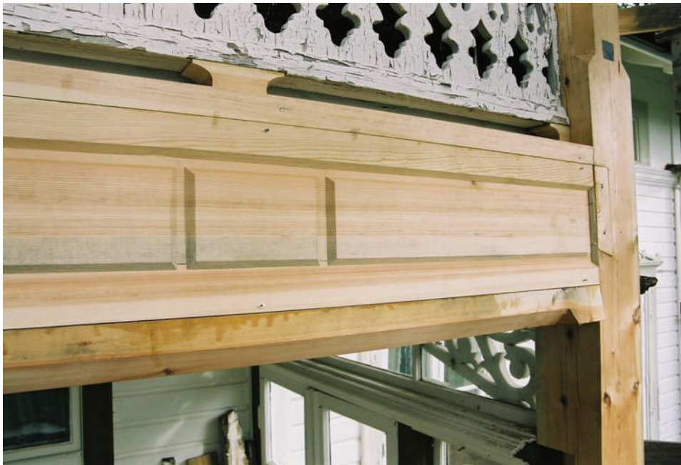
Bild 7. I mellanbjälklaget täcktes de bärande bjälkarna av dekorbrädor. Detta är dekorbrädan mellan stolpe 1 och 2. Den övre och under listen har inte monterats ännu.
