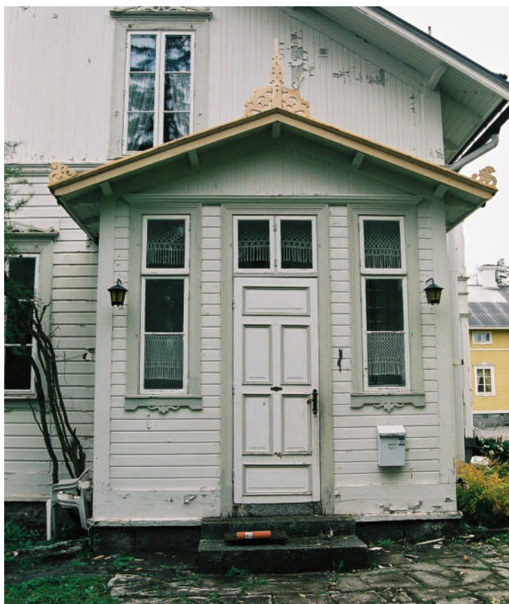
Bild 3. Köksingången på B-väggen med nytillverkat lövsågeri, vindskivor, överliggare och hålkäl (neg nr 06M072/25, något beskuren). Stuprören är ännu inte monterade.
