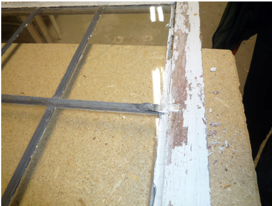
Fönsterbåge med blyspröjs under restaurering
