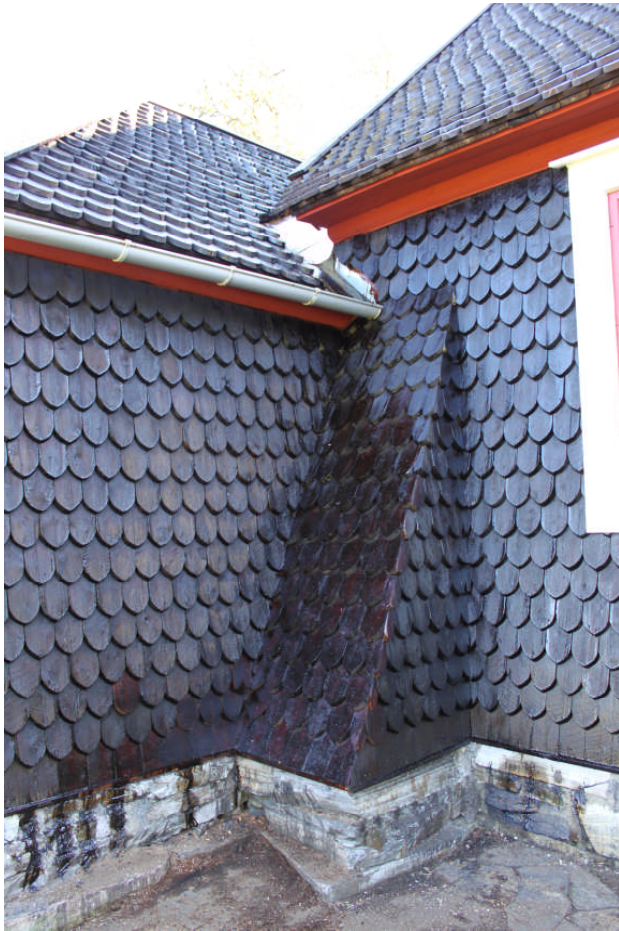
Kontrefor vid sakristia på norra fasaden efter lagning och tjärning
