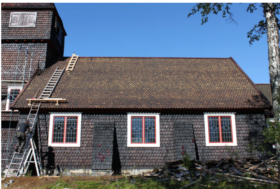
Nya spån på södra takfallet
