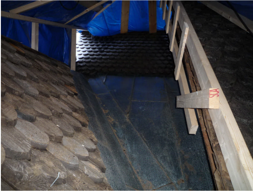
Under pågående arbete med plåtvtäckning vid sakristia, kor, långhusgavel
