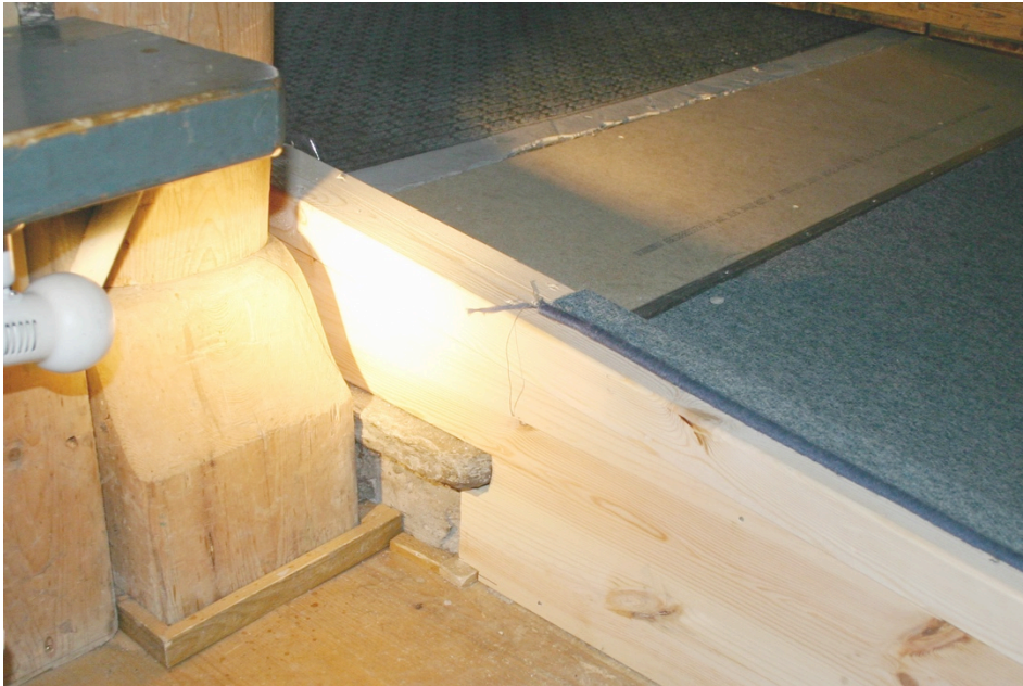
Den nya rampen och hur den byggs in mot stentrappan.
