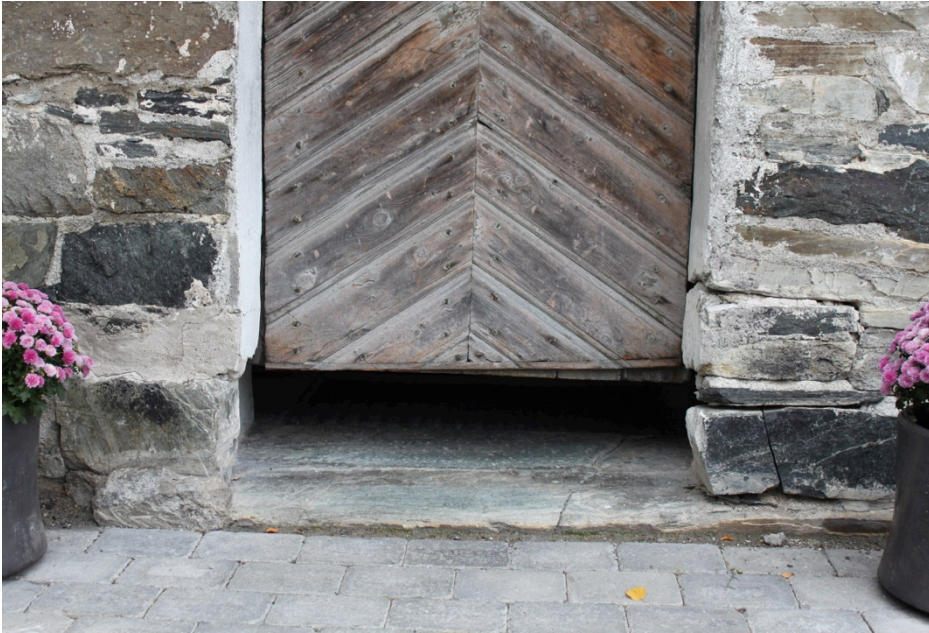
Dörröppningen utan tröskel men innan dörrbladet var förlängt. Trappstegen som fanns utanför dörren har också tagits bort.
