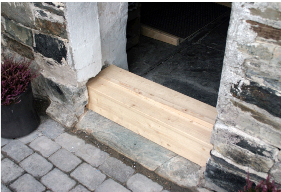
Tröskelstenen togs bort innan det var utrett exakt hur entrén skulle se ut. Därför byggdes en provisorisk och löstagbar tröskel. Under en tid var det tänkt som en varaktig lösning innan man beslutade och fick tillstånd till att förlänga dörrbladet.
