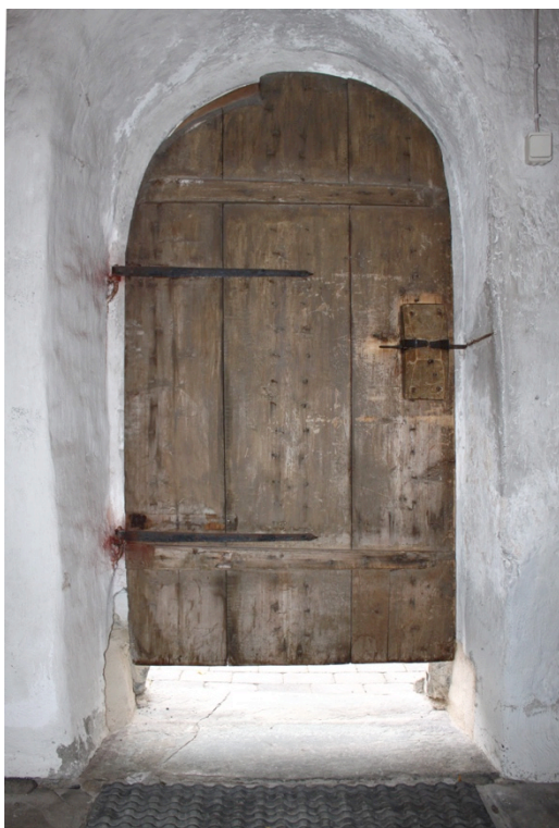
Dörrbladet före påbyggnad samt detaljbild av nedre delen av den gamla dörren. Lägg märke till att listen som senare togs bort inte är synlig på detaljbilden.
