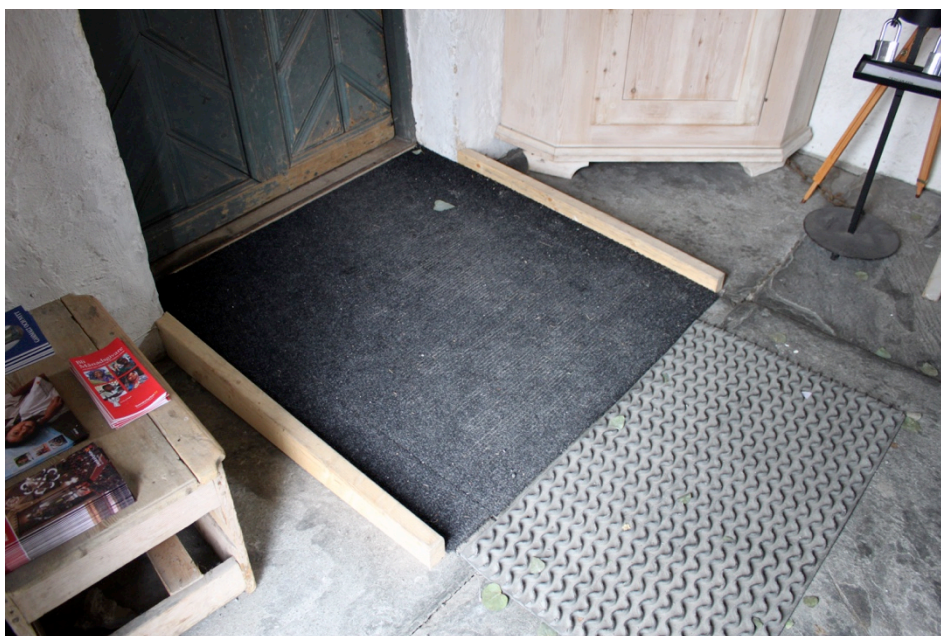
Den nya trärampen i vapenhuset vid dörren till långhuset.
