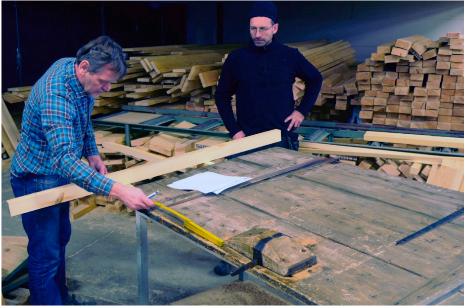
Kyrkporten i snickeriet på Krokoms träindustri. Snickare Lasse Lundgren och plåtslagare Lennart Wasell resonerar om hur porten ska förlängas. Här framgick det att dörren smalnar av nedåt.
