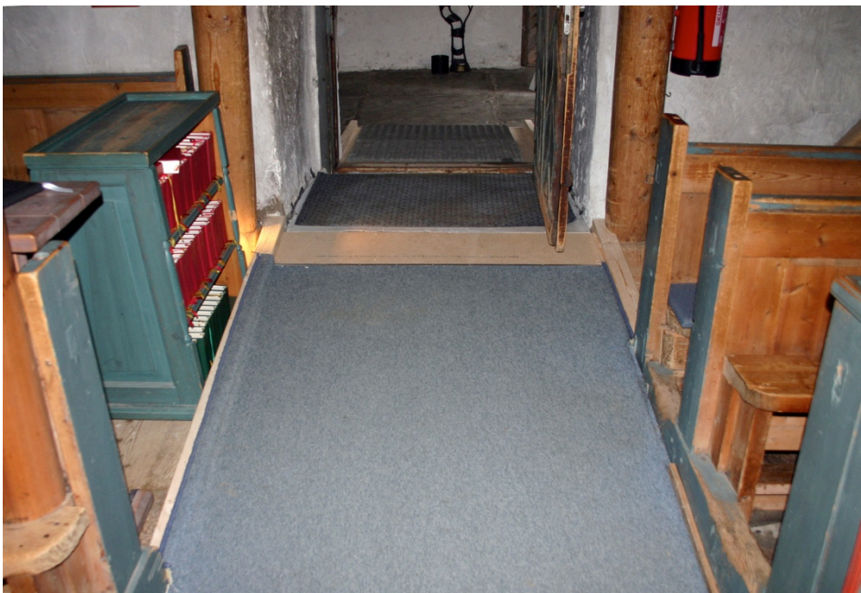
Den nya rampen sedd från långhuset mot vapenhuset
