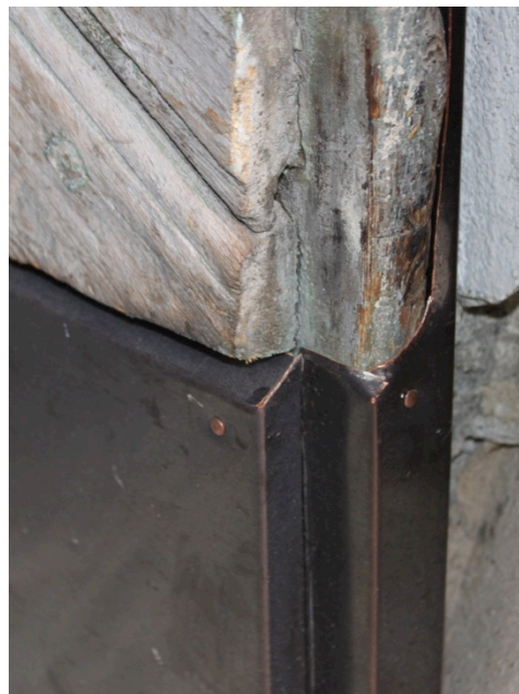
Den färdiga kyrkporten, se även foto på framsidan av denna rapport. Plåtinklädnaden och den tjockare rostfria plåten går upp till den infasade naran för att ge stabilitet åt påbyggnaden.
