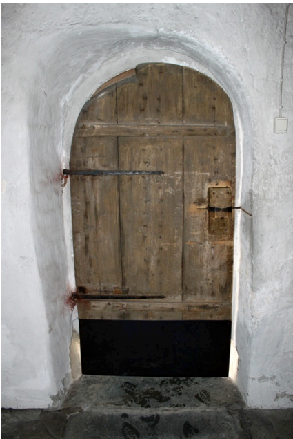
Den färdiga kyrkporten, se även foto på framsidan av denna rapport. Plåtinklädnaden och den tjockare rostfria plåten går upp till den infasade naran för att ge stabilitet åt påbyggnaden.
