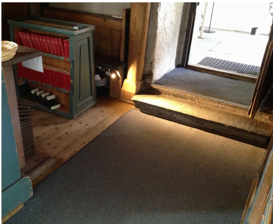
De två trappstegen från vapenhuset och ner till långhusets mittgång. Så här ser det ut under rampen som kom att byggas.
