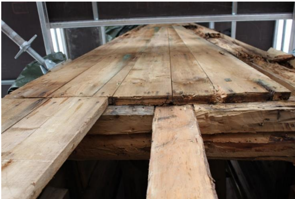
Rotebrädor på västra takfallet, brädorna är kilformade och avpassade mot varandra.
