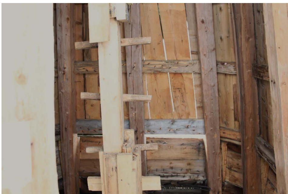
Mittstolpe med iskarvad del som stabiliserats genom att mindre brädor spikats på runt om.
