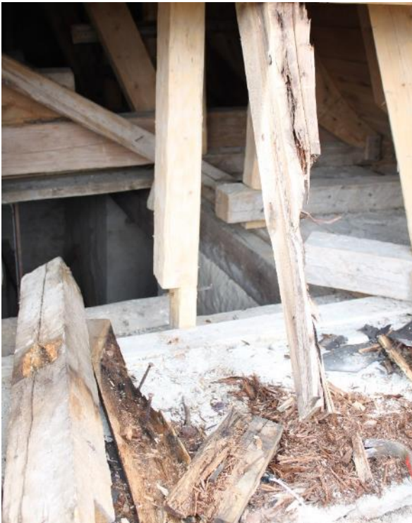
Gammal skada. De stående fyrskärningarna har bultats fast i de två bjälkar som ersatt den rötskadade bjälken.
