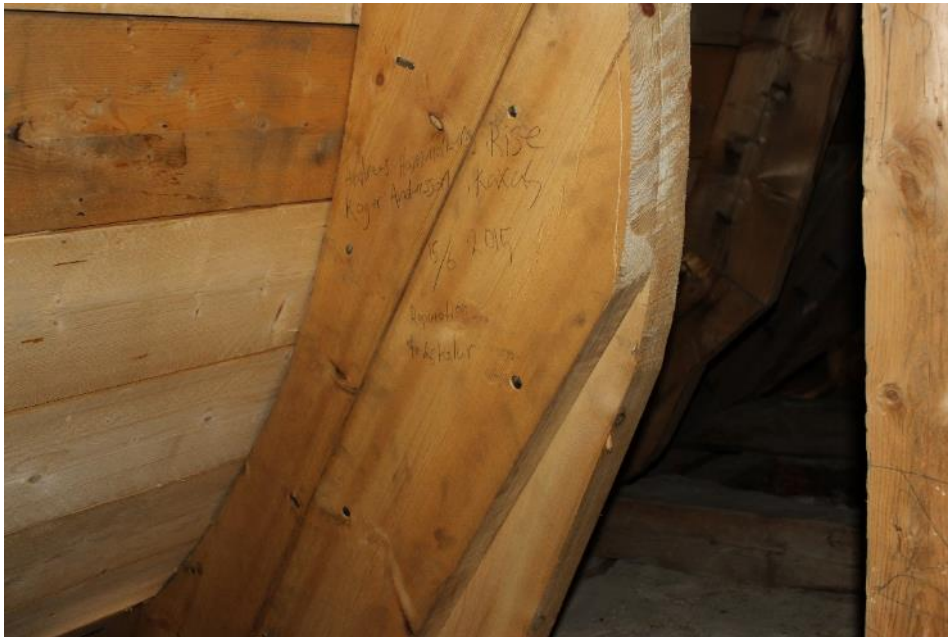
Utbytt rote och lagad takstol åt väster.
