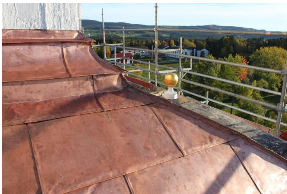
Södra sidan av tornhuv efter åtgärd.
