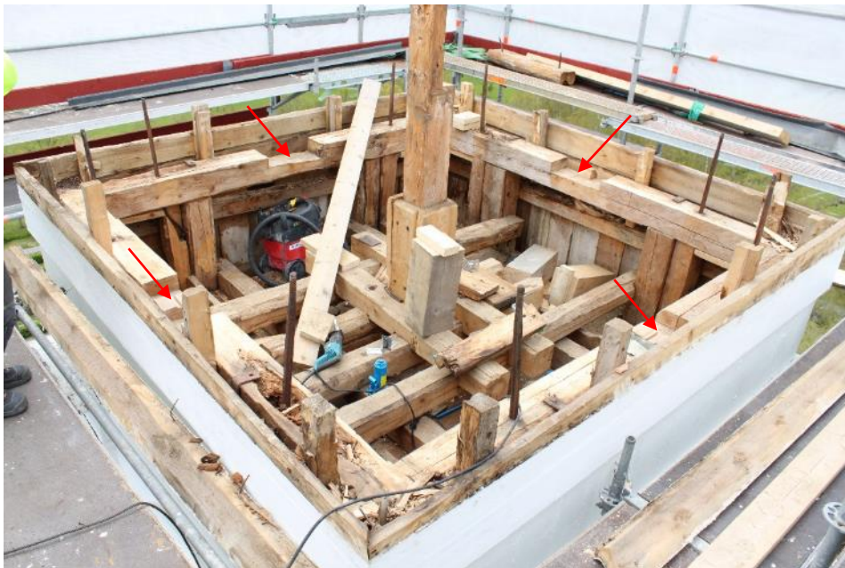
Lanterninen från nordost efter att spiran lyfts av. Notera urtagen i bjälkarna.
