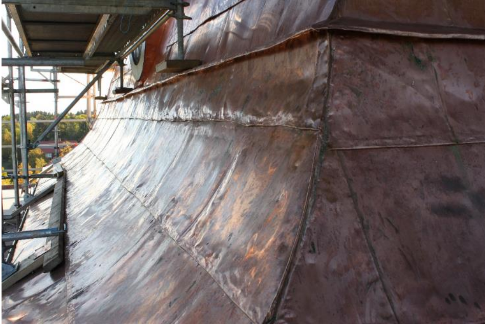
Takhuv efter åtgärd.
