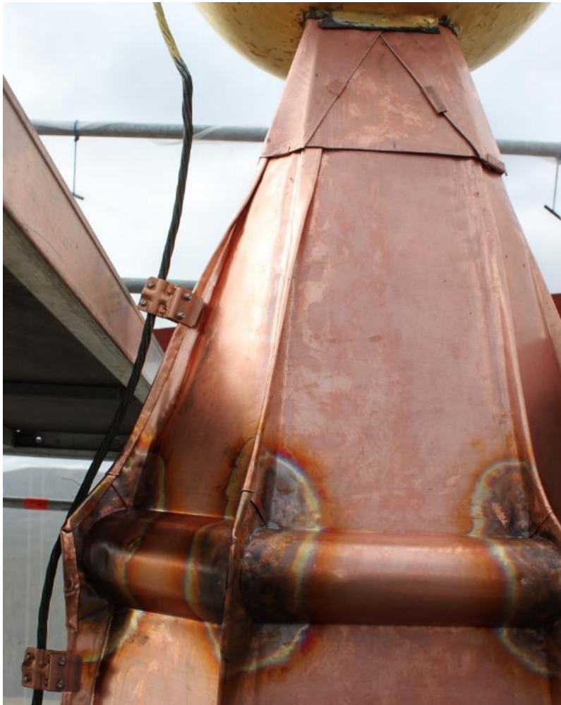
Anslutning av spiran upp mot korsgloben.
