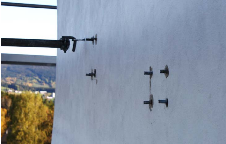
Utstickande järn efter montering av hissen.
