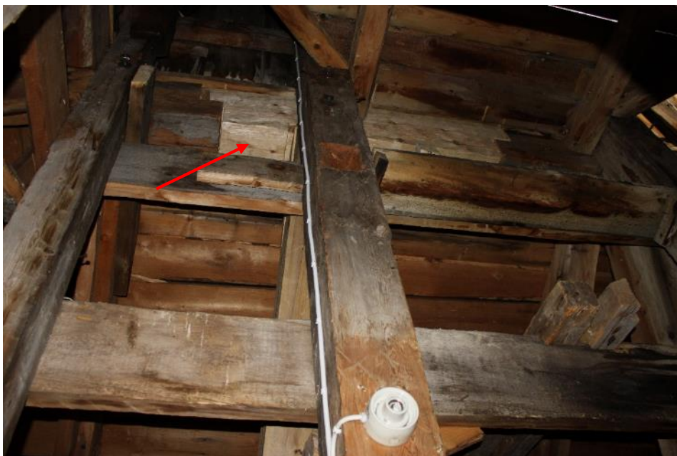
Ilagning på bjälke upptill på huvan.
