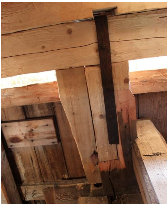
Lanterninen från nordost efter att spiran lyfts av. Notera urtagen i bjälkarna.
