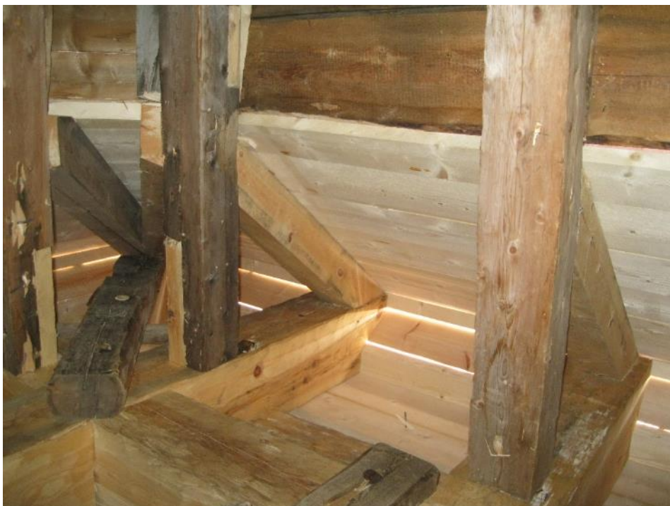
Nordöstra hörnet av spiran inifrån. Mindre lagningar syns på de stående bjälkarna i hörnet. Notera också den nya takfotsinklädningen (foto Calle Wahlström).
