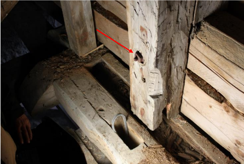
Gammal skada. De stående fyrskärningarna har bultats fast i de två bjälkar som ersatt den rötskadade bjälken.
