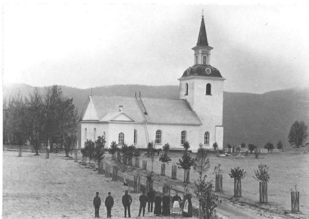
Bild längst ned: Fotografiet taget efter torn-tak och långhustak byggs om. På bilden framgår att lanterninens hörn är ljusvita och att mittpartierna har en mörkare kulör. Fotograf och årtal okänt. Jlm 74 x-11/4 (5)
