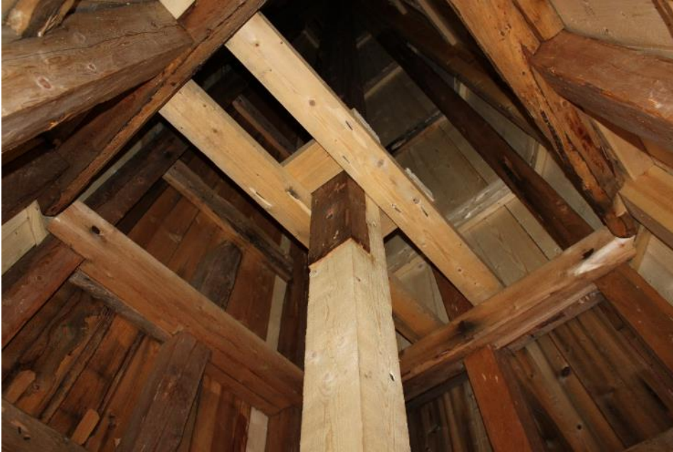
Mittstolpen fick en ny skarv med halvsulning.
