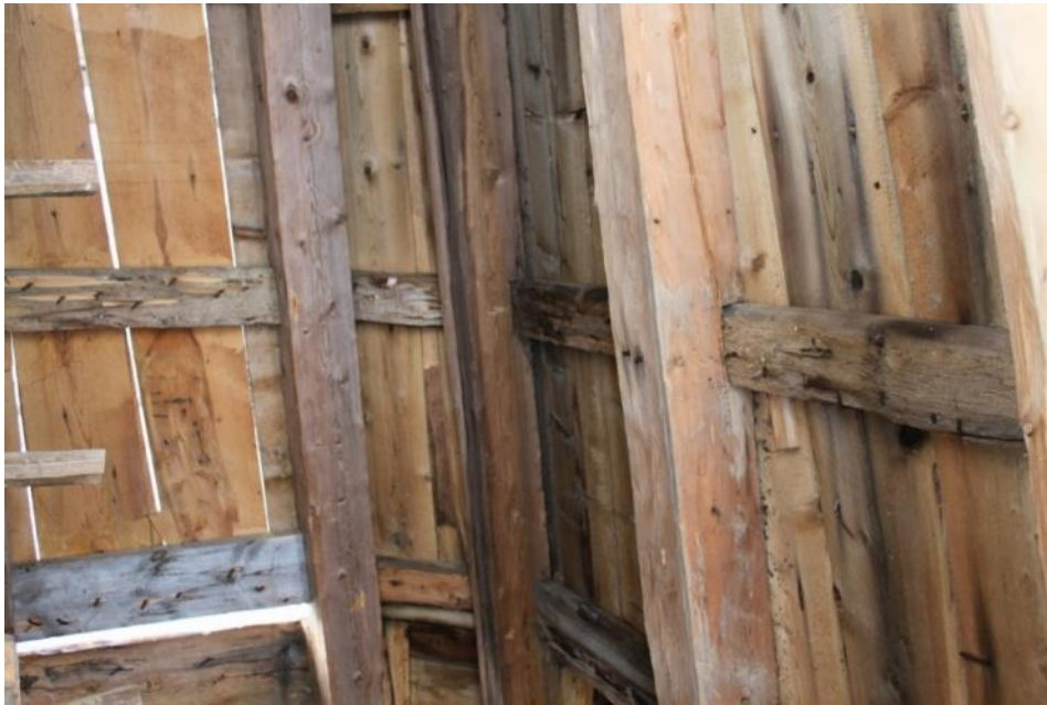
Bilden visar spiran inifrån med stående fyrkantsvirke, reglar och stående rotebrädor.
