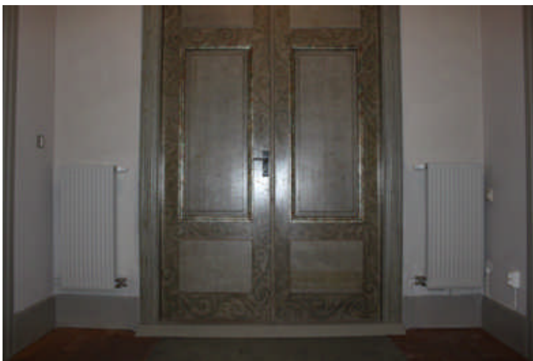
Bild 2: Vapenhuset efter montering av radiatorer och inmålning av kopparrör. Rören nedanför dörren är täcka av en inmålad tröskel.
