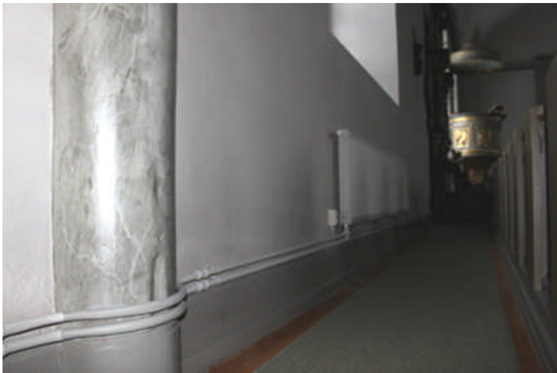
Bild 4: Monterad radiator och inmåde kopparrör i kyrkans långhus.
