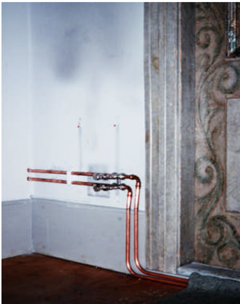
Bild 1: Nya rördragningar i vapenhuset innan montering av radiator och inmålning
