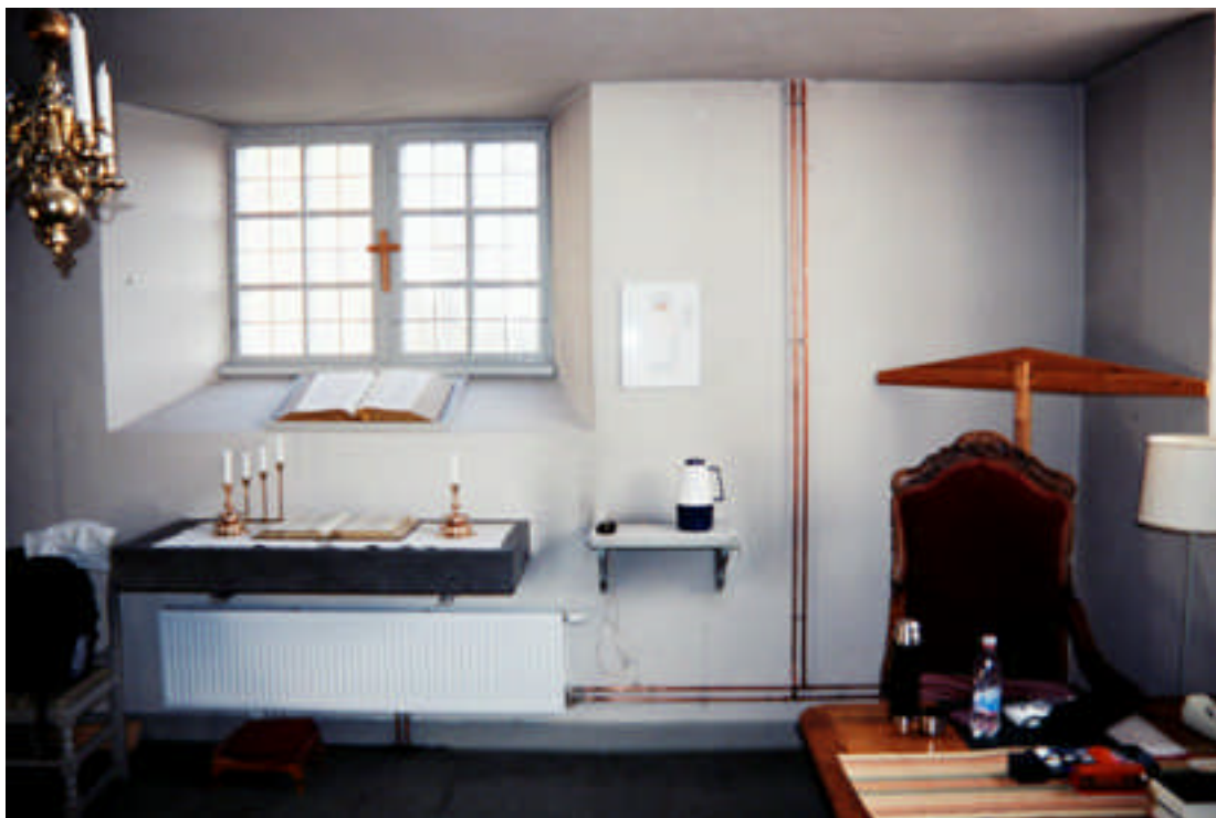
Bild 7: Sakristian efter montering av radiatorer.
