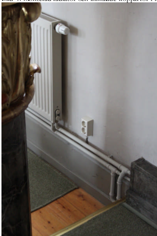
Bild 5: Rördragning i långhuset.
