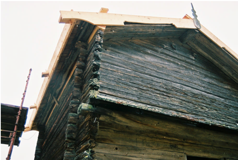
Bild 12. Nya vindskivor och stoppbräda (bild nr 09m043/05).
