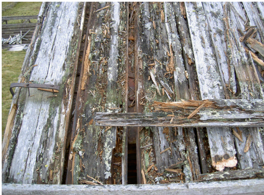
Bild 9. Taket var innan restaureringen i mycket dåligt skick (digital bild nr 8859).
