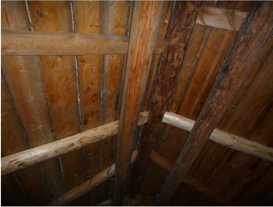
Bild 8. De två nya rafterna vid nock (digital bild nr 1020877).
