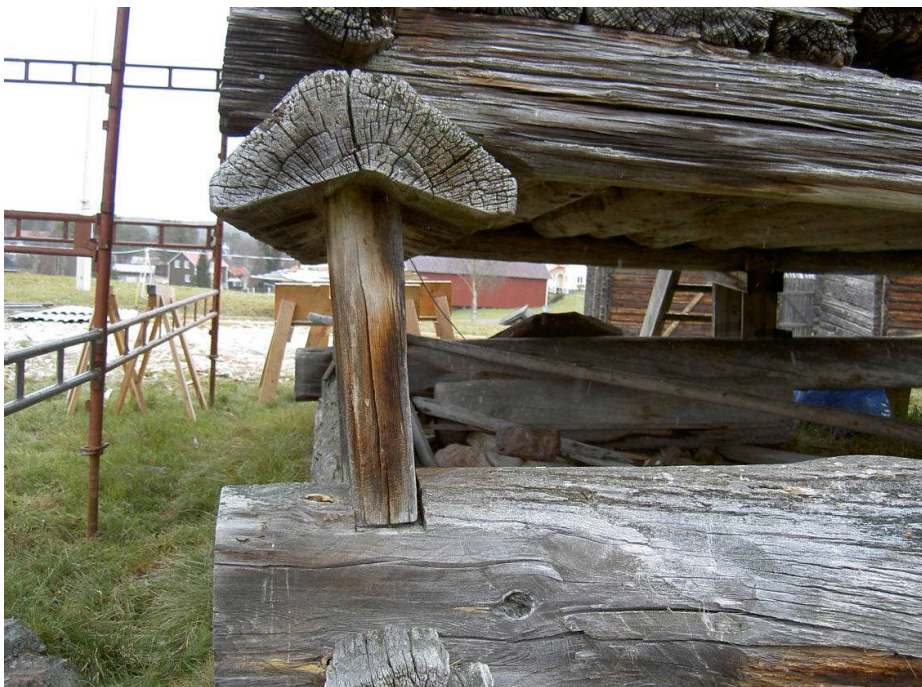
Bild 3. Stolpen under C-D-hörn lutade kraftigt utåt.
