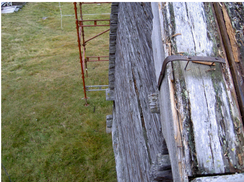
Bild 4. Rötfickan på C-vägg (bild nr 8864).
