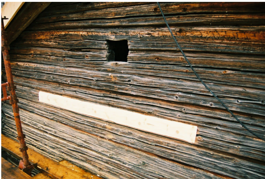
Bild 5. Den ilagade rötfickan på C-vägg (foto nr 09m043/12).
