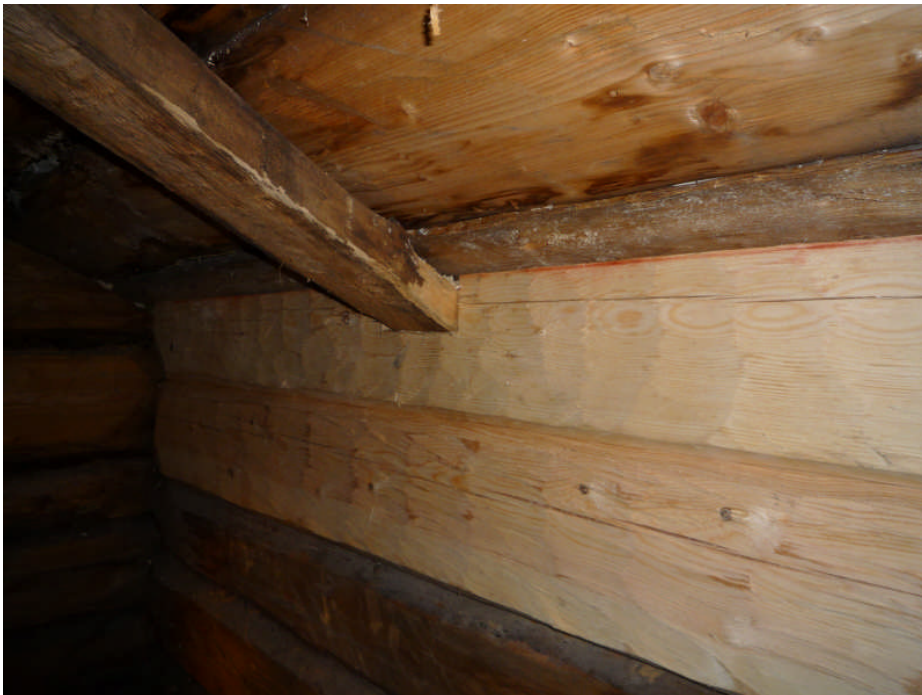
Bild 7. En av rafterna som justerats, den utbytta D18 och hammarbandet D19 (digital bild nr 1020864).
