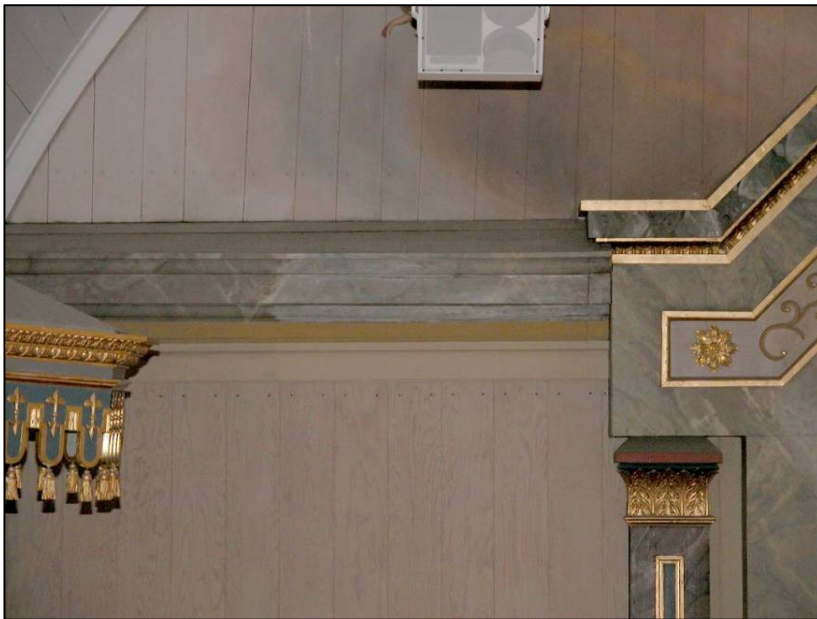
Taklist före åtgärd. JLM CD 08051
