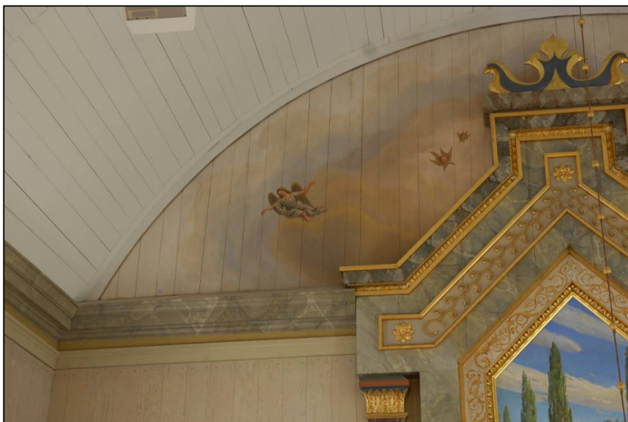
Norra delen av fondväggen efter åtgärd. JLM CD 08051
