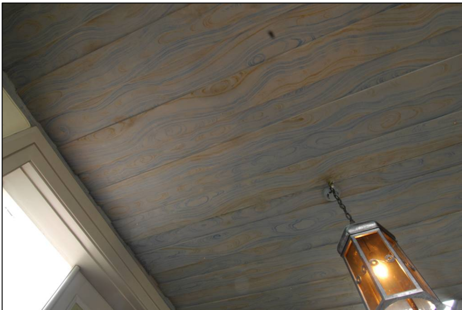
Vapenhus tak JLM CD 08051
