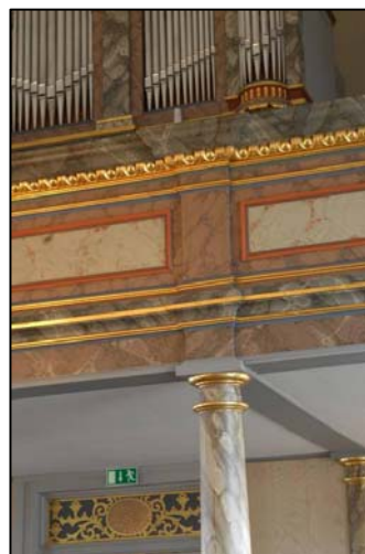
Del av läktarbarriär efter åtgärd. JLM CD 08051.
