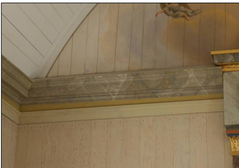
Taklist efter åtgärd. JLM CD 08051
