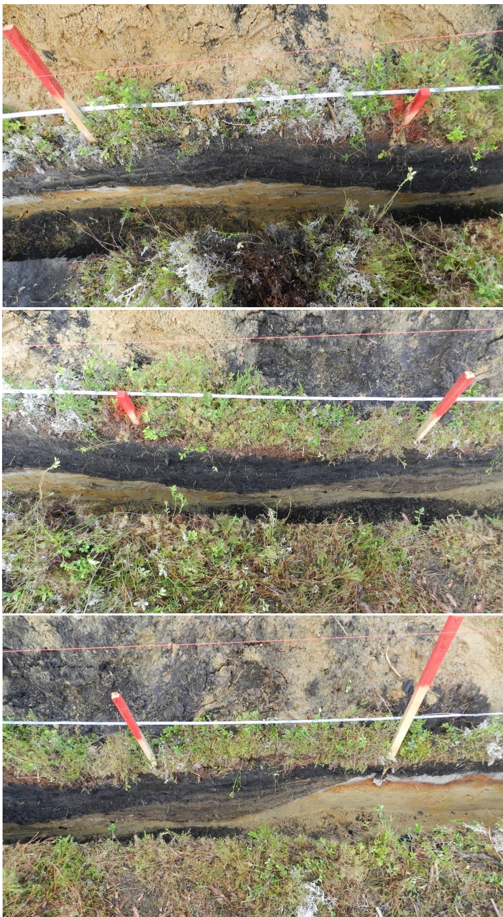
Schakt 1 från ca x101 y 100 till x104 y 100. Bilder tagna mot VSV.
