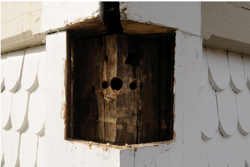
Tre hål borrades, två för infästningens nya gängstänger och ett för värmekabeln.
