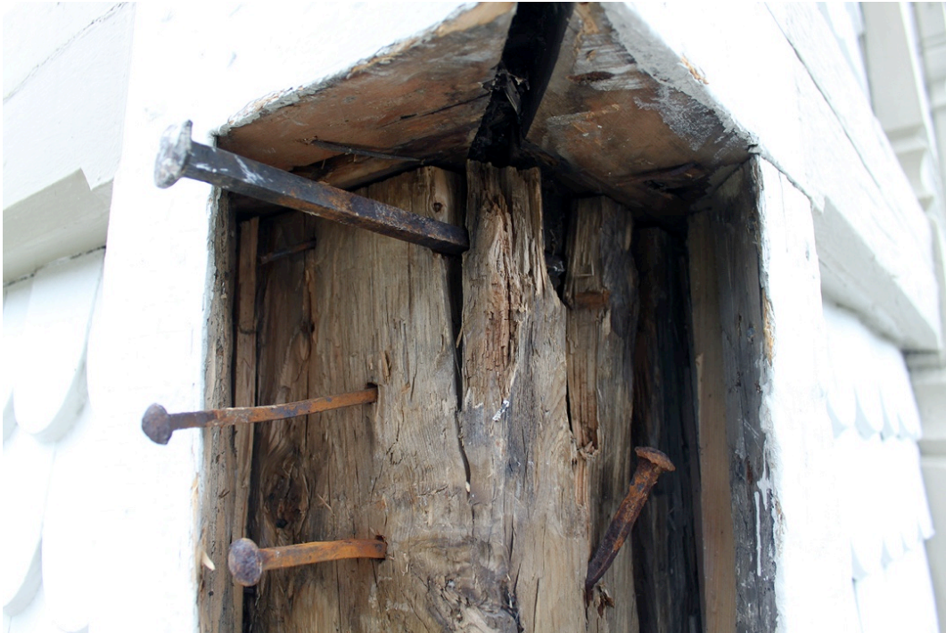
De smidda spikar som drakarna ursprungligen var fästa med fanns kvar bakom de ilagade knutbrädorna.
