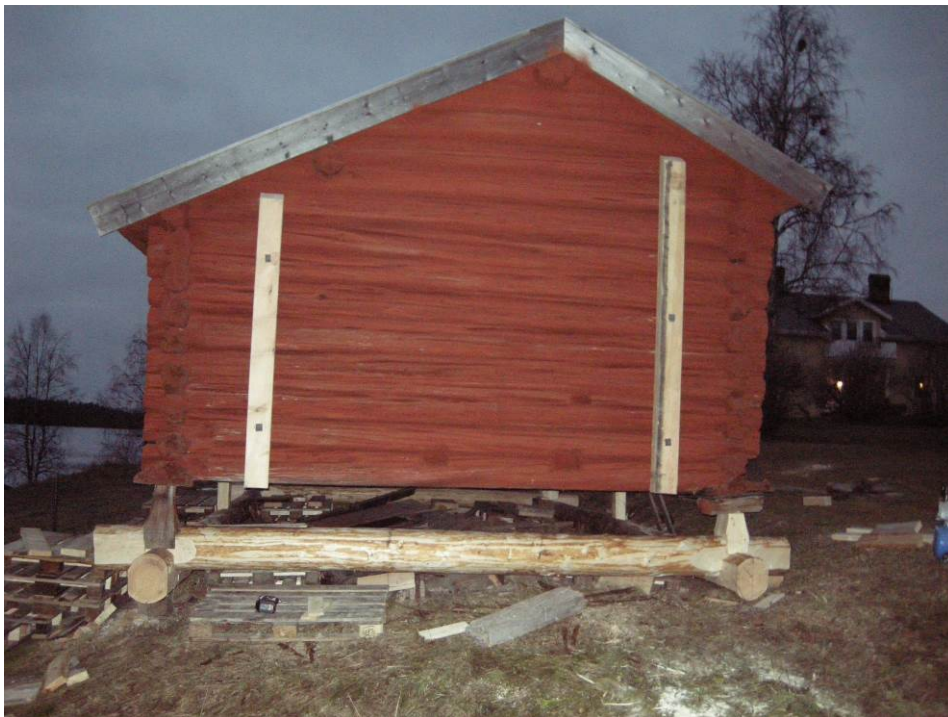
7 Två följare monterades på B-väggen.
