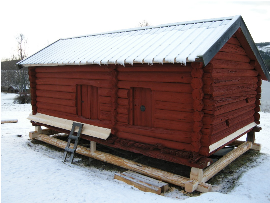
10 Dubbelboden efter restaurering 2014.
