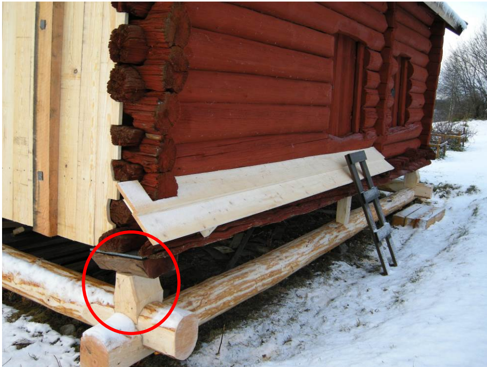
9 En täckbräda monterades över mushyllan på A-väggen. Stolpe vid AB-hörn har ersatts. Den nya stolpen har utförts lika som tidigare, vilket innebär att den liggande plankbiten som pallade upp hörnet har återanvänts (se i den röda ringen).
