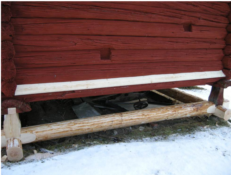
5 I stället för att göra en ilagning på D1, sattes en täckbräda som skydd.
