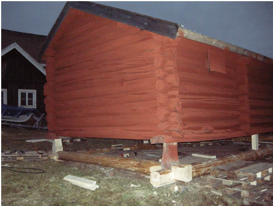
4 Det nya underredet monterades på plats.
