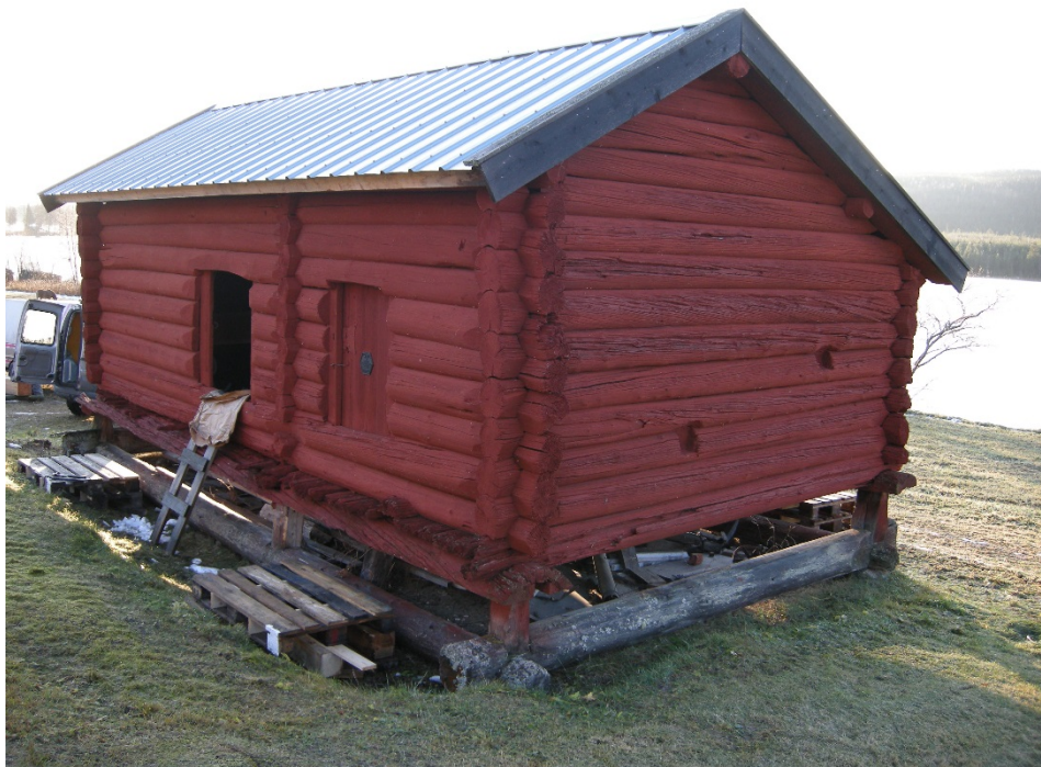
1 Dubbelboden före åtgärd.
