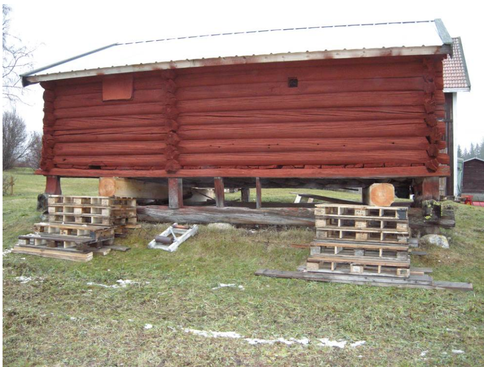
2 Byggnaden lyftes upp
