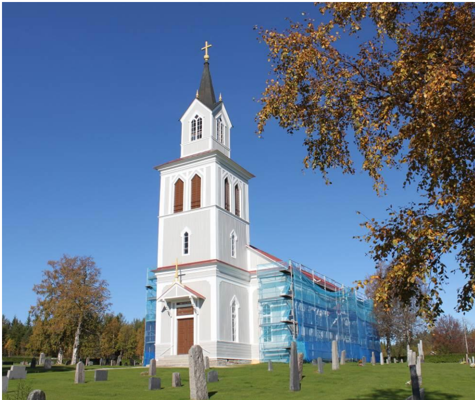
Figur 19 Åsarne gamla kyrka innan ställningen togs bort från långhuset.
