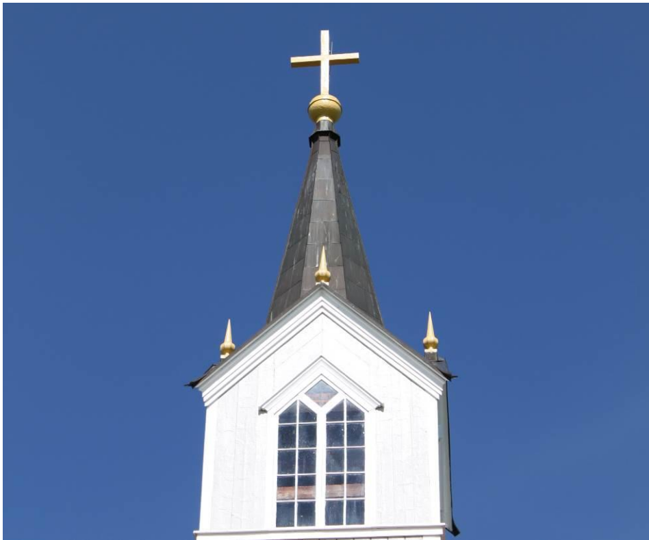
Figur 15 Kors och korsglob efter åtgärd.
