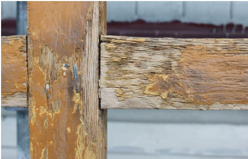
Figur 14 Korsen över entrétaken hade ytterst ett gulbrunt lager. Under detta fanns flera gula och gulbruna färglager om vartannat.
