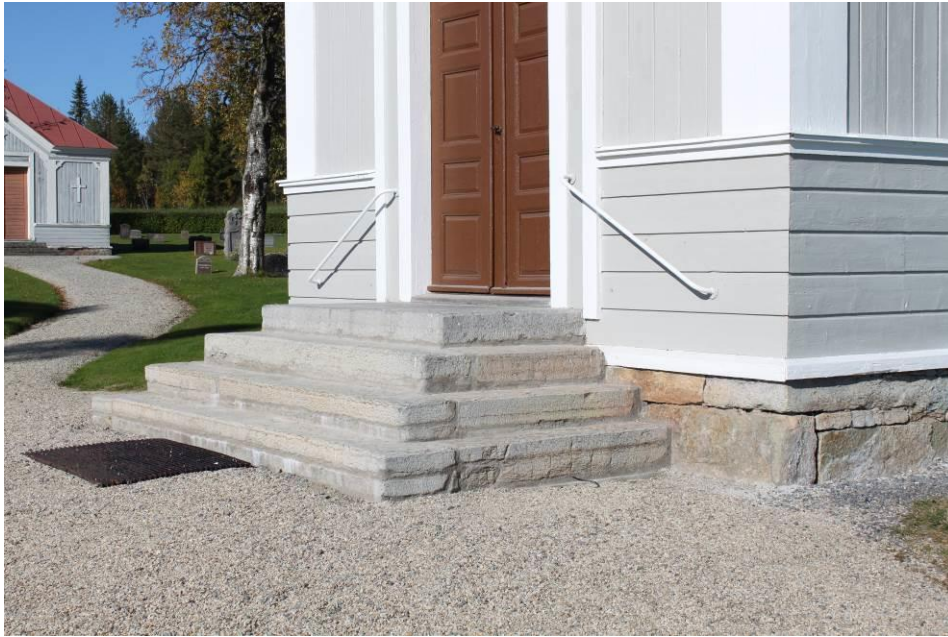
Figur 18 Entrétrappan efter åtgärd.
