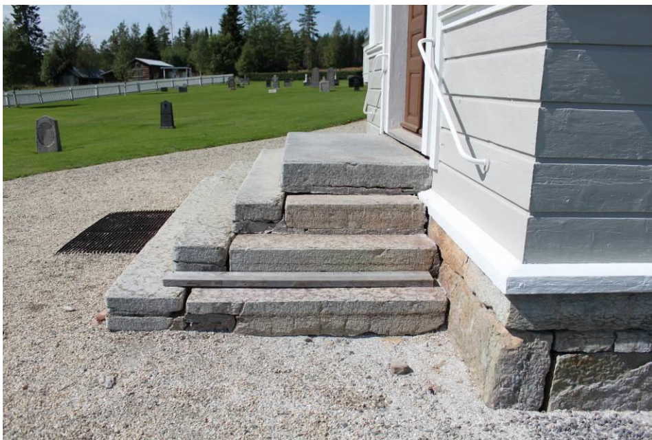
Figur 17 Entrétrappan före åtgärd.
