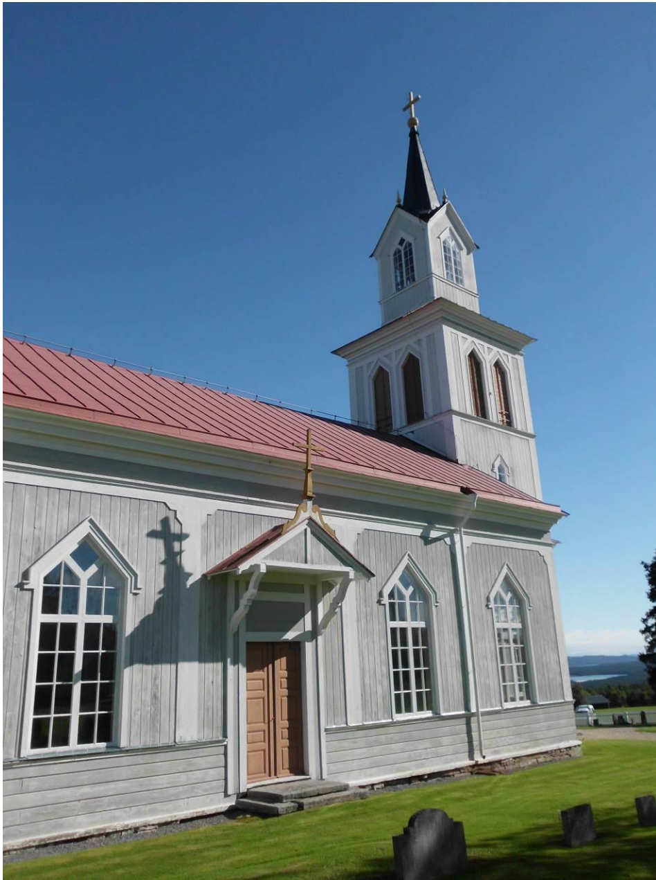
Figur 4 Åsarne gamla kyrka från nordväst före åtgärd: Taket var blekt, fasaden flammig i olika grå toner och dörrarna hade en ljus brun kulör.
