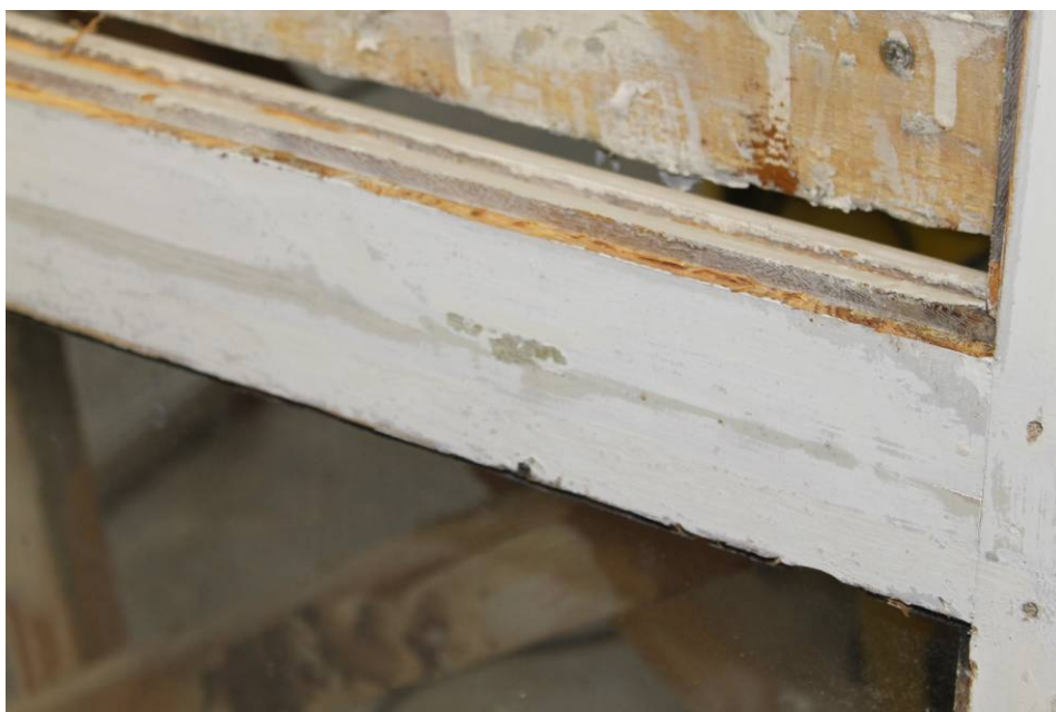
Bild 4. Detalj på innerbåge före målning då den fraktats till Nälden för skrapning och målning på Fönster- och måleriteknik i Jämtland AB (digital bild nr 3238).
