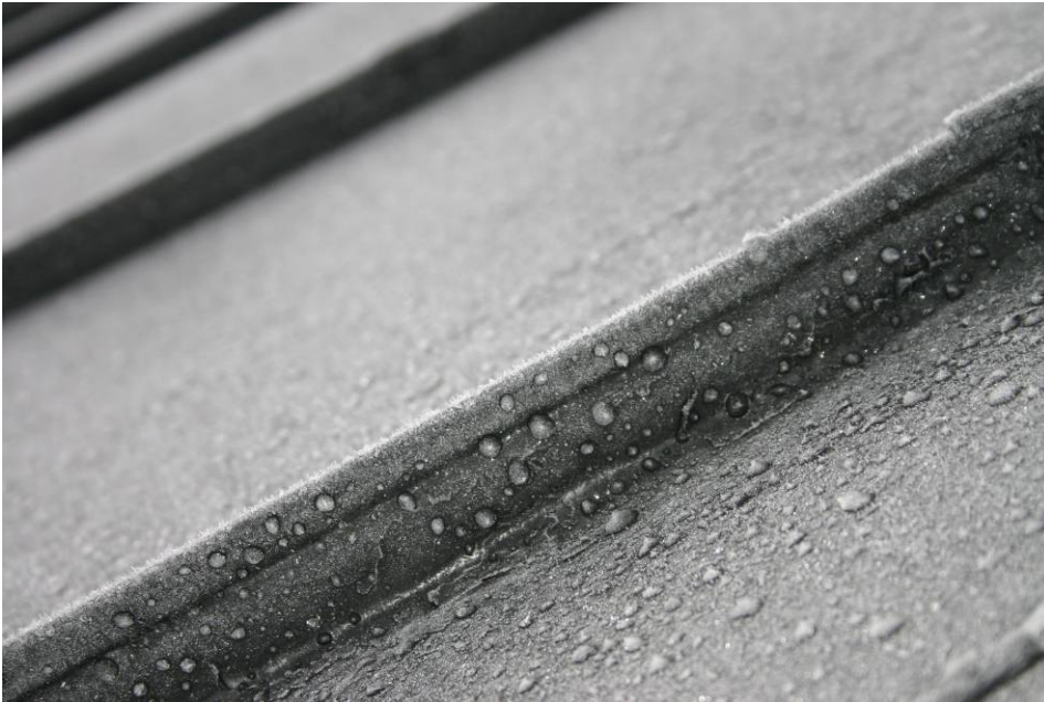
Bild 7. Detaljbild på plåttakets fals efter utförda målningsarbeten (digital bild nr 4392).
