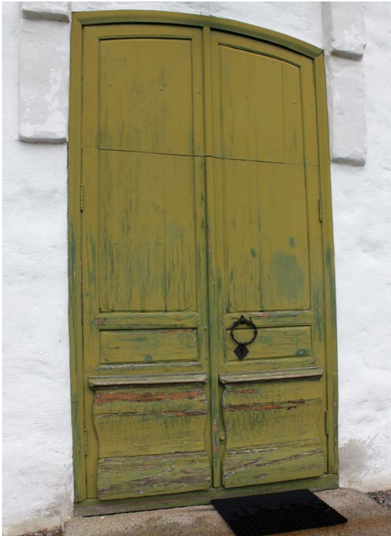
Bild 5. Portbladen före målning. Kulören på det yttersta färgskiktet var svårbestämbar men ligger nära NCS S 5030-G30Y enligt Index 2004 (digital bild nr 2604).
