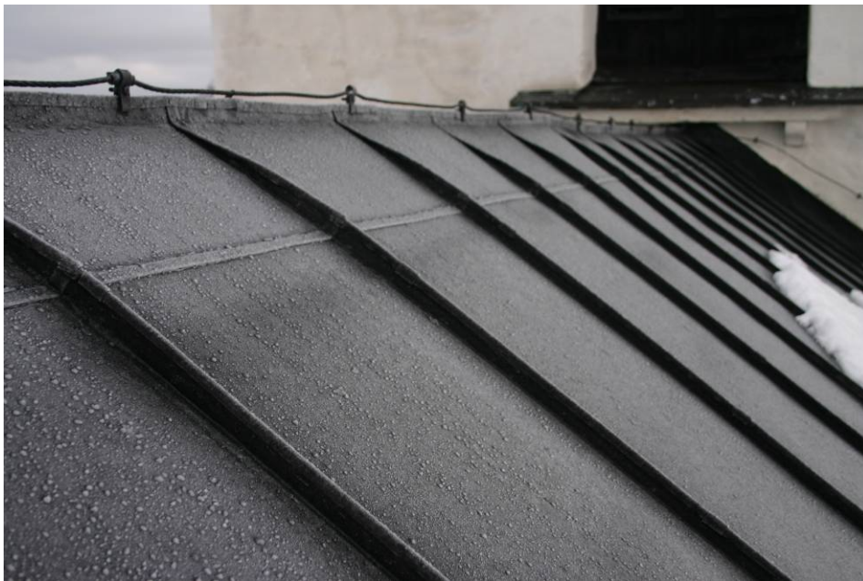
Bild 6. Kyrkobyggnadens tak efter utförda målningsarbeten, fotograferad från en taklucka som nås via kyrkans långhusets vind (digital bild nr 4394).
