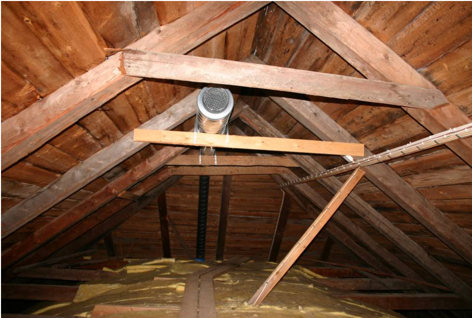
Bild 10. Avluftning vind (digital bild nr 4373).
