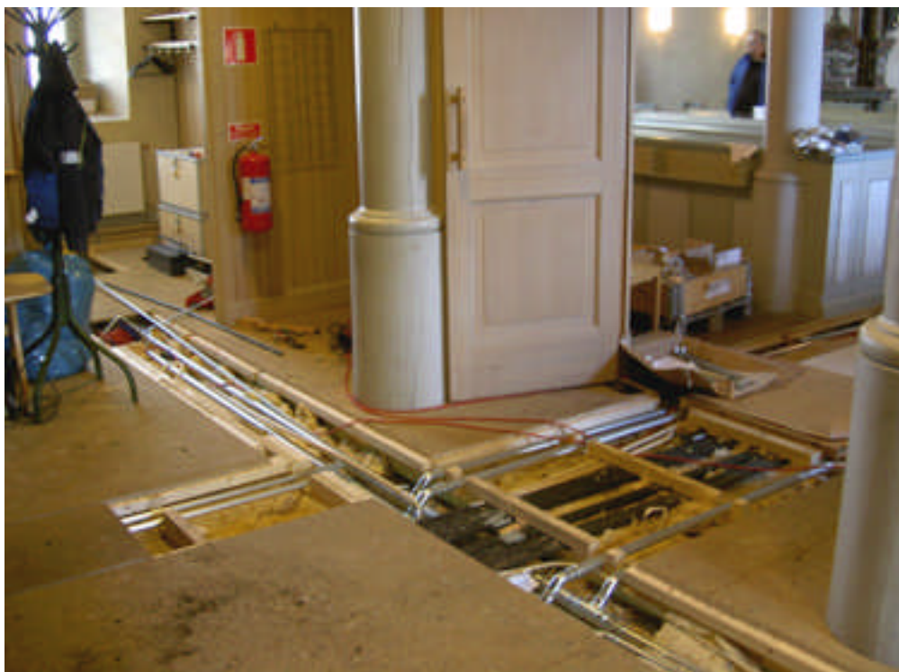
Bild 2: Rörledningarna har så långt som möjligt dragits dolda under golvet.
