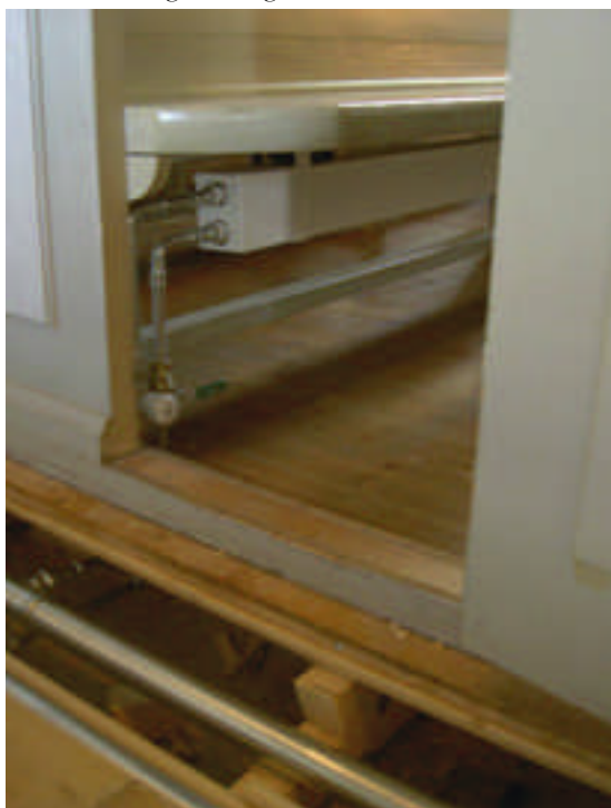
Bild 7: Rörledningar och bänkvärmare installerade.
