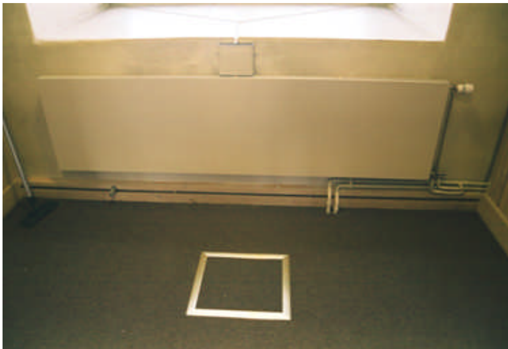
Bild 1: Brunnen nås via en lucka i golvet där ledningarna dragits in i kyrkan.
