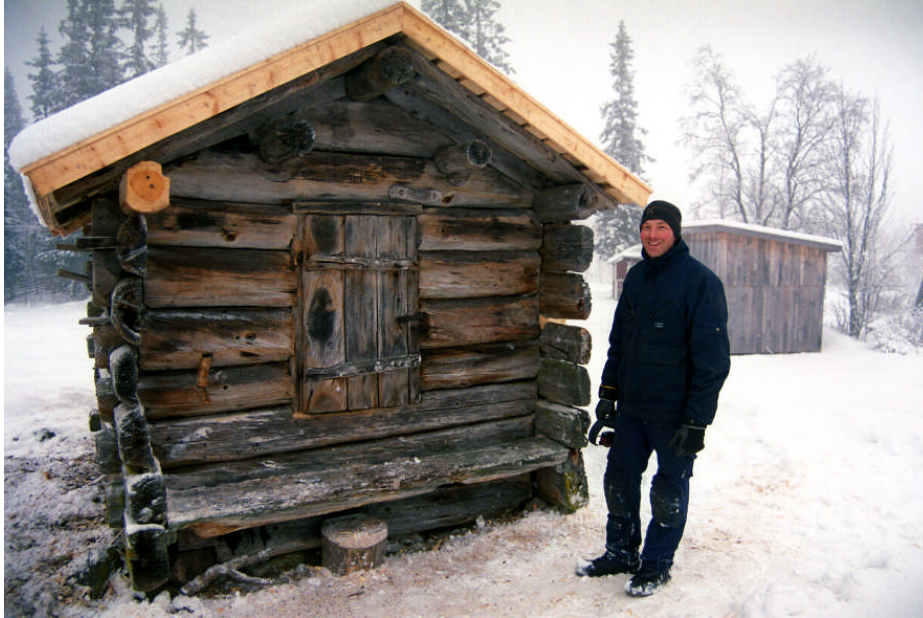
Timmermannen Daniel Åkerman vid benladan efter genomförd restaurering (bild nr 09m046/12).
