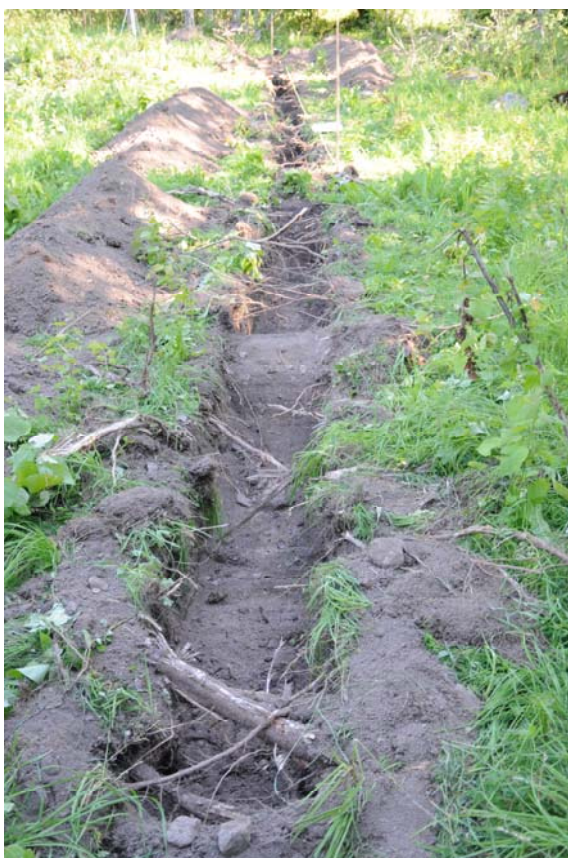
Foto 2. Schakt nr 4 från NV. För profil, se bilaga 3. Matjordslagret var i denna del av området omkring 5 dm tjockt.
