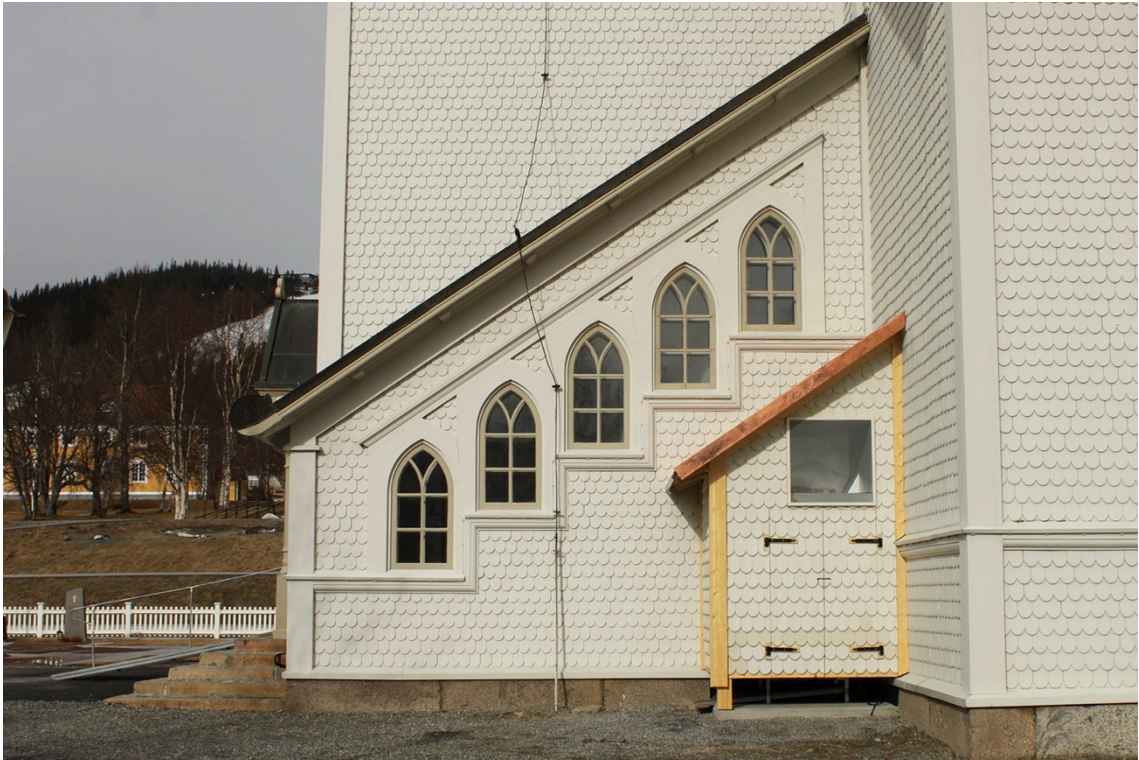
Påbyggnaden med den nya toppblåsande värmepumpen sedd från söder.
