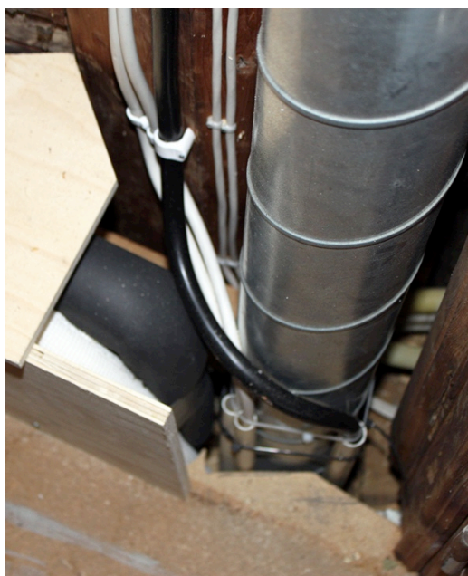
Något suddig bild av hur rör och ledningar går genom bjälklaget och kommer upp på tornets andra våning.
