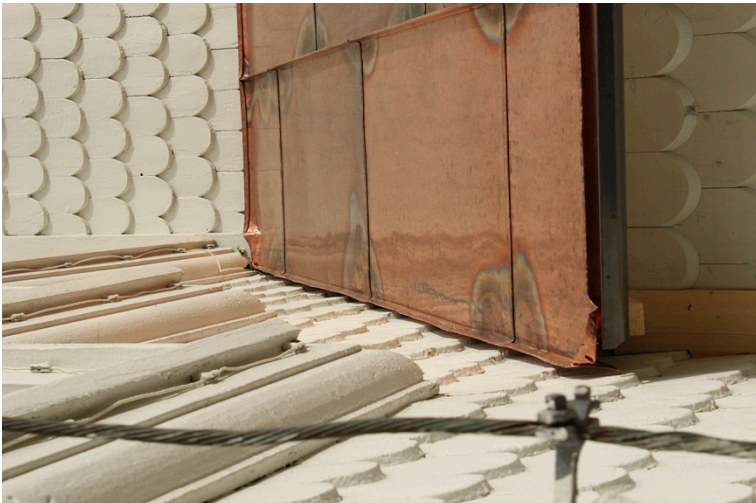
Mot tornets fasad har det lämnats en glipa för att undvika ingrepp i fasadspånen samt för att regnvatten ska kunna rinna ner.
