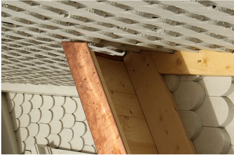
Även mot långhusets fasad har det av samma skäl lämnats ett mellanrum.
