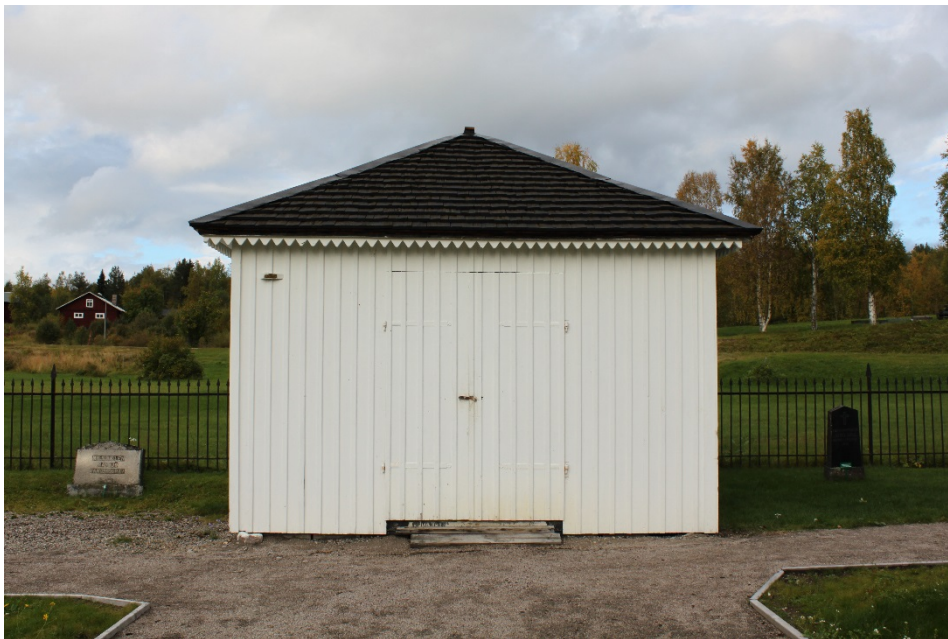
Figur 13 Bårhuset efter åtgärd.
