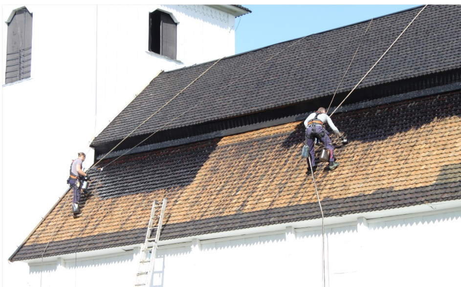
Figur 7 Vid slutbesiktning den 9 september 2015 pågick tjärningen av taket för fullt.
