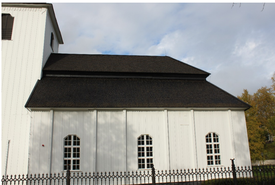
Figur 8 Den 23 september 2015 gjorde undertecknad ett besök på plats för att se slutresultatet.
