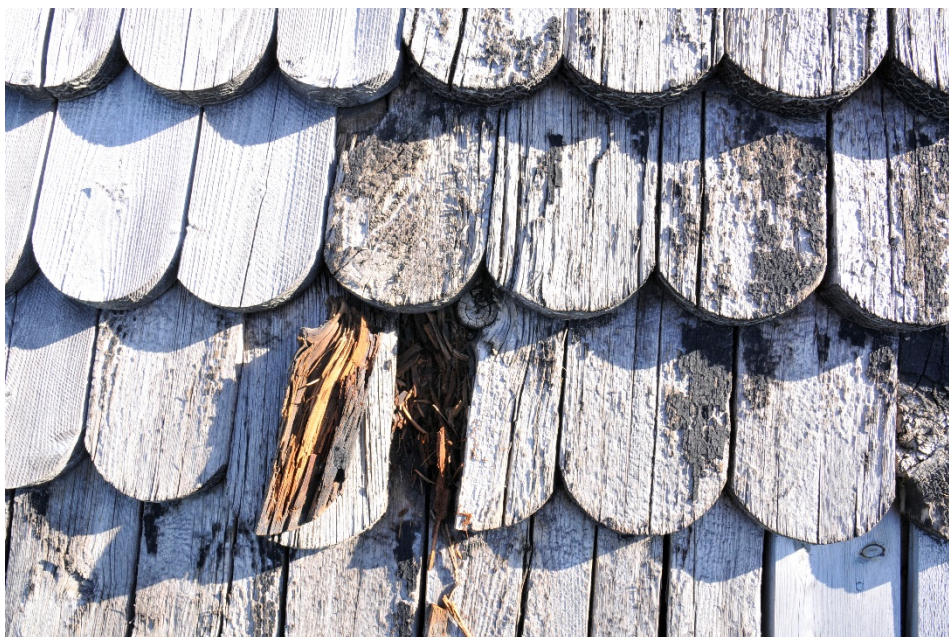
Figur 1 Spånen var till stora delar helt uppruttnade, de gick bitvis att plocka sönder för hand.
