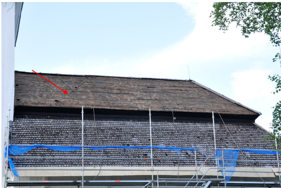
Figur 2 Takfallet åt söder. En skarv på övre takfallet visar hur kyrkans tak såg ut innan tornet byggdes.
