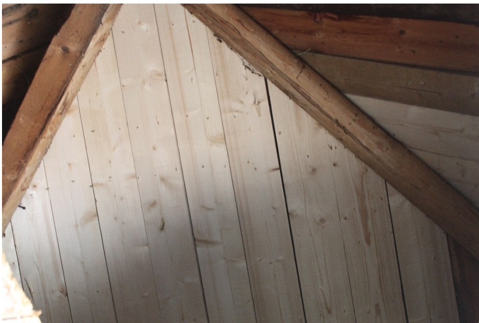
Figur 12 Efter åtgärd. En stor del av rotet på takfallet åt öster har bytts. De nya brädorna har lagts med en liten springa emellan, för att få till luftning av takkonstruktionen.
