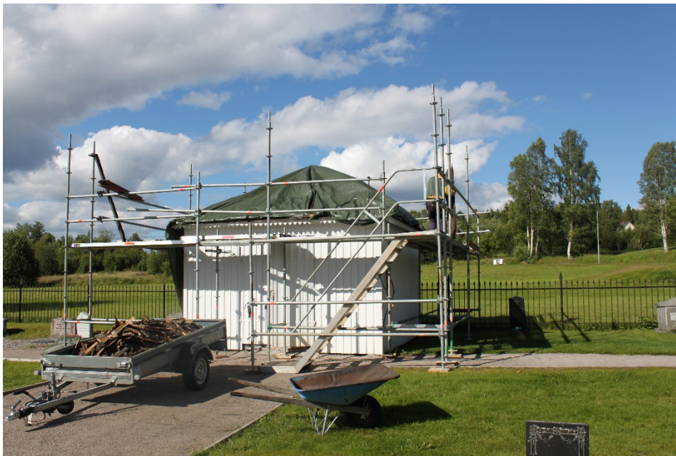
Figur 9 Bårhuset efter att spåntäckningen plockats ned.
