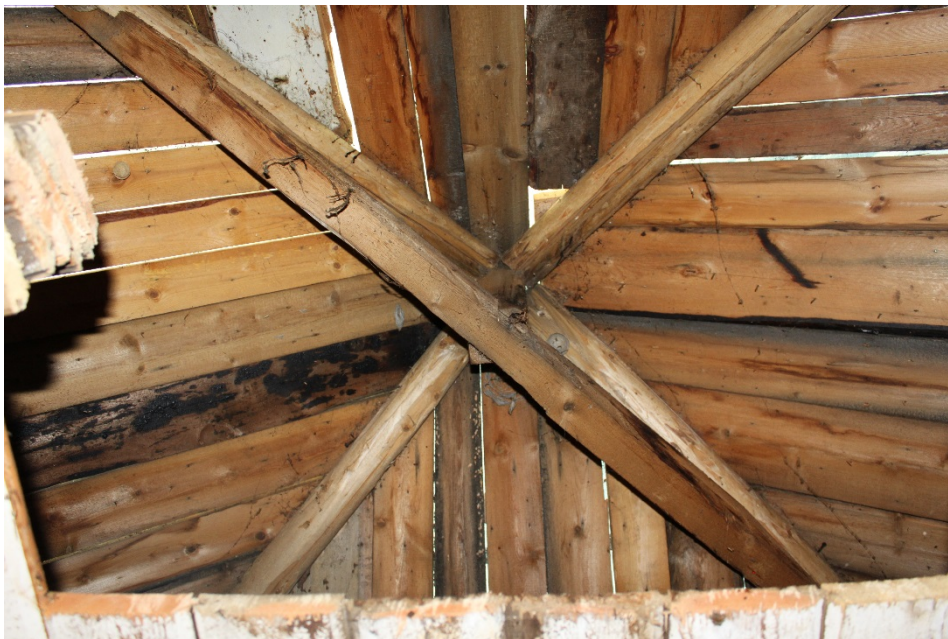
Figur 11 Rotningen är stående, detta hänger samman med takstolskonstruktionen som består av fyra stolpar i hörnen som möts på mitten.
