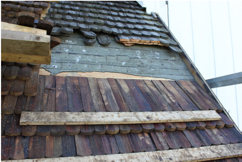
Figur 3 Pappen som låg under den gamla spåntäckningen plockades bort i samband med omläggningen.
