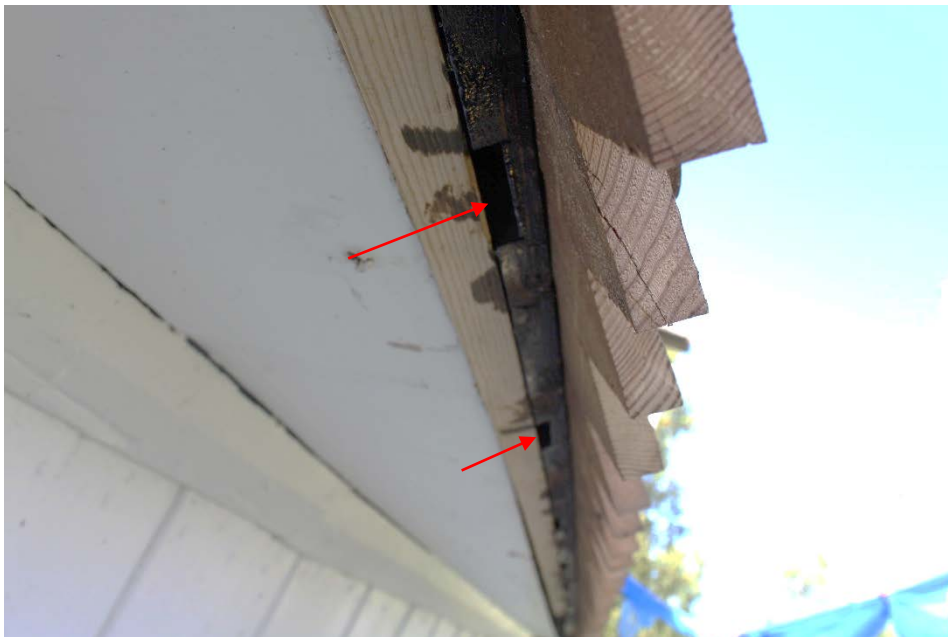
Figur 4 Nere vid takfoten sattes en bräda med utskurna lufthål.
