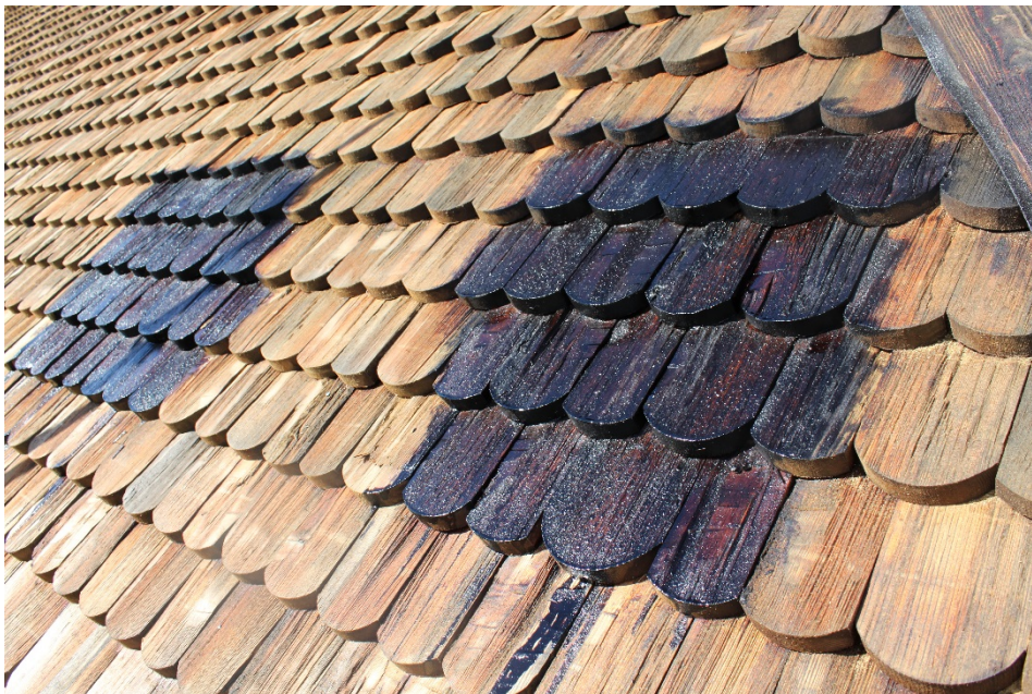
Figur 6 Två uppstrykningsprover med pigmenterad tjära ströks på det södra takfallet. Ett med 10 % kimrök och ett med 20 % kimrök.
