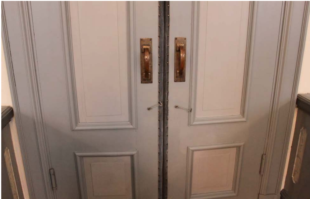
Entrédörr mot norr i långhuset, efter åtgärder har utförts.
