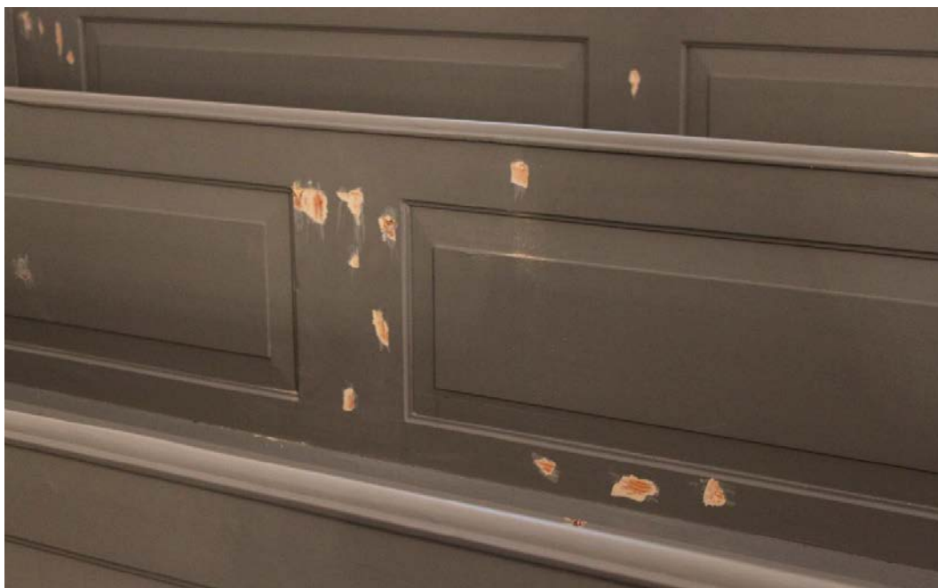
Färgsläpp har skrapats till trärent på bänkinredningen.
