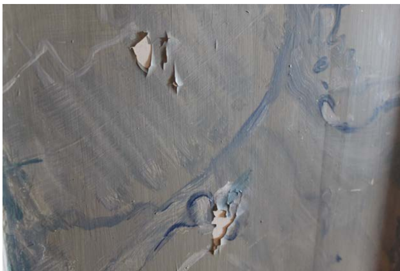
Färgsläpp på de marmorerade speglarna tillhörande bänkdörrar och bänkskärmar.
