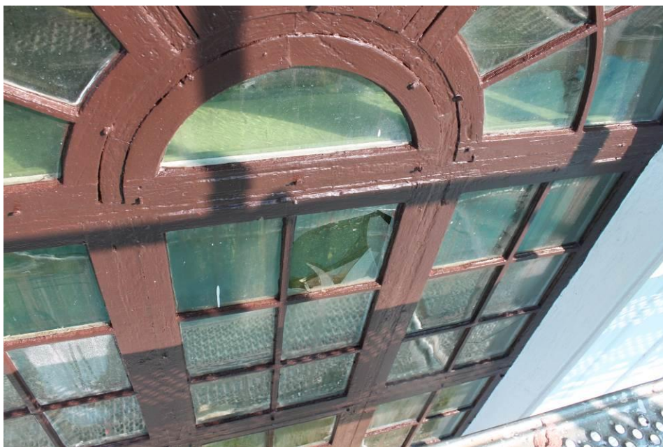
Figur 7 Fönstren har målats med linoljefärg i en rödbrun kulör (1D-663 Järnoxidbrunt ”Linoljefärg 2003”) trasiga rutor har inte åtgärdats innan målning.
