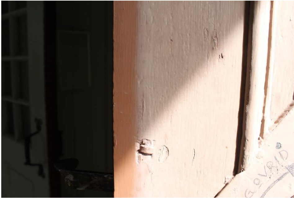
Figur 5 Entrédörrarna var innan åtgärd målade i en blekt brunrosa kulör. Lägg märke till dörrbladets mörkare kant som varit skyddad från solen.
