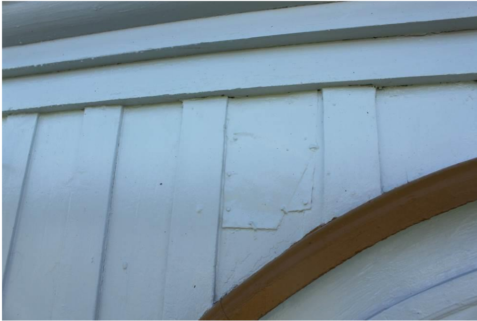
Figur 4 Högt upp på tornet noterades några äldre lagningar. På tornets norra sida hade två mindre plåtbitar spikats upp på väggen strax nedanför taklisten.
