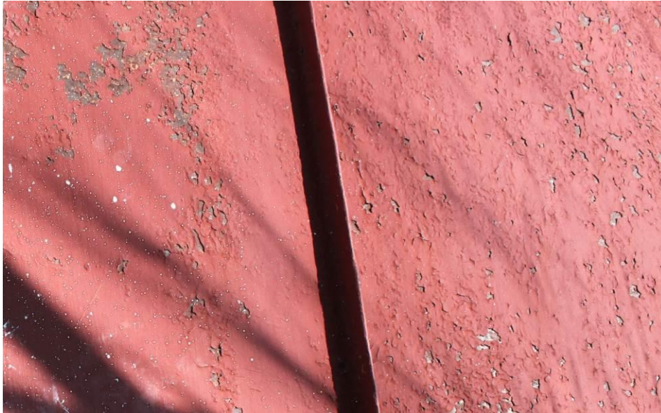
Figur 1 Färgen på taket hade delvis släppts med fläckvis blottlagd plåt som följd. Färgytan var matt till sin karaktär och hade antagit en blekröd ton.
