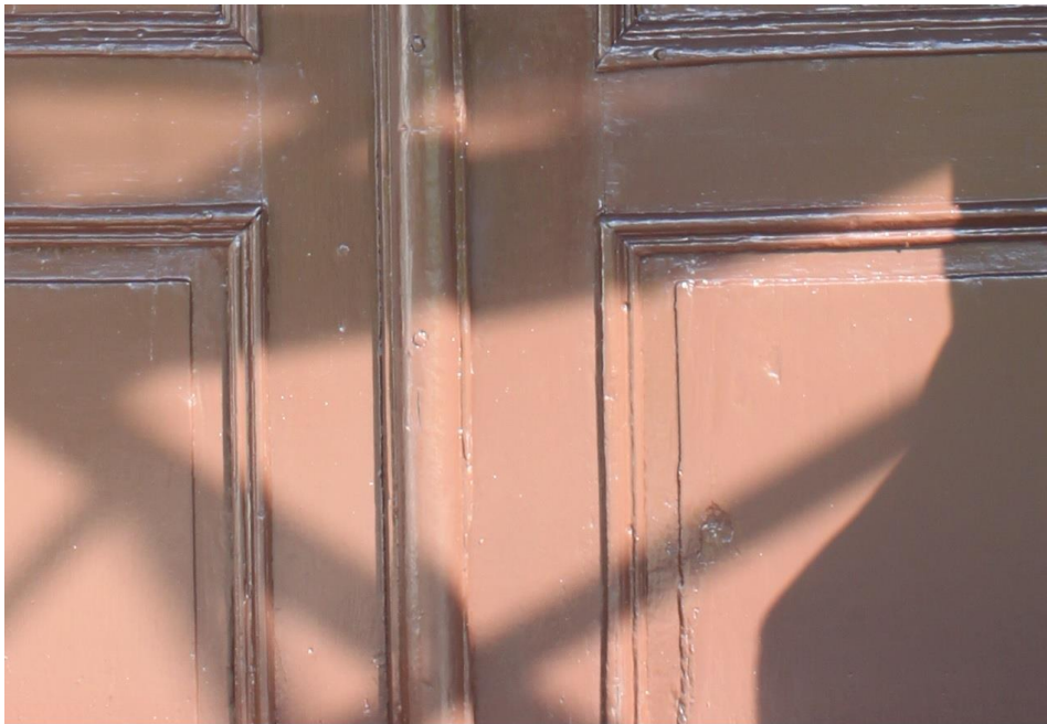
Figur 6 Entrédörr efter åtgärd.
