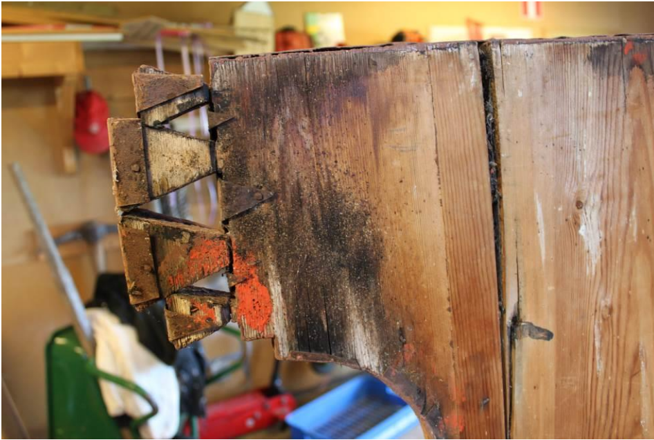
Figur 11 Detalj av tavlans baksida. Vid den smala anslutningen mot tavlan är de konformade trätapparna - guttae skadade. Träbitarna hålls dock på plats av plåten.
