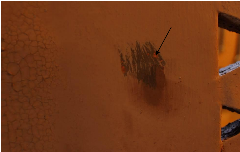
Figur 10 Framskrapat underliggande färglager. Den röda blymönjan tittar fram.
