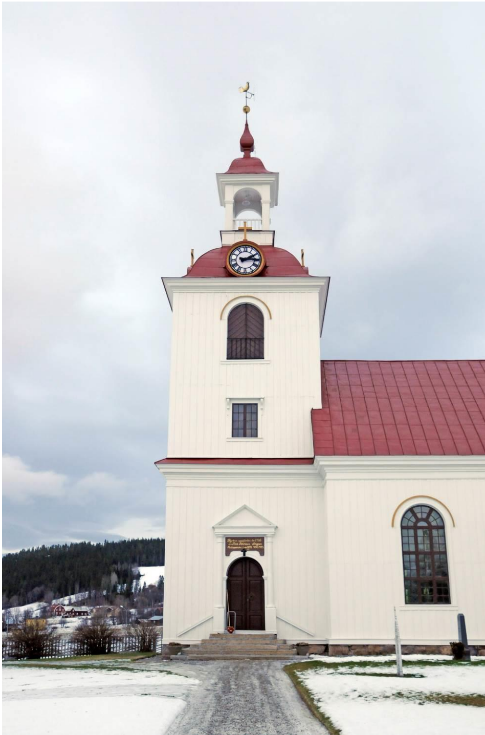
Figur 15 Tornet på Klövsjö kyrka efter åtgärd.
