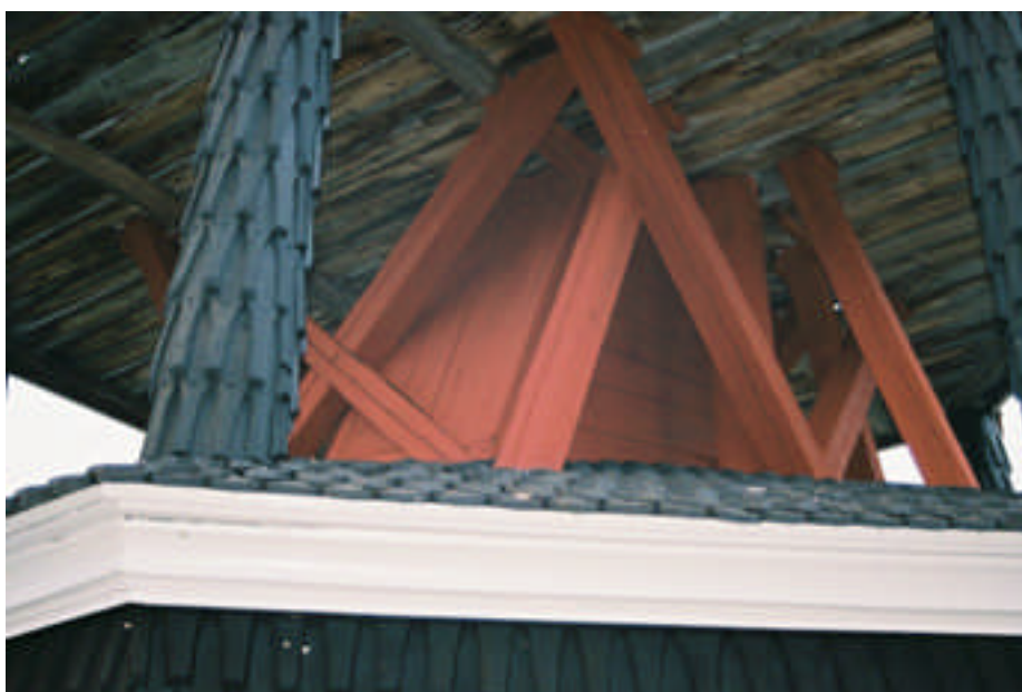
Kryssträvor och spånklädda stolpar ovan klockboden (bild nr 09m037/10).
