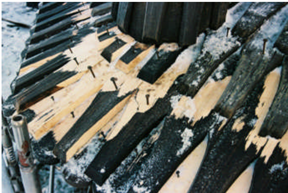
Spånen i hörnen har huggits till för hand (bild nr 08m057/13).
