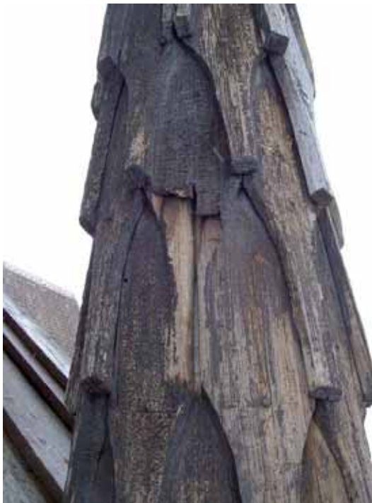
En av de spånklädda stolparna som bär upp klockvåningen och taket. På spånen syns en mörkfärgad tjära ytterst.
