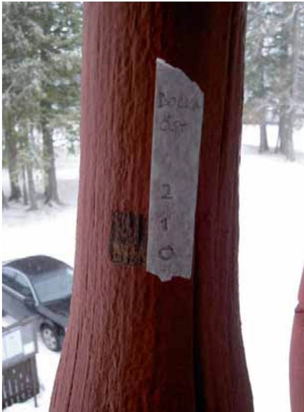
Färgstege på en balusterdocka mot öster. Det fanns inga spår av att tjäran på balusterdockorna hade varit färgad med rött pigment.
