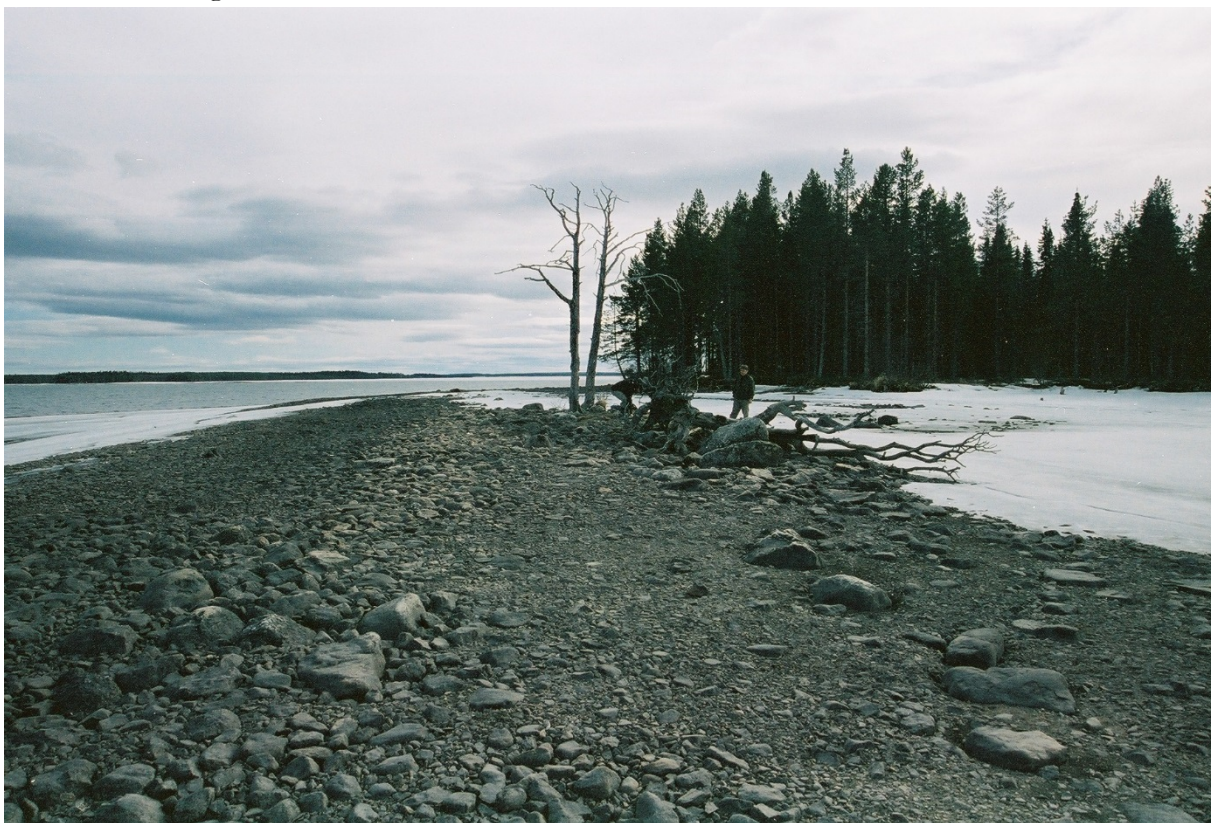
Anläggningen centralt i bild. Bilden tagen mot S vid besiktningstillfället 2007.
