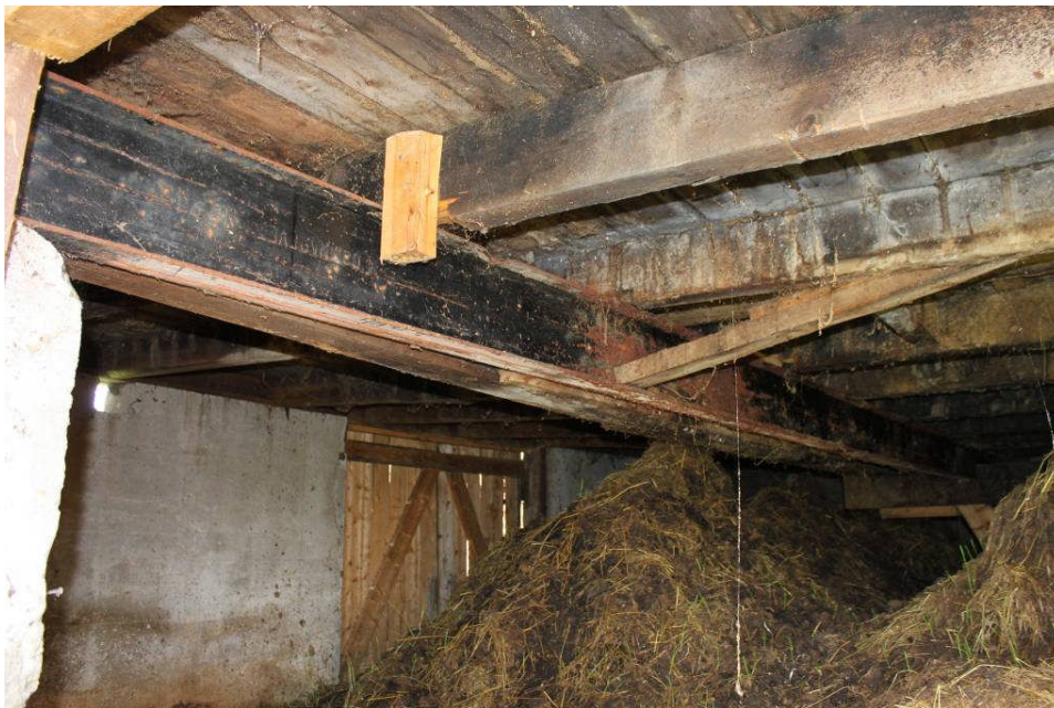
24. Järnbalk under fjösgrå som bär bärlinor i AC-riktning.
