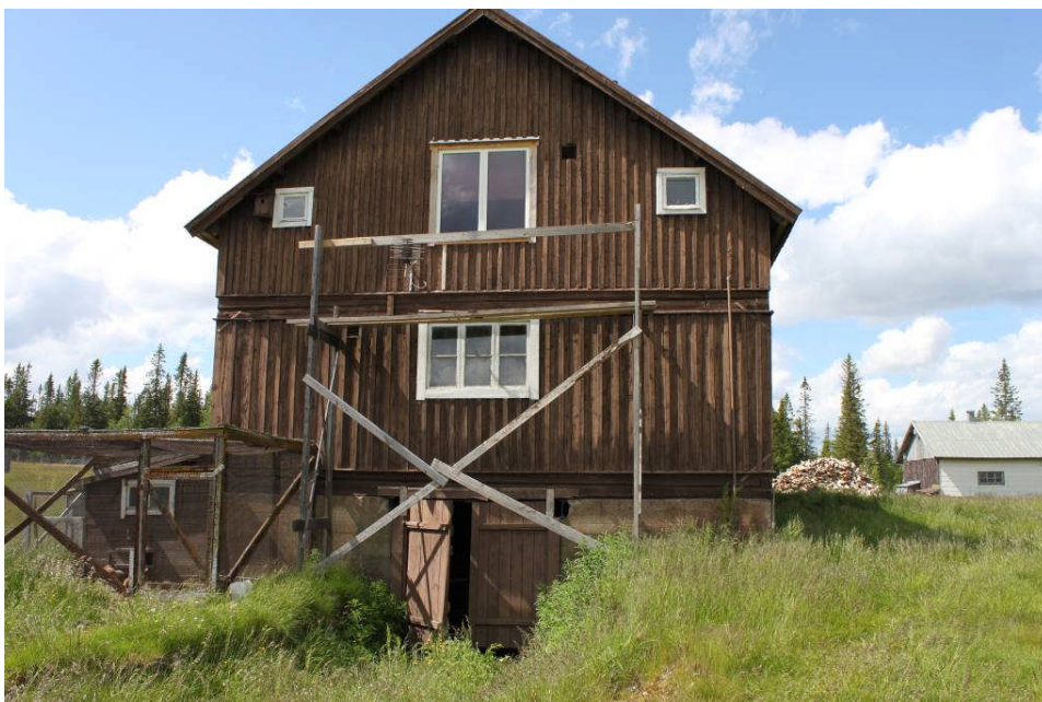
9. B-vägg. Övre våningens mittfönster är fjöskammarens fönster. Dubbelportarna i grunden leder till gödselkammaren belägen under fjösgolvet.
