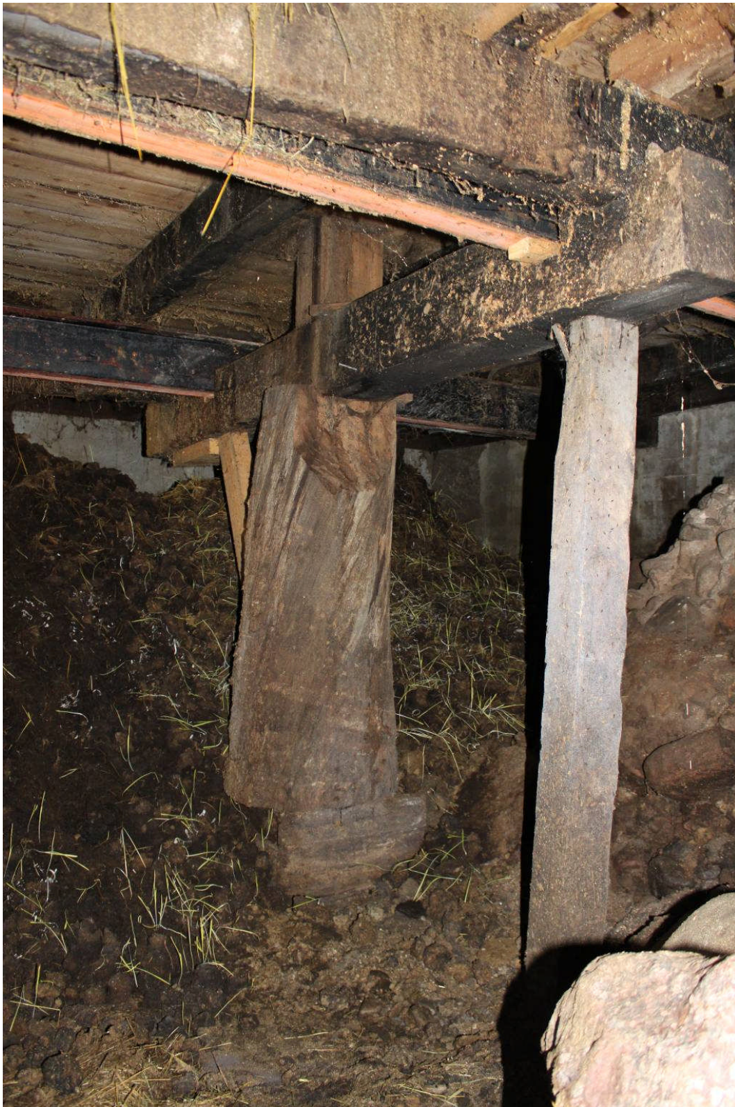
28. Konstruktionen under fjösgolvet som bär upp två bjälklag.
