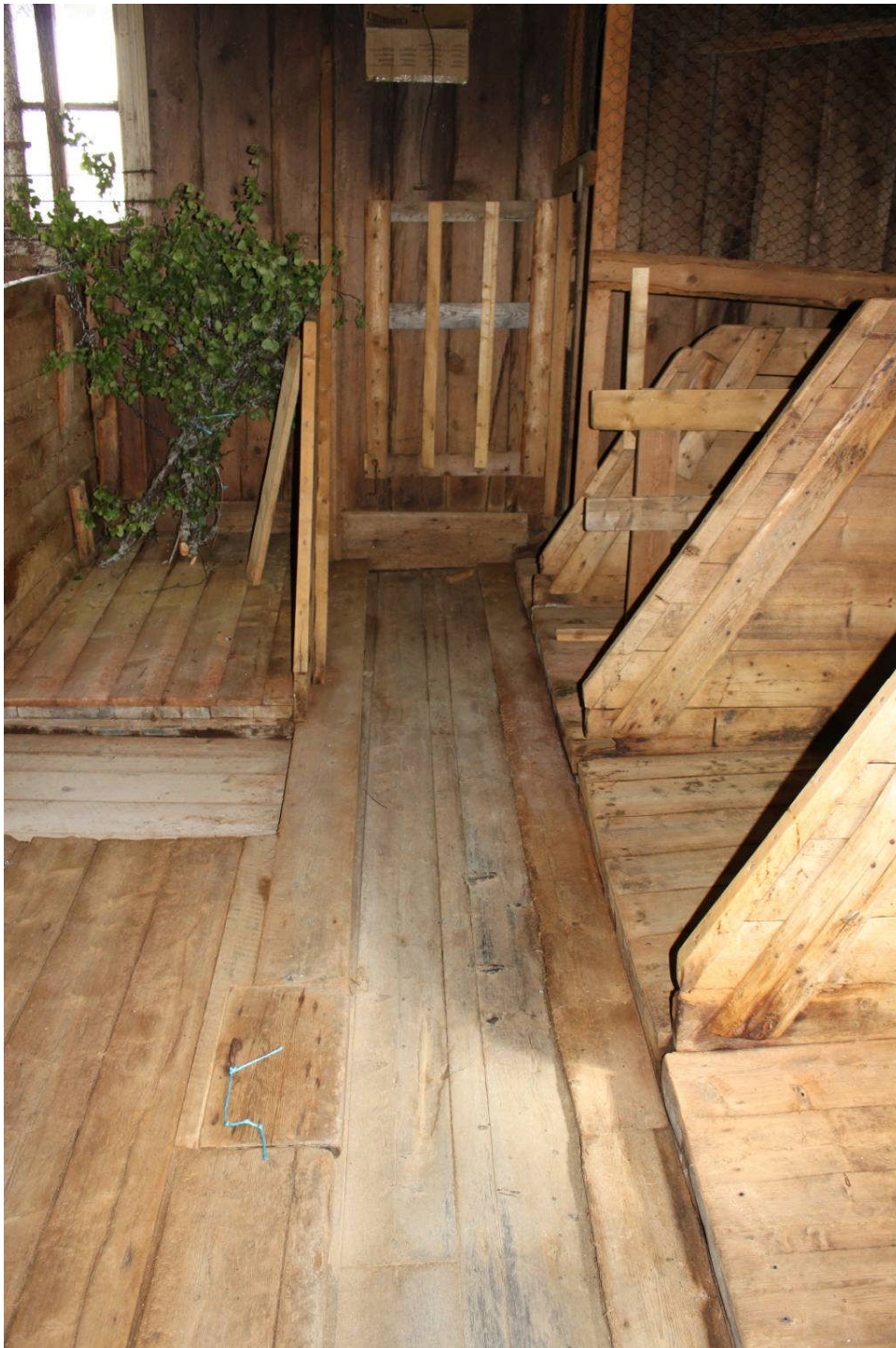
21. Gödselränna som går utefter bås mot C-vägg. Gödsellucka med blått snöre.
