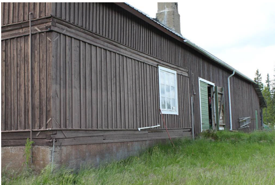
6. Vinterfjösset AB-hörn och A-vägg.
