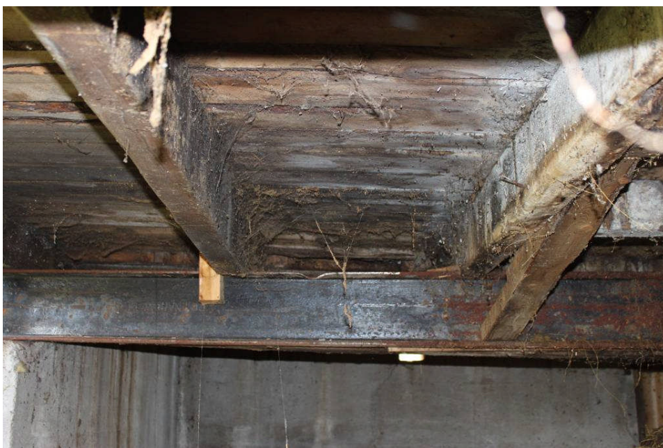
25. Bärlinor och järnbalk under fjösgrå.
