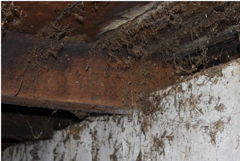
26. Bärlinor som vilar på den gjutna grunden.
