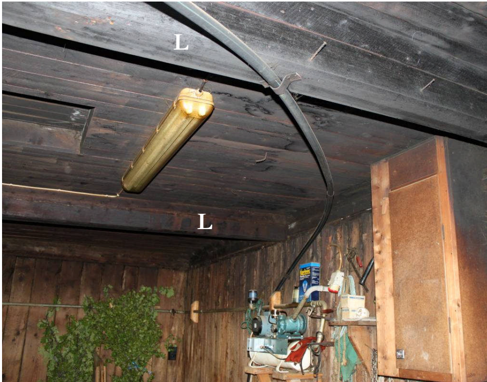
3. Bärlinorna som bär upp fjöskammarens golvbjälklag.
