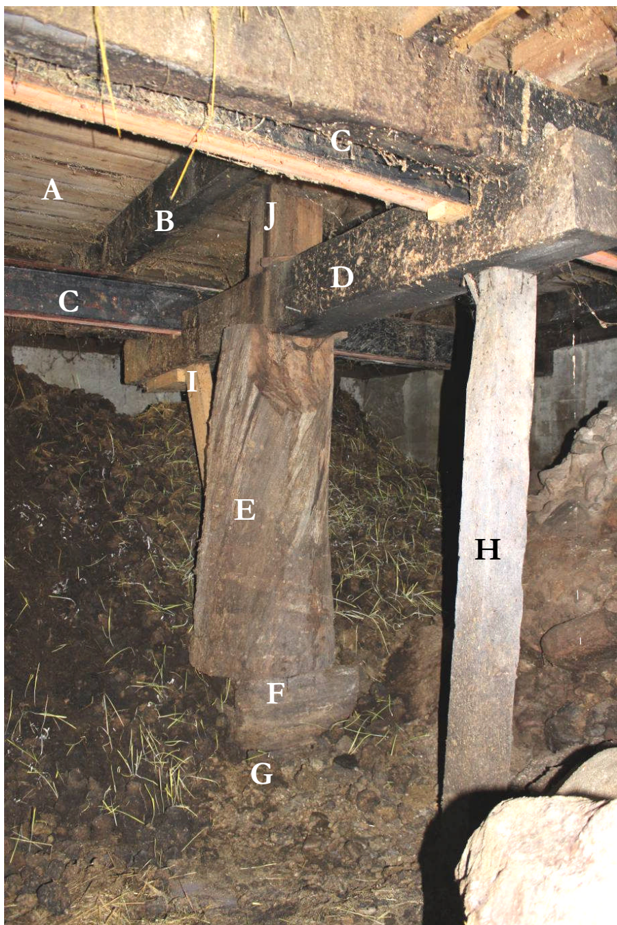
1. Konstruktionen som bär fjösets golvbjälklag.
