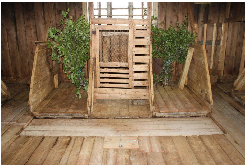
20. Bås vid B- vägg för ungdjur samt höns. Gödselränna och gödsellucka med blått snöre.
