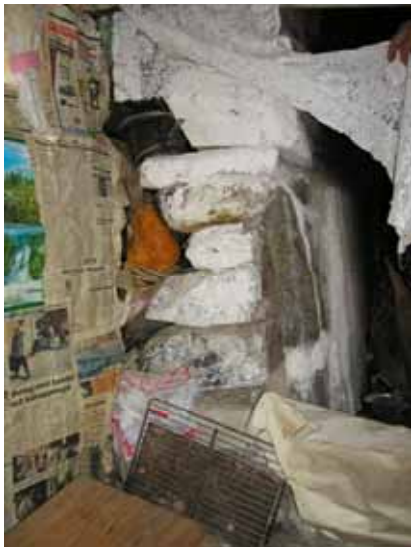
Figur 10. Luftspalten mellan väggen och spismuren i Lockåsbodarna.
