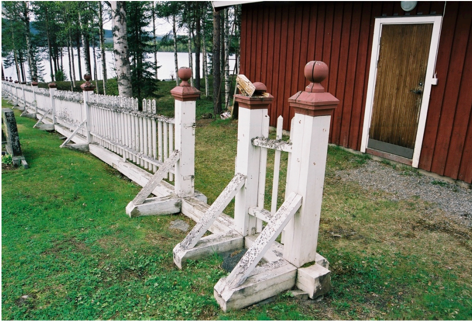
Detaljbild av staketet som fanns från tidigt 1980-tal till 2012. Foto från upprättandet av förvaltningsplan, 2005.
