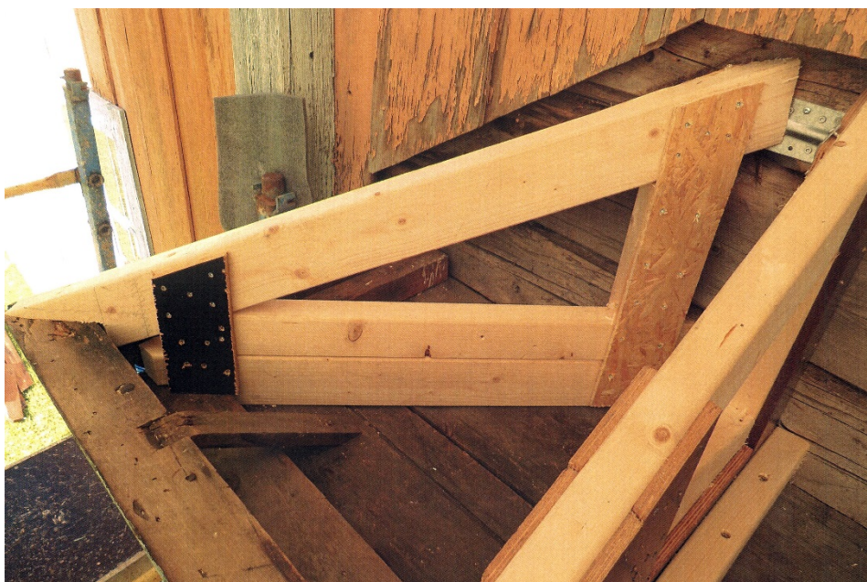
Figur 7 Den nya takkonstruktionen med extra stöd.
