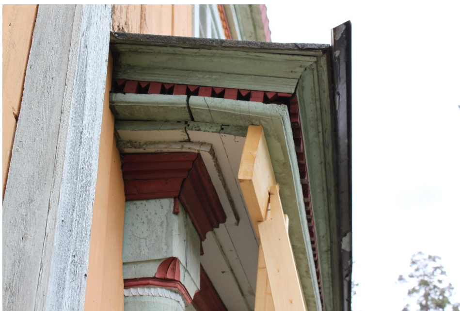
Figur 2 Krönet med stöttor för att inte ramla ner.
