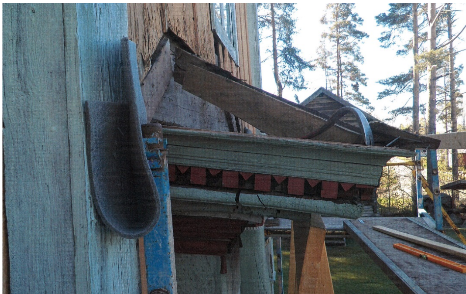
4 Taket över krönet efter att papp och takbrädor tagits bort.
