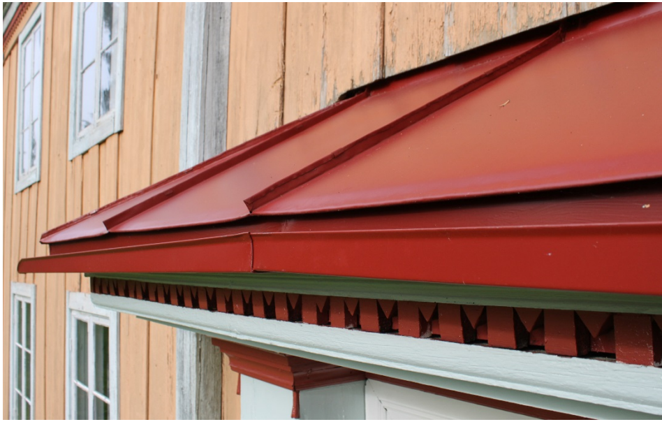
Figur 8 Den nya plåttäckningen.
