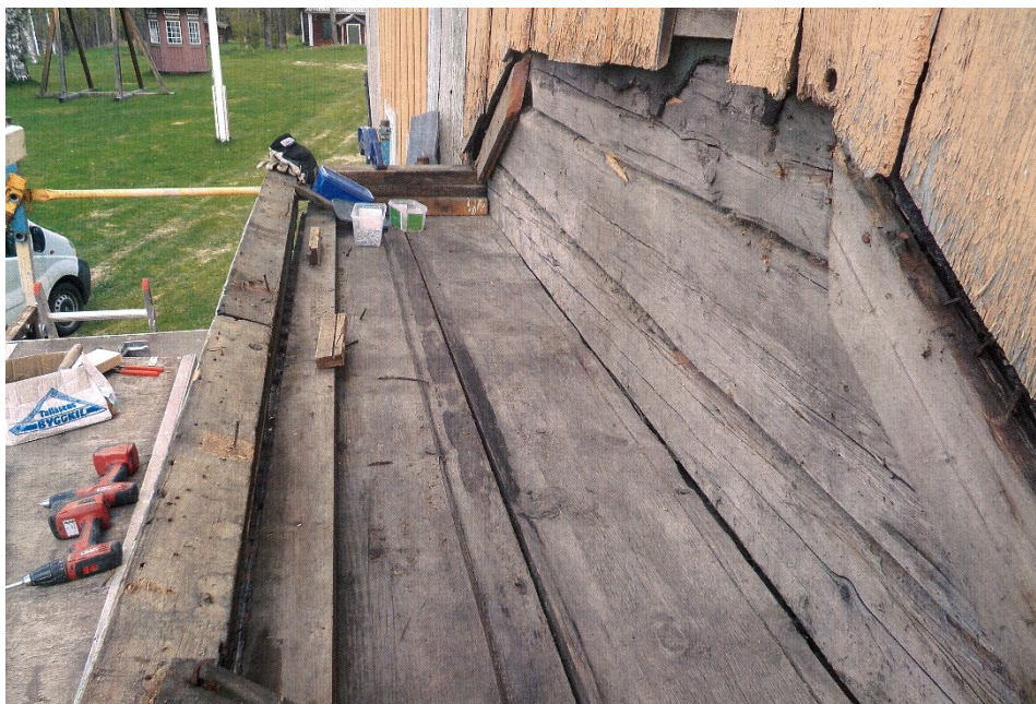
Figur 6 Ovansidan av krönet efter att taket plockats bort.
