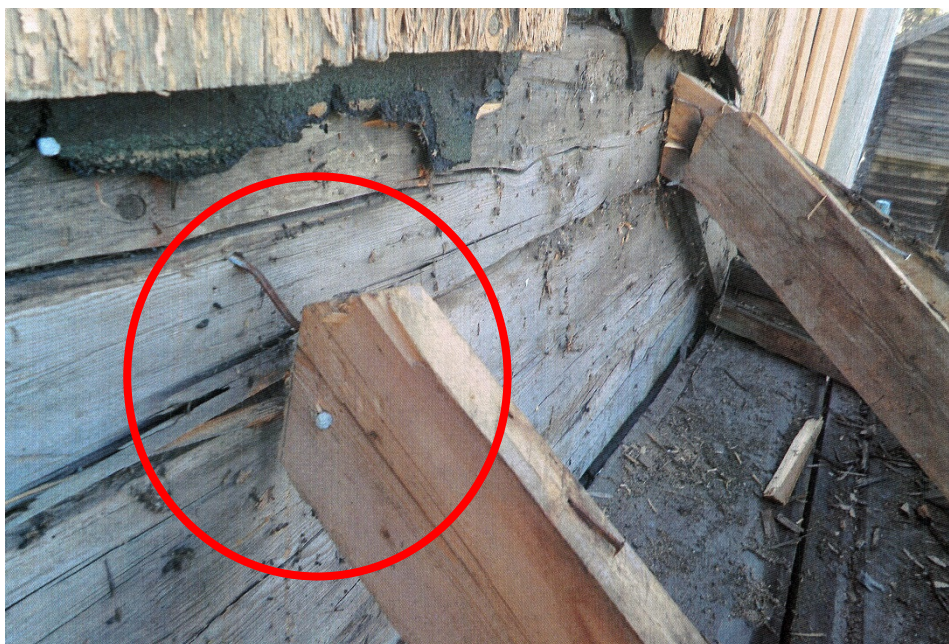
5 Taket hängde nätt och jämt kvar i spikarna.
