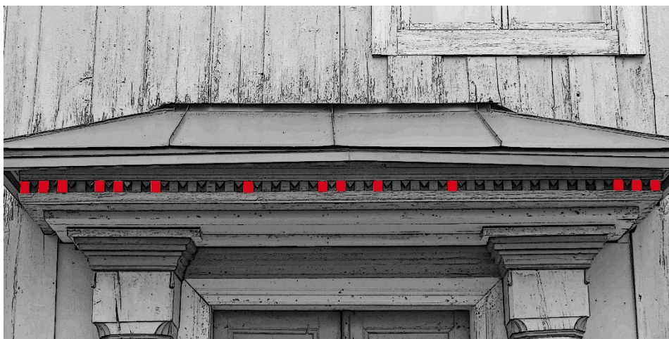
Figur 3 Tandsnittsdekoren med nya tänder markerade i rött.
