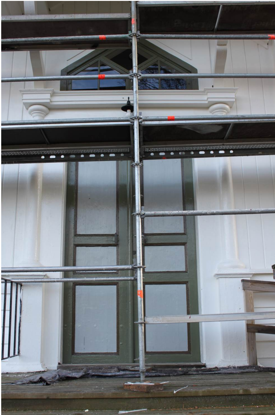
Figur 4 Entrén efter åtgärd.
