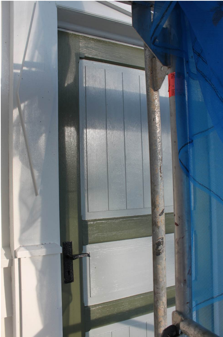
Figur 6 Dörr till sakristian efter åtgärd.
