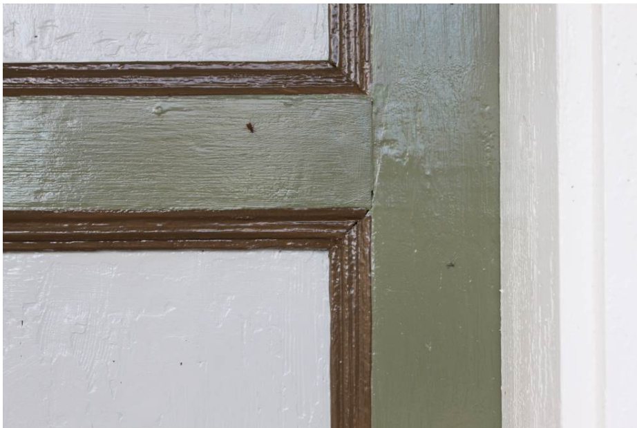
Figur 3 Entrédörr efter åtgärd.
