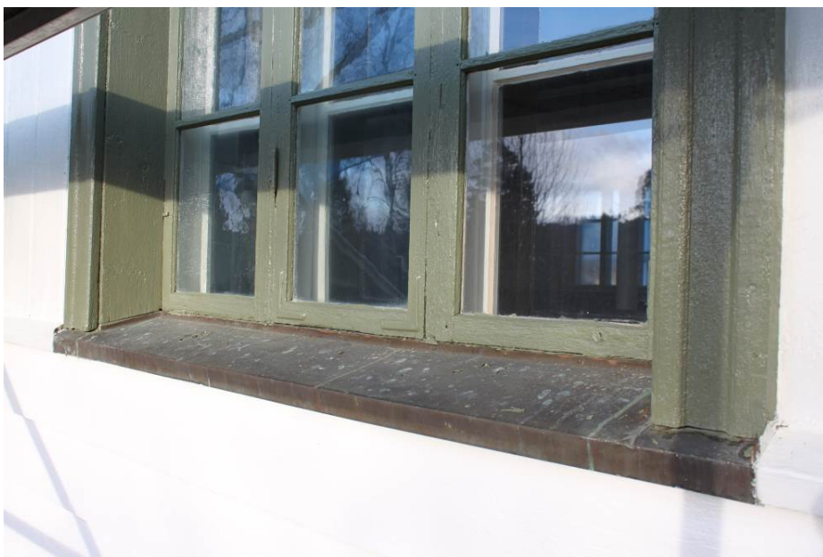
Figur 8 Fönster efter åtgärd.
