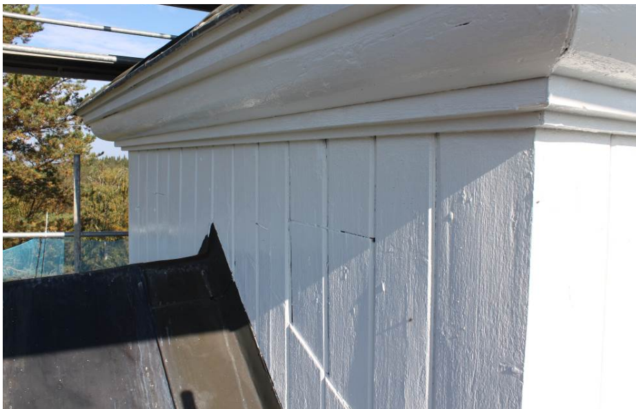
Figur 1 Även efter målning kan man ana den ojämna, väderbitna träytan under färgen upptill på tornet.
