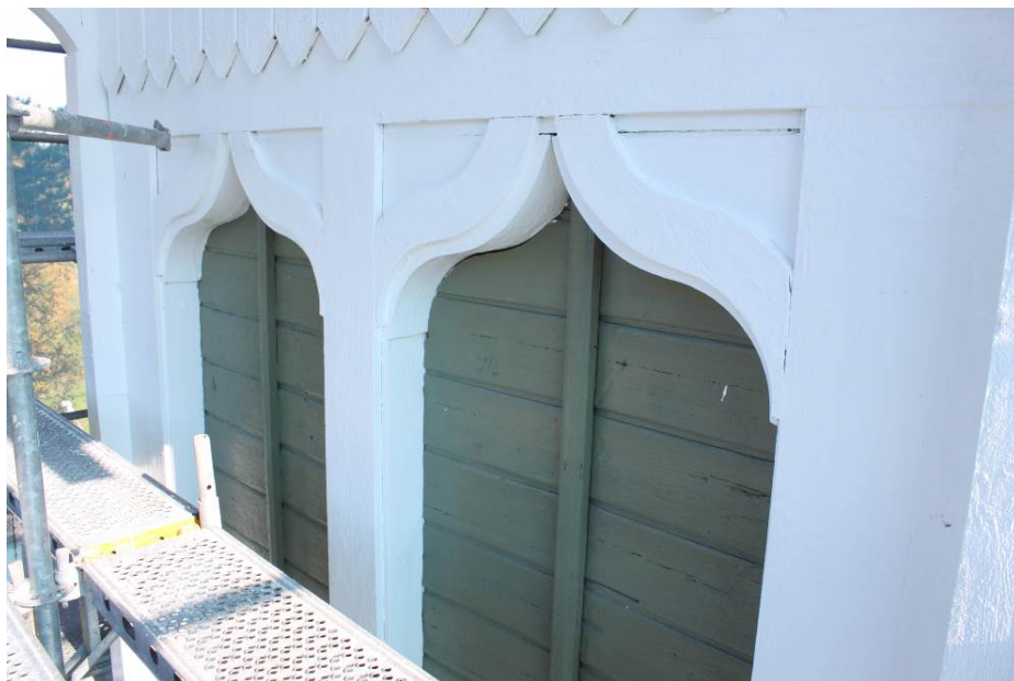
Figur 9 Luckorna på tornet är målade i fönsterkulören.
