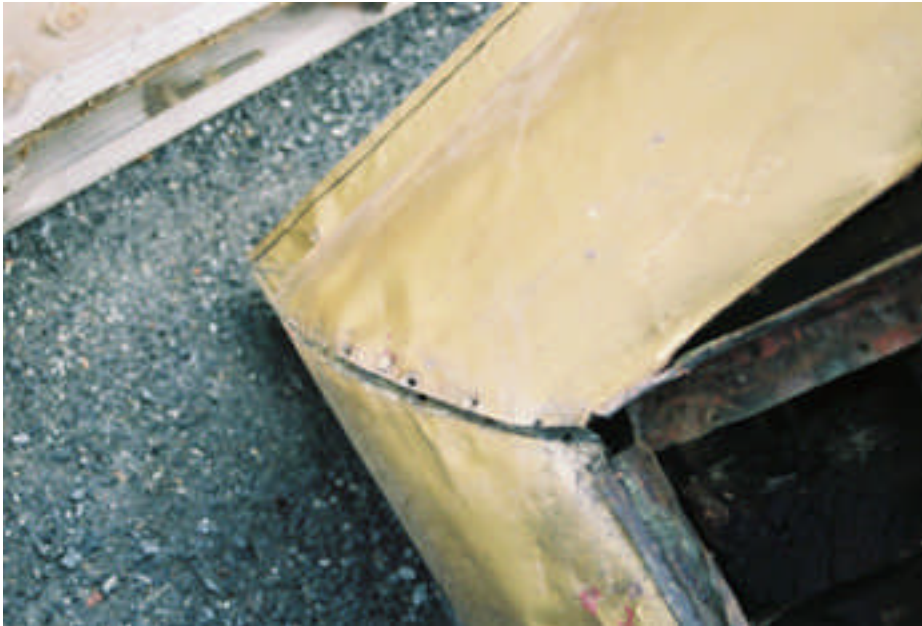
Bild 6: Korsglobens plåtintäckning innan restaurering.
