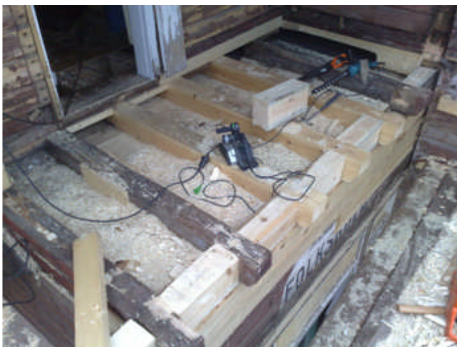
Flera golvåsar i balkongen byttes ut och även tre timmerstockar under räcket (foto Bertil Andersson 200905261228).
