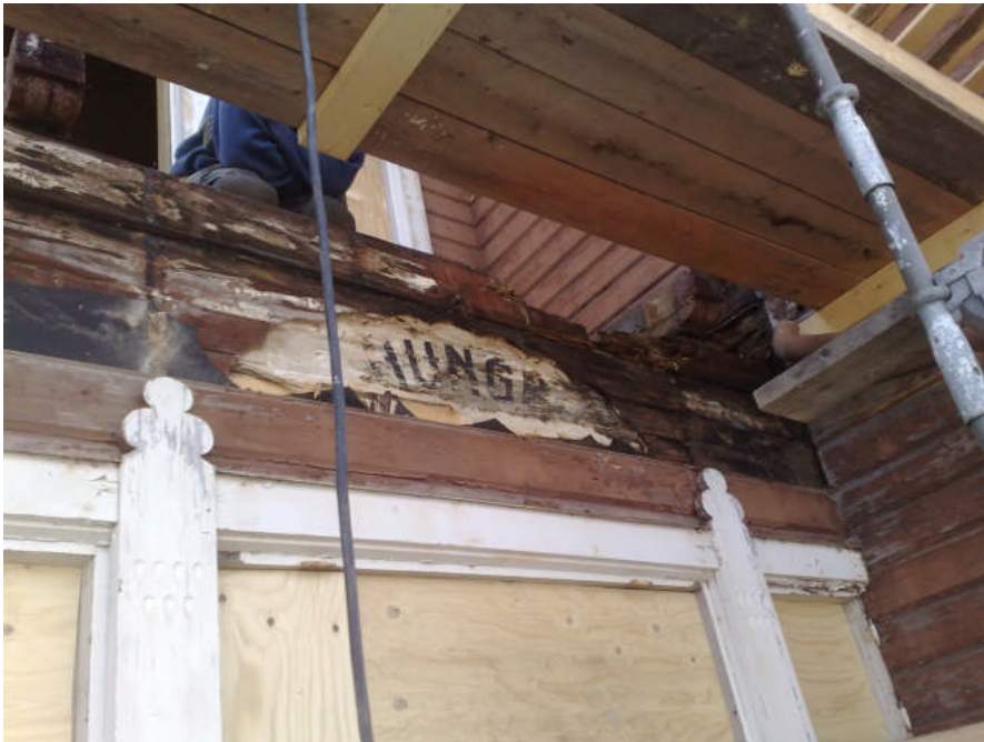
När panelen ovan dörren demonterades kom den gamla skylten fram (foto Bertil Andersson 200904231064).
