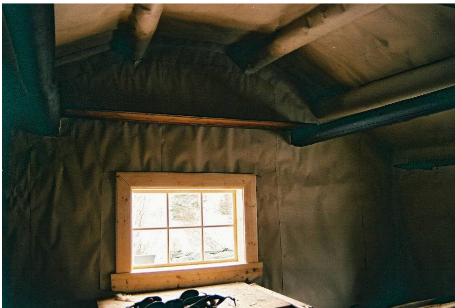
Bild 18. Ny papp och fönsterfoder till de nya fönstren sattes upp (neg nr 08M056/14).
