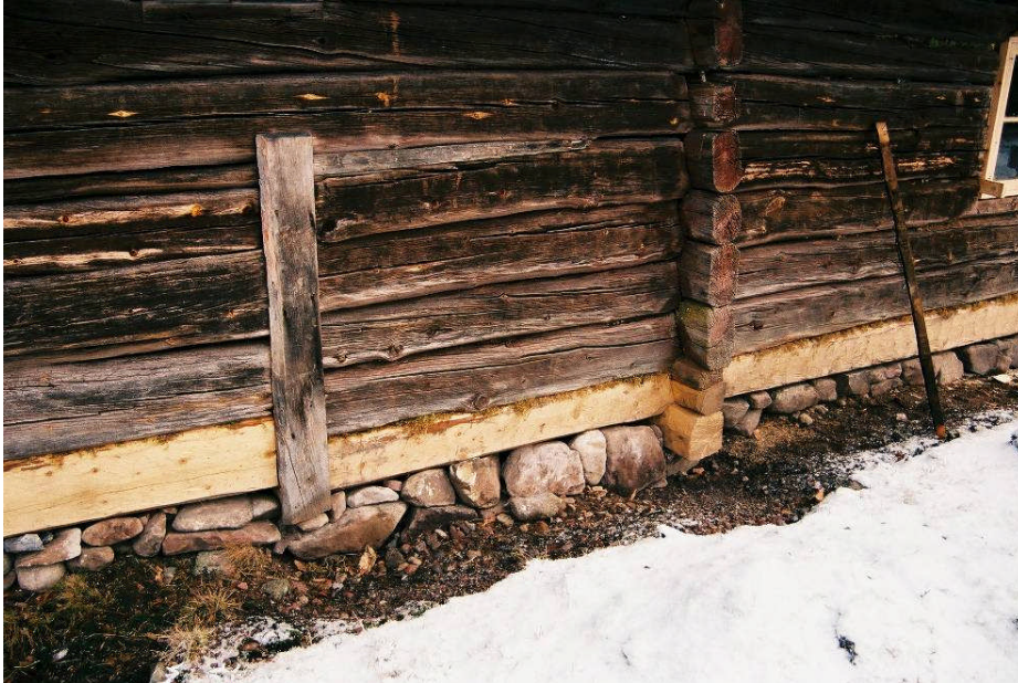
Bild 15. Lagningar på D-vägg. Här syns även A-väggens lagningar (neg nr 08M056/20).
