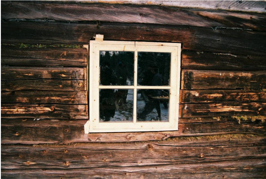
Bild 16. Nyttillverkat fönster på D-vägg (neg nr 08M056/22).
