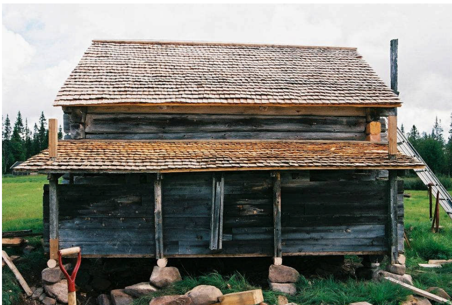
Bild 9. Hela ladans tak lades om med nytt spån (neg nr 08M036/17).
