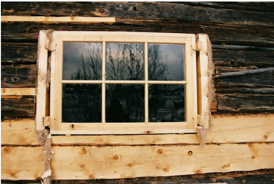
Bild 17. Nyttillverkat fönster på C-vägg (neg nr 08M056/23).
