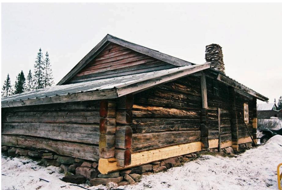
Bild 14. Utbytta stockar på D-vägg och källare (neg nr 08M056/18).
