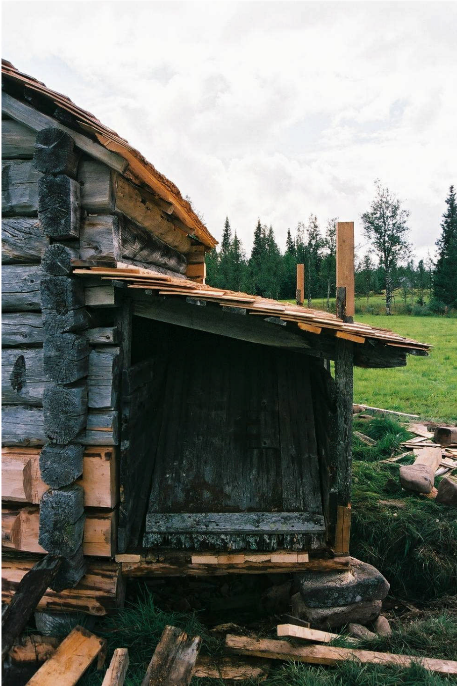
Bild 7. Rävfällan sedd från vägg A. Här syns också de halvade stolparna ovan taket, vilka nu har tagits bort (neg nr 08M036/28).
