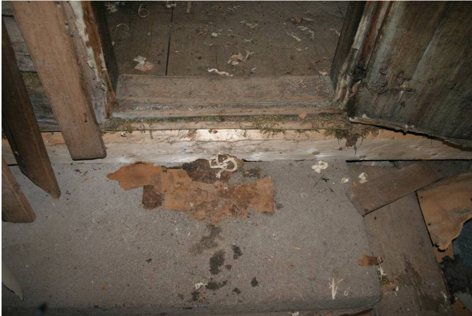
Bild 12. Trappsteget har kapats mot A- och B-vägg (digital pict 1734)
