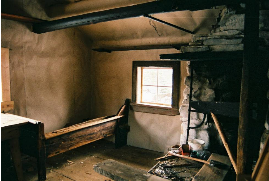
Bild 19. De nya fönsterfodren tillverkades med fodret på D-vägg som förlaga (neg nr 08M056/17).
