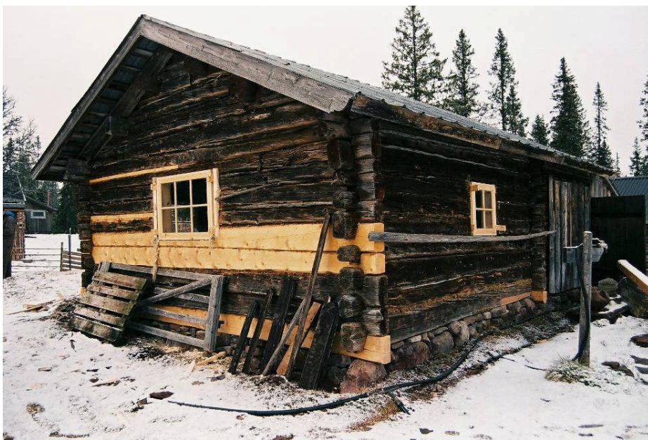
Bild 13. Utbytta stockar och lagningar på B- och C-vägg (neg nr 08M056/06).
