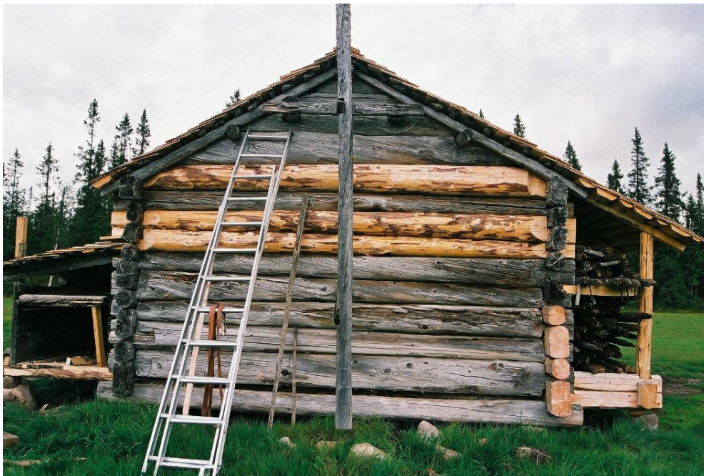
Bild 5. C-vägg (neg nr 08M036/25).
